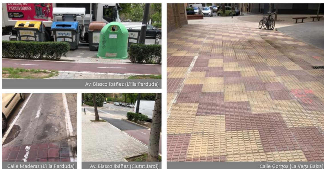
Figura 66. Falta de señalización horizontal en carriles bici de Algirós. Fuente: Propia.
