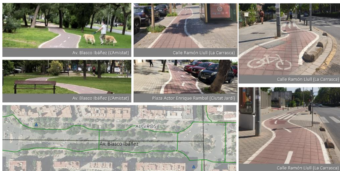
Figura 62. Trazado inadecuado en carriles bici de Algirós. Fuente: Propia
