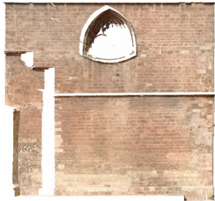
Figura 7.31: Nube de puntos de la superficie de estudio de la Capilla Santo del Cáliz (elaboración propia).
