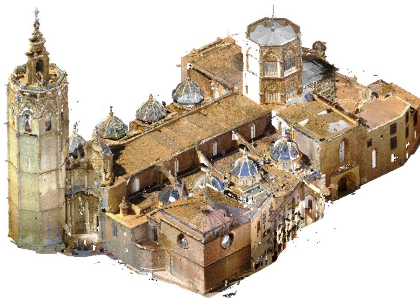
Figura 7.2: Nube de puntos de la Catedral de Valencia con un espaciado de puntos de 5 mm (elaboración propia).
