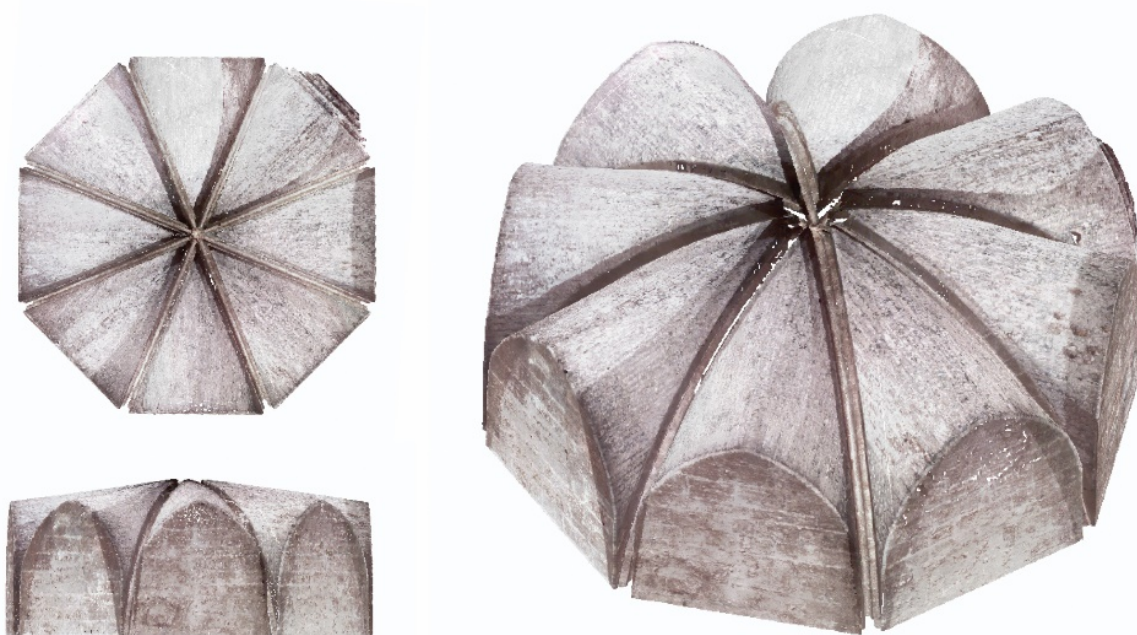
Figura 7.20: Nube de puntos de 7.085.550 puntos de la bóveda de la Sacristía Mayor de la Catedral de Valencia (elaboración propia).
