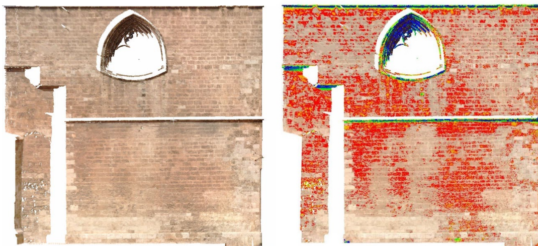
Figura 7.34: Distribución de los cromatismos en la nube de puntos de la muestra (elaboración propia).
