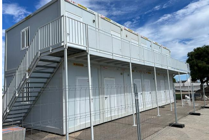
Figura 7. Instalaciones temporales para la obra. (Cabisuar, 2025)
