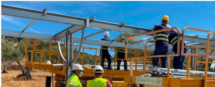
Figura 9. Montaje de estructuras y paneles. (Greening, 2025)
