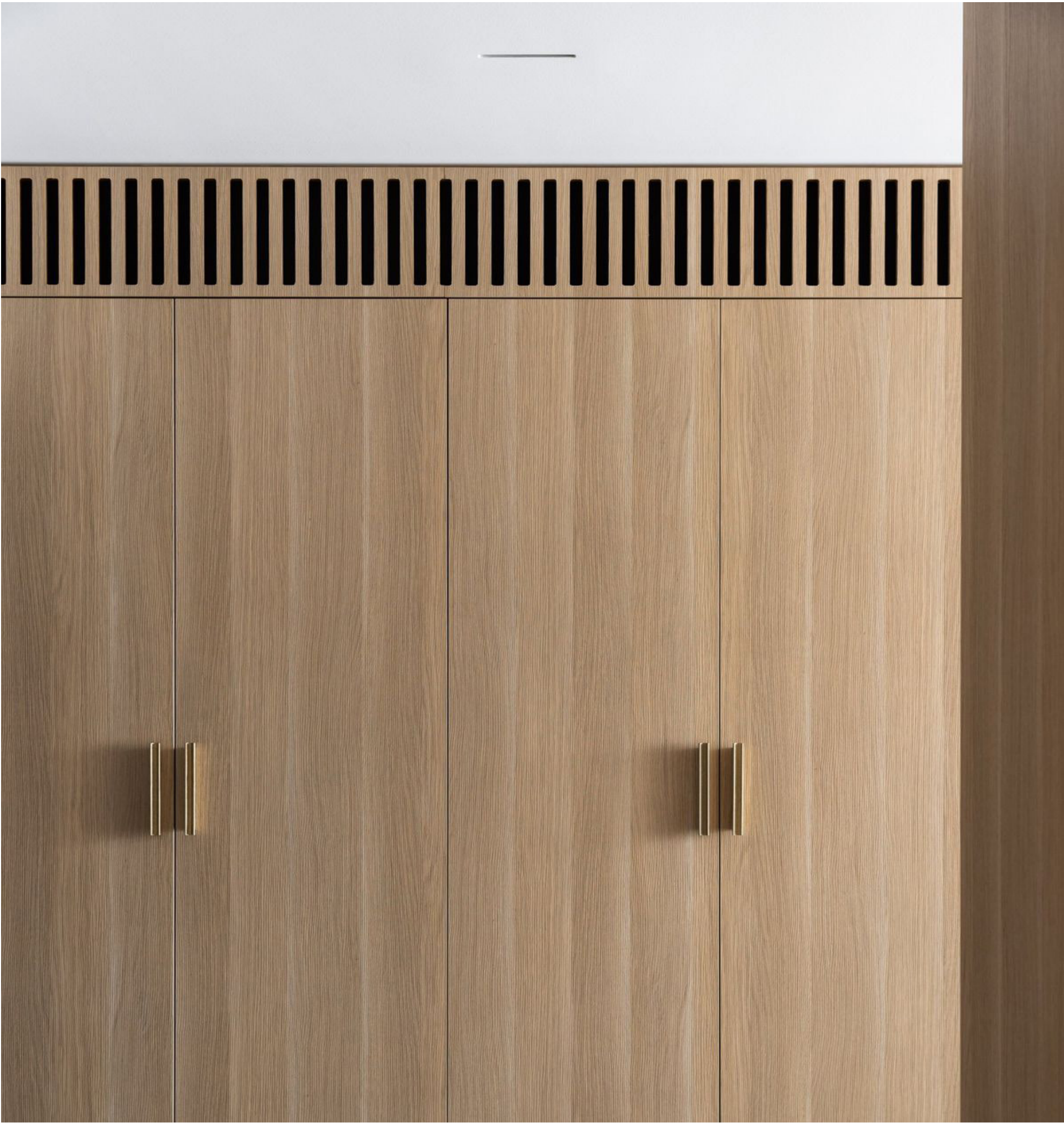
Fig 51. Inspiración falseado armarios para la ventilación
