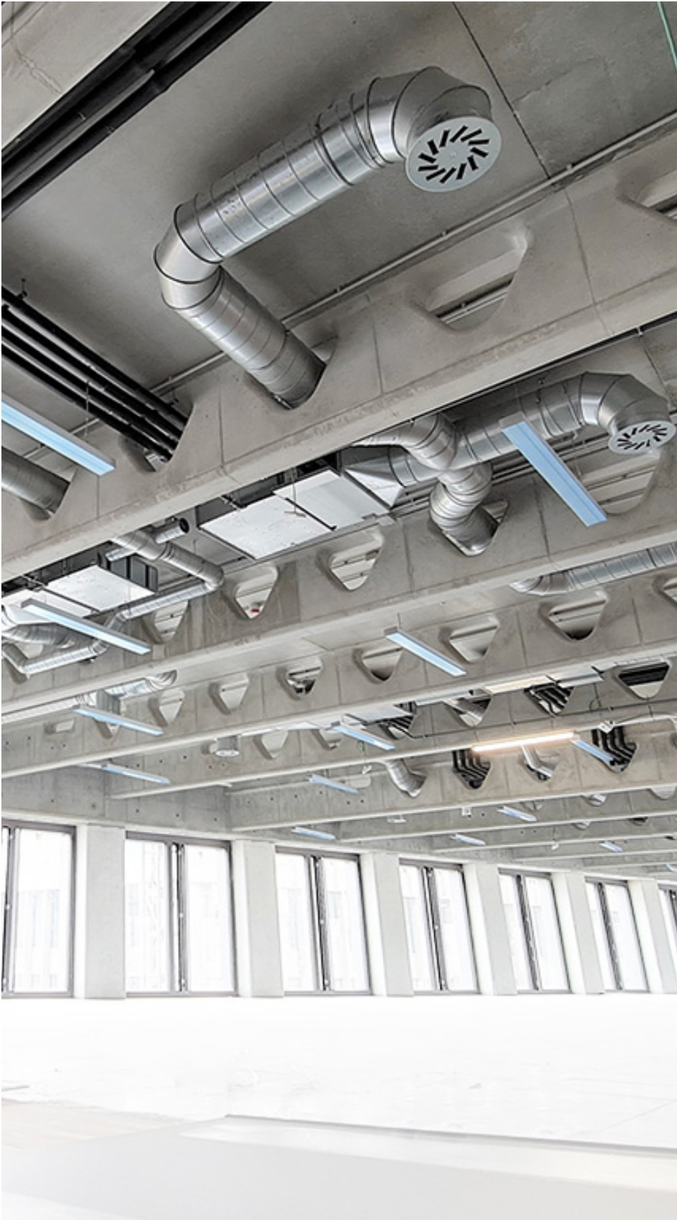
Fig 33. Ejemplo de forjado tipo Holedeck
