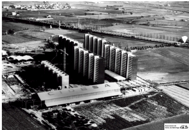
Figura 6. Vista de la planta de prefabricación pesada a pie de obra de CIDESA (Bellvitge, 1964).
