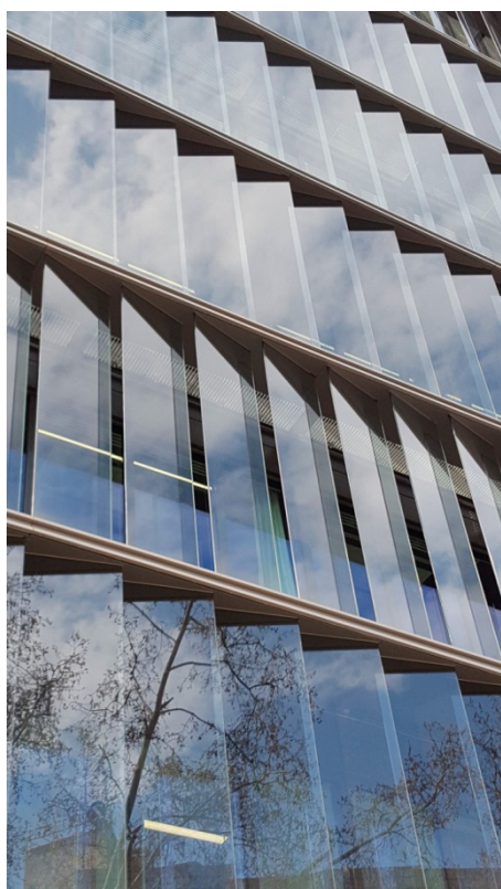
Figura 12. Vista de detalle de la fachada de la sede para CAMPB (1968-72, 2024).
