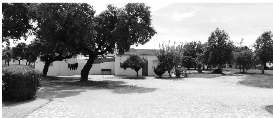
Fig. 1 La apariencia de vivienda aislada de una unidad habitacional en testero y la transición entre espacio pavimentado y espacio natural. Fuente: Imagen propia
