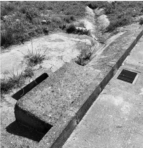
Fig. 5 Intervención para la evacuación de agua en el límite a menor cota y en esquina de una de las zonas adheridas con topografía pronunciada. Fuente: Imagen propia
