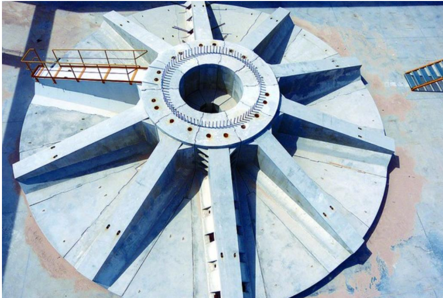
Figura 11. Cimentación prefabricada. Fuente: [16].
