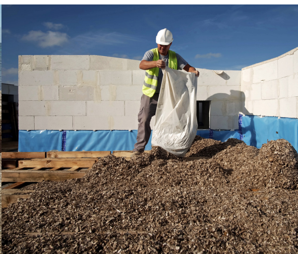
Il·lustració 39: Posidonia oceànica col·locada a la coberta. Font: Web Life Refusing Posidonia
