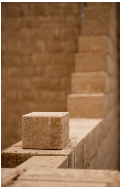
Il·lustració 40: Murs de BTC al projectes Raw Rooms. Peris i Toral. Foto: Txema Salvans
