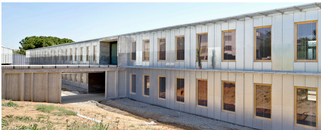
Il·lustració 29: 57 Habitatges Universitaris al Campus de l'ETSAV. HARquitectes i DATAAE. Foto: Adrià Goula
