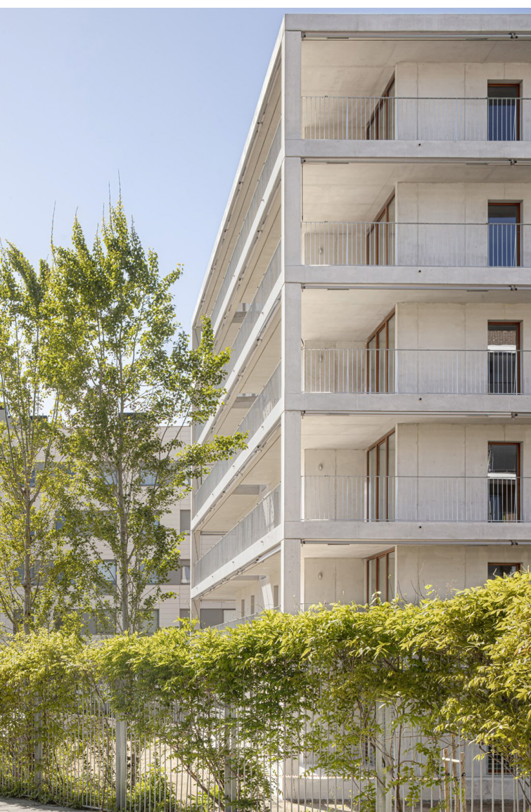
Il·lustració 44: 30 Habitatges de Protecció Oficial a Sant Just Desvern. DATAAE + Xavier Vendrell. Foto: Adrià Goula.
