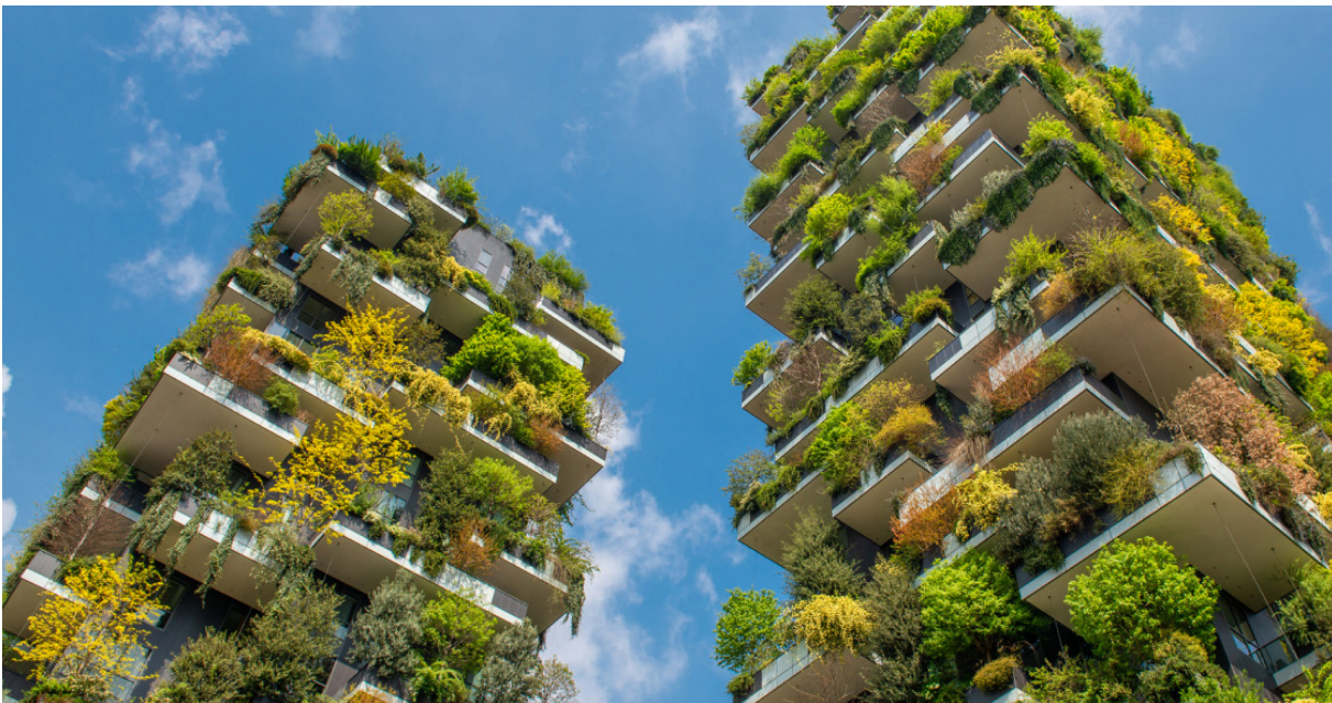
Il·lustració 6: Vista exterior Torres Bosco Verticale. Stefano Boeri Architetti. Font: ArchDaily.
