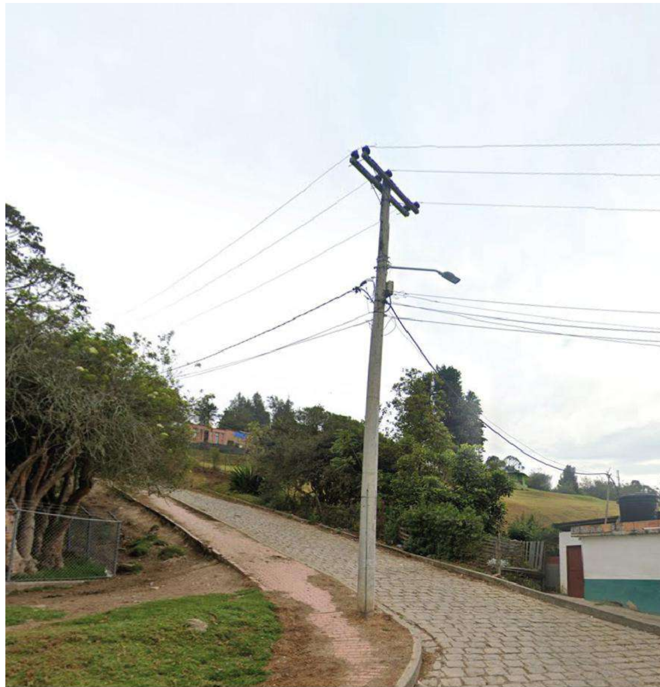
Imagen 19: Estado actual vía rural
