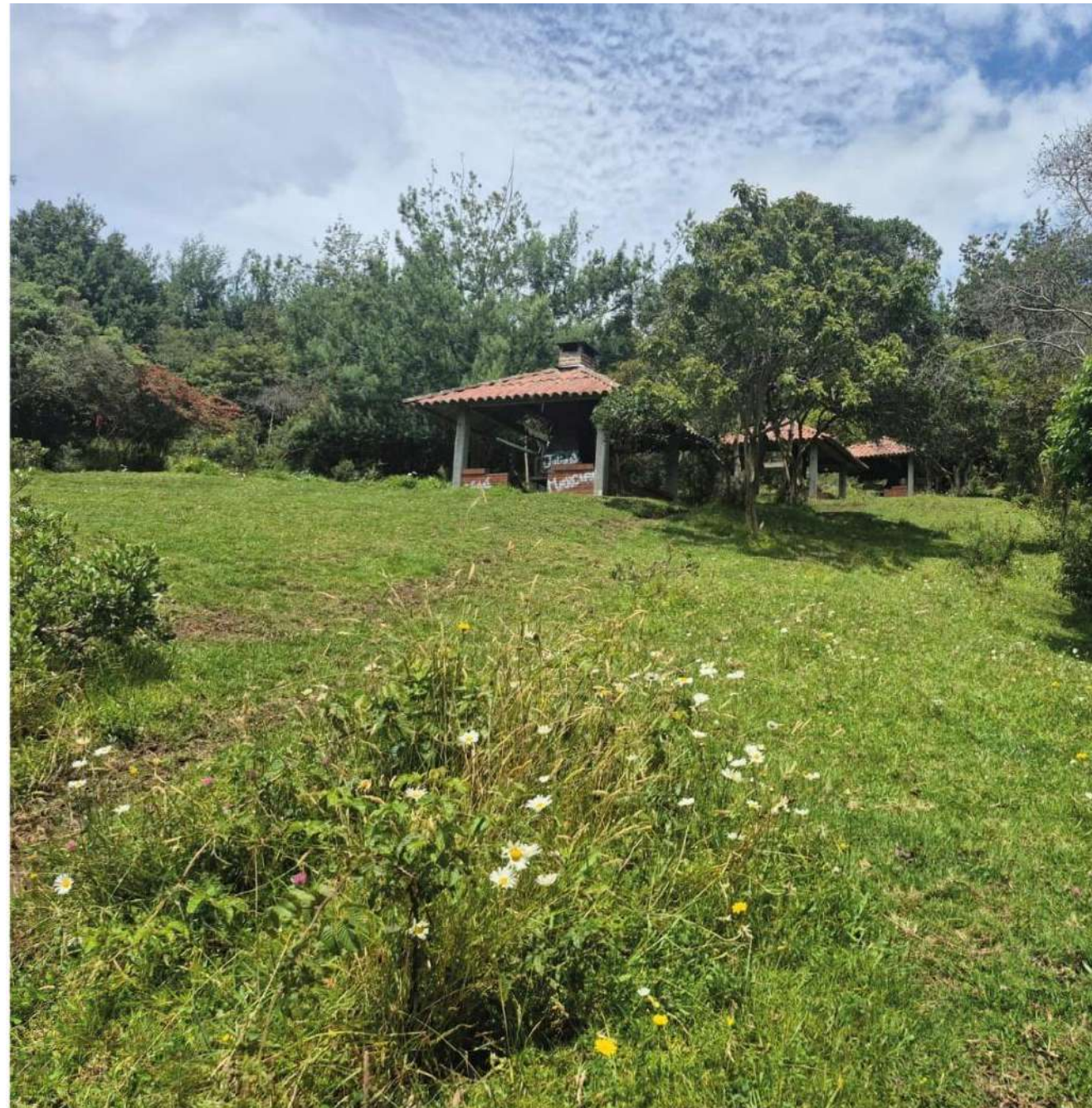
Imagen 15: Estado actual casetas
