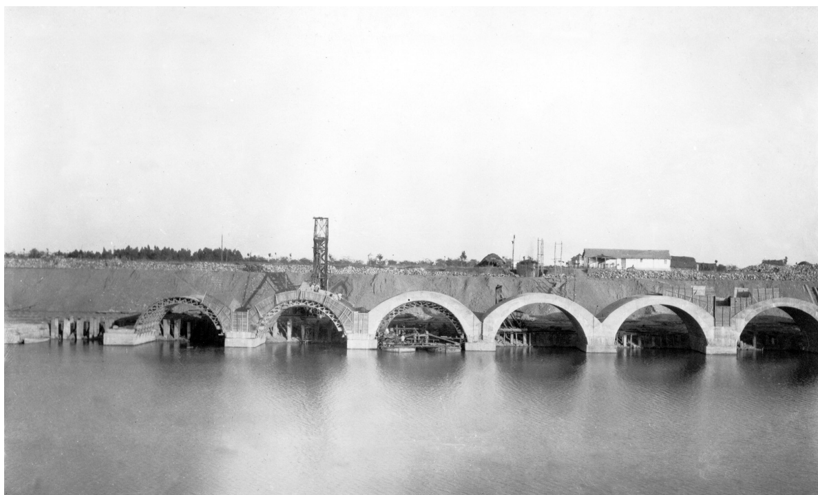
Figura 7. Obras de excavación del canal de Alfonso XIII, construcción del muelle de Tablada y ensanche de la margen derecha. Archivo de la Autoridad Portuaria de Sevilla. PS00404.
