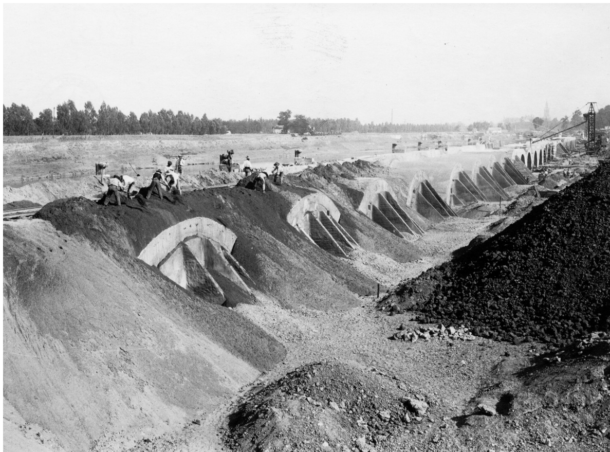
Figura 8. Obras de excavación del canal de Alfonso XIII, construcción del muelle de Tablada y ensanche de la margen derecha. Archivo de la Autoridad Portuaria de Sevilla. PS00413.
