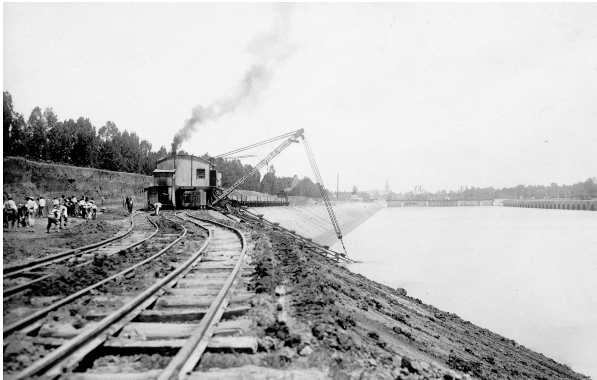
Figura 9. Obras de excavación del canal de Alfonso XIII, construcción del muelle de Tablada y ensanche de la margen derecha. Archivo de la Autoridad Portuaria de Sevilla. PS00419.
