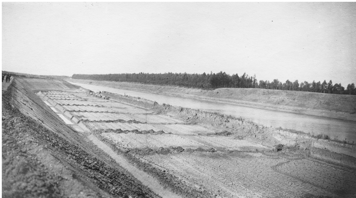
Figura 6. Obras de excavación del canal de Alfonso XIII, construcción del muelle de Tablada y ensanche de la margen derecha. Archivo de la Autoridad Portuaria de Sevilla. PS00363.
