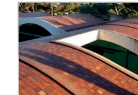
Bóveda cerámica rebajada de ladrillo rojizo
