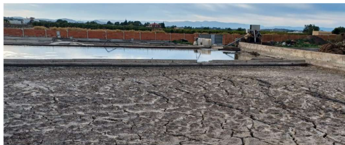
Figura 23. Balsas de decantación. Fuente: Elaboración propia.
