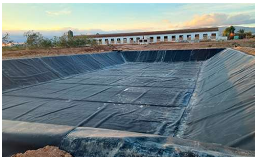
Figura 7. Balsa para el almacenamiento de purines. Fuente: Ministerio de agricultura, alimentación y medio ambiente, 2015.
