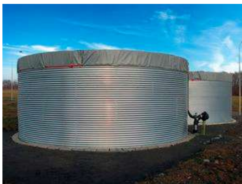
Figura 6. Tanque para el almacenamiento de purines. Fuente: Ministerio de agricultura, alimentación y medio ambiente, 2015.
