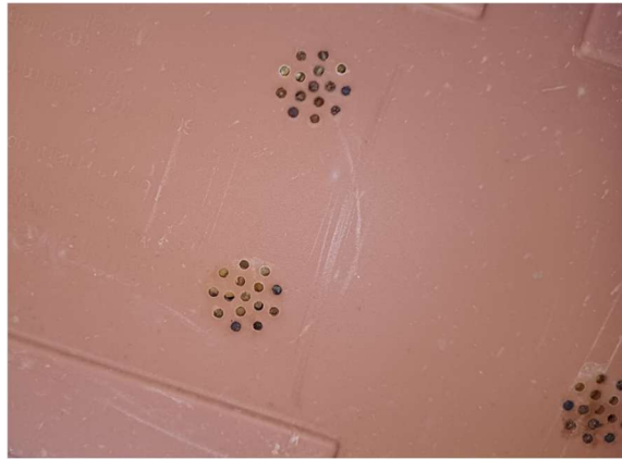
Figura 25. Agujeros de drenaje. Fuente: Elaboración propia.
