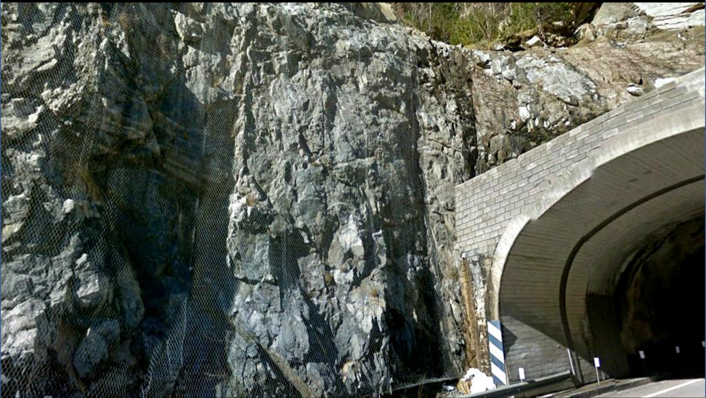
Mallazo en las calizas del Devónico Inf., en la zona de cerrada del Embalse de Baserca en el Noguera Ribagorzana, Entre Huesca, y Lleida. E Hoja de Benasque.
