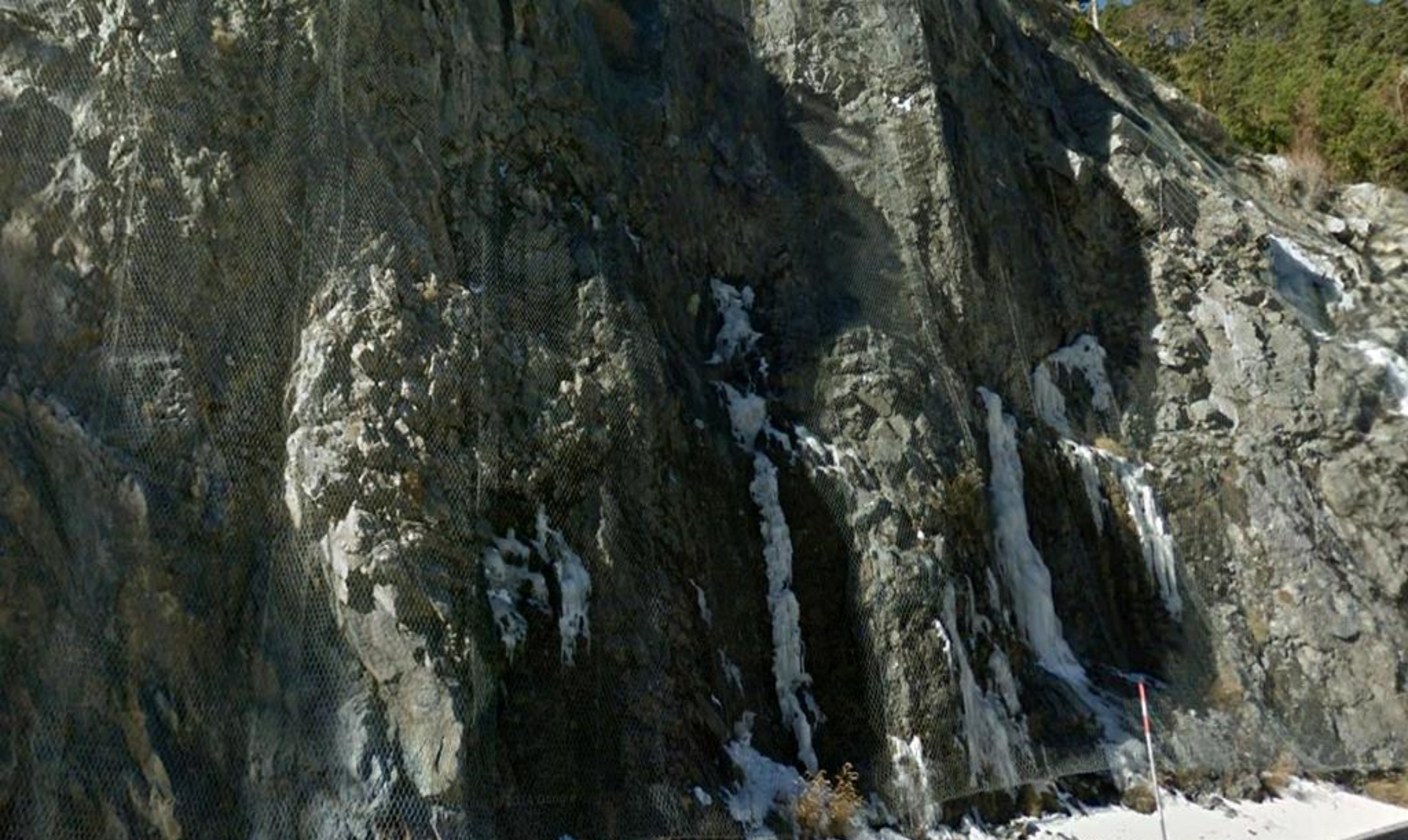
Mallazo en las calizas del Devónico Inf., con surgencias congeladas, en la zona de cerrada del Embalse de Baserca en el Noguera Ribagorzana, Entre Huesca, y Lleida. E Hoja de Benasque.
