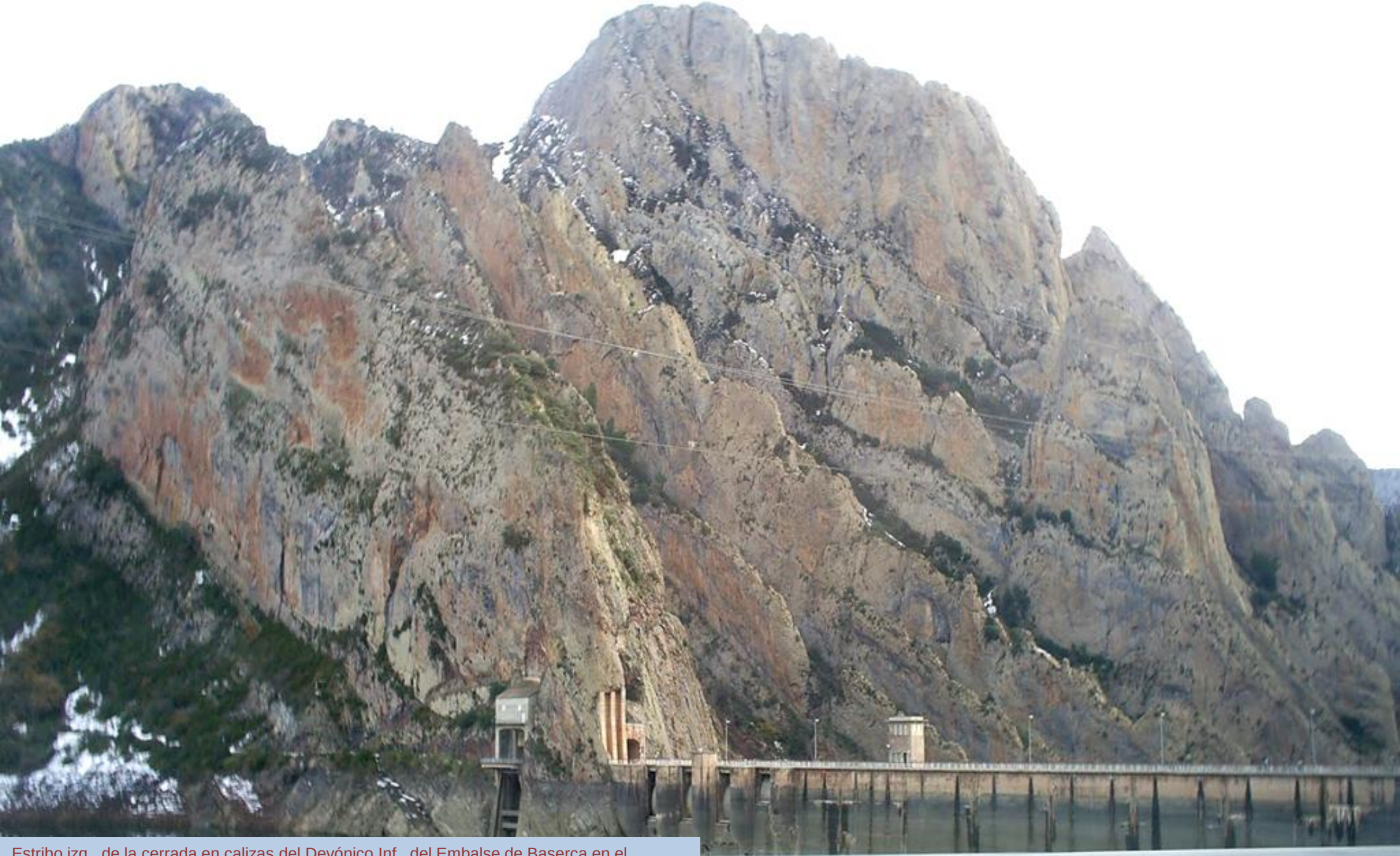
Estribo izq., de la cerrada en calizas del Devónico Inf., del Embalse de Baserca en el Noguera Ribagorzana, Entre Huesca y Lleida. E Hoja de Benasque. (por Rub851-Google)
