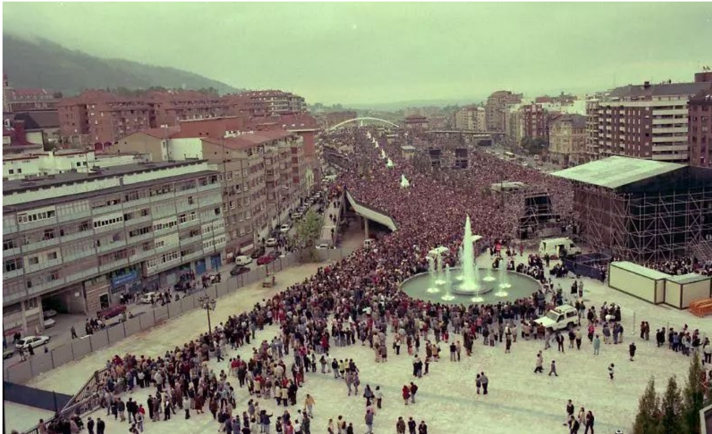
Figura 2.4. Inauguración de la nueva losa sobre el trazado ferroviario en Oviedo en 1999 (Fuente: Chus Neira, LNE).
