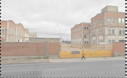
Entorno del cuartel y fábricas de Farnesio (Barrio de las delicias). Este complejo urbanístico en desuso supone una gran mancha infranqueable en la ciudad, sumada al efecto barrera de las propias vías del tren
