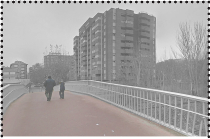
Pasarela Diviro Maestro (Centro Oeste, San Adrián). Perteneciente a la fase 2 de integración, las pasarelas y muros permeabilizan y consolidan la vía del ferrocarril.
