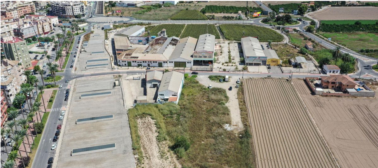
Figura 4.1.12. Vista de la losa de hormigón que cubre el soterramiento del ferrocarril en Orihuela, un caso de desaprovechamiento del espacio recuperado y en el que otras soluciones habrían resultado más atractivas (Fuente: Tony Sevilla, Diario Información).
