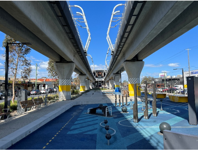
Figura 4.3.24. Trazado elevado del SkyRail en el norte de Melbourne, Australia. Se apuesta por una infraestructura ferroviaria segregada en dos viaductos. (Fuente: Gracchus250, Wikimedia Commons).
