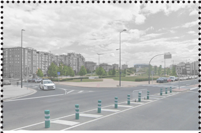
Calles Gral. Vara de Rey y Miguel Delibes. La vía del tren ha quedado enterrada, creando un nuevo cruce rodado en superficie con espacios ajardinados y parques urbanos
