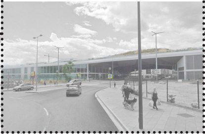
Nueva estación intermodal de Logroño. El derribo de la antigua estación y el soterramiento han contribuido a la creación de la estación intermodal, con el Parque Felipe VI en su cubierta.
