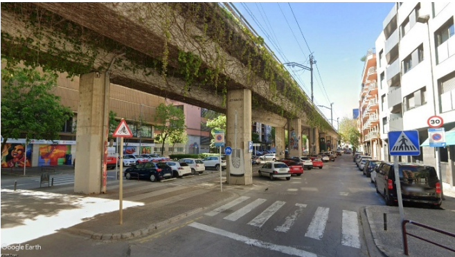
Figura 4.3.5. Situación del viaducto en Calle Bonastruc de Porta (Fuente: Google Street View 2023).
