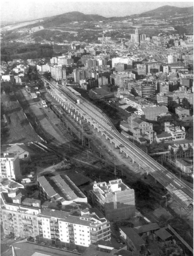
Figura 4.3.2. Vista aérea de la construcción del viaducto y la estación de tren de Girona, donde se puede observar aún el antiguo trazado. (Fuente: Fernández, Manterola y Fernández, 1975).
