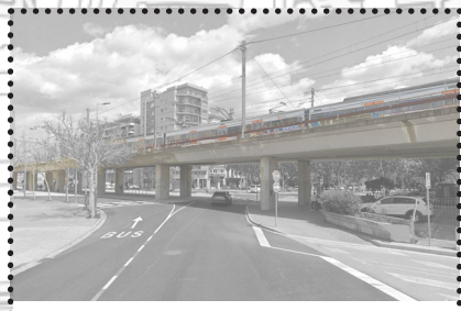
Plaza Joan Brossa (Barrio de la estación). En su aproximación a la estación, el viaducto se ensancha para acomodar los andenes del ferrocarril. Estos espacios son una gran oportunidad para generar espacios públicos cubiertos y seguros
