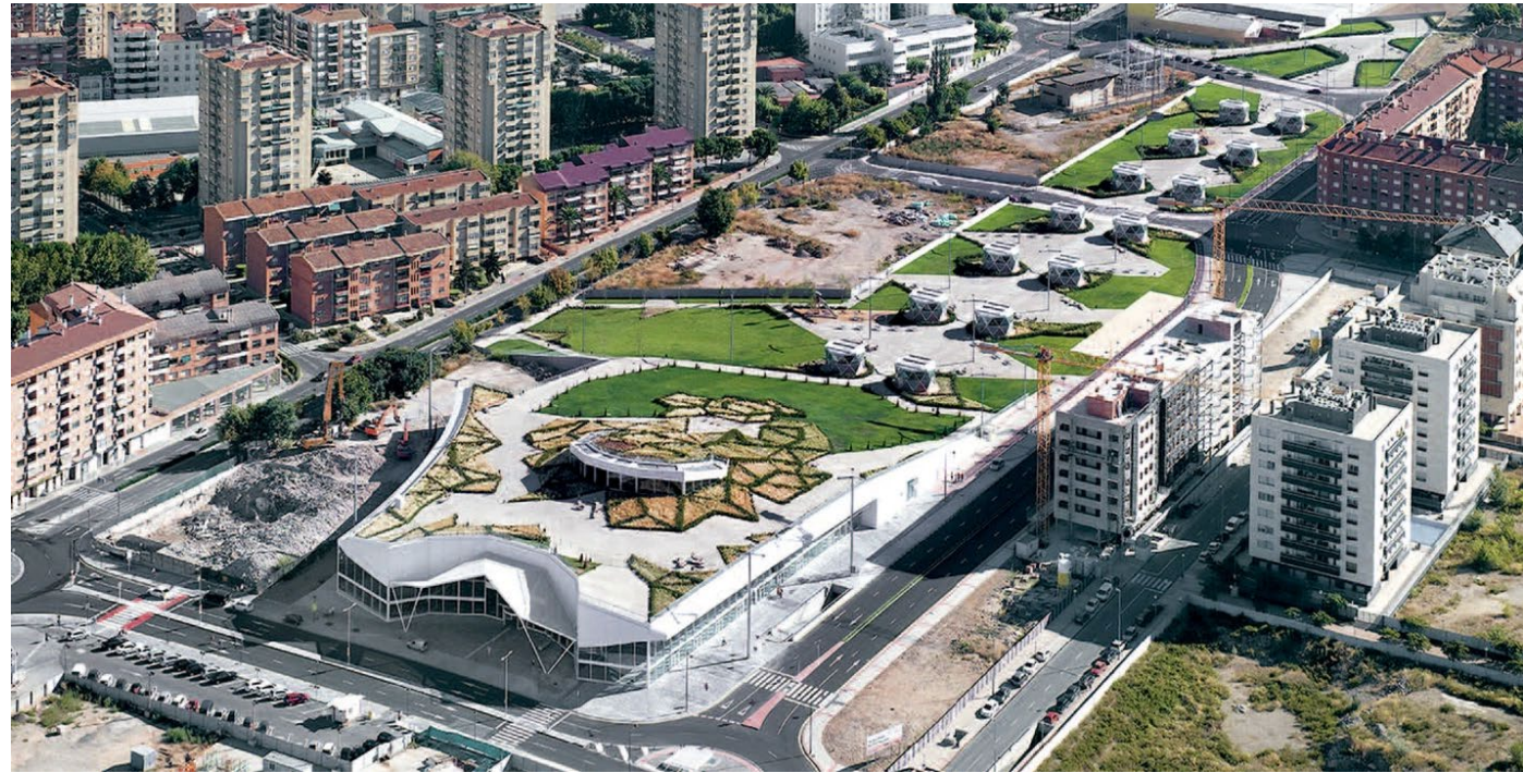
Figura 4.1.4. Vista aérea de la estación intermodal de Logroño y el Parque Felipe VI. (Fuente: Sacyr Infraestructuras).
