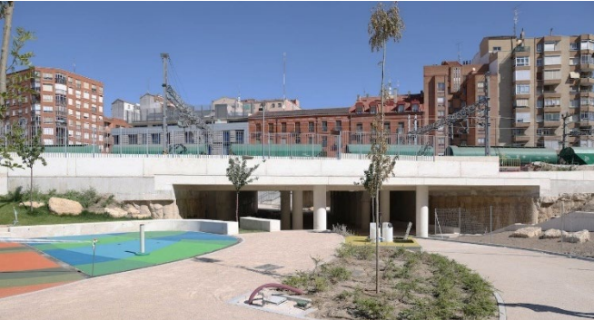
Figura 4.2.7. Situación de la vía del tren en Calle Panaderos, tras el proyecto de integración (Fuente: Google Open Photo 2025).
