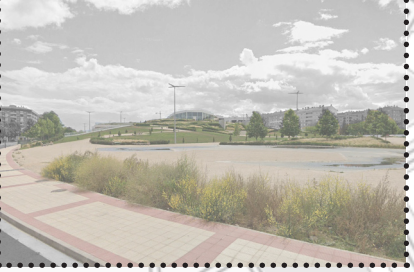
Parque Felipe VI. La actuación de soterramiento contempló un gran parque urbano sobre la cubierta. Actualmente, el Parque Felipe VI actúa como pulmón regenerador de los barrios del sur.
