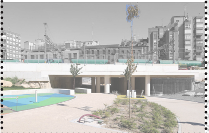
Nueva paseo peatonal en Calle Panaderos. Esta actuación primeriza de integración en superficie ha supuesto un caso de éxito, lo que motiva el resto de actuaciones en la ciudad.
