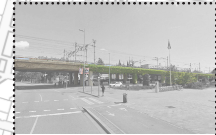
Passeig D'Olot. El viaducto pierde importancia urbana conforme se aleja de la ciudad al sur, sin embargo, aún presenta un tratamiento verde en su materialidad. Estos espacios quedan aún por ser aprovechados
