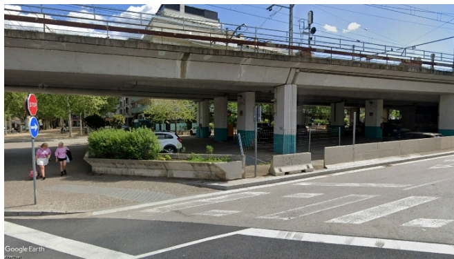
Figura 4.3.11. Situación del viaducto en Plaza de Joan Brossa (Fuente: Google Street View 2023).
