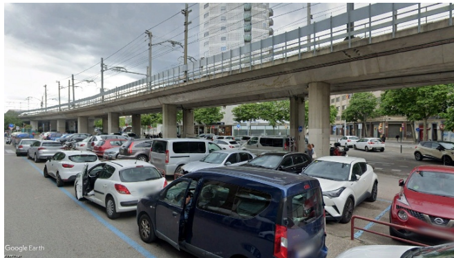
Figura 4.3.10. Situación del viaducto en Travesía Carril. (Fuente: Google Street View 2023).
