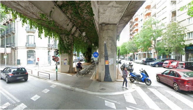
Figura 4.3.6 El viaducto en Calle Bonastruc de Porta, cerca del entorno de la estación de Girona (Fuente: Google Street View 2023)
