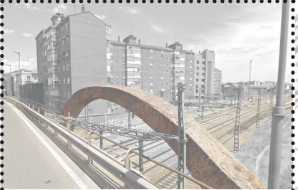
Paseo del Arco de Ladrillo. El entorno del barrio de Arco de Ladrillo aún está pendiente de integración. Los planes de Adif y el Ministerio de Transportes contemplan la integración completa y la creación de una nueva plaza
