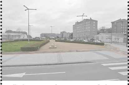
Calle Eliseo Maestro (Cascajos-Piqueras). El extremo derecho de la Fase I de integración ha creado una nueva calle rodada y un espacio peatonal ajardinado. Esta zona se verá complementada por los espacios de la Fase III.
