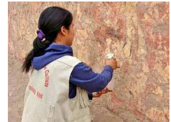
Figura 106 Consolidación de acabados: humectación con spray y readherencia de capas. Fuente: Pachacamac: Templo Pintado. Conservación e investigación (Denise Pozzi-Escot, Gianella Pacheco, Carmen Rosa Uceda).
