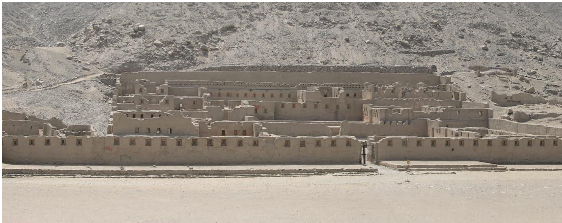
Figura 135 Vista del Edificio Noroeste. Fuente: https://www.labrujulaverde.com/2020/04/tambo-colorado-el-sitio-arqueologico-de-adobe-mejor-conservado-del-peru-inca
