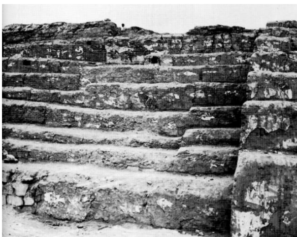
Figura 119 Sección B del aterrazamiento con restos de pintura. Fuente: Muelle & Wells (1939) en Bonavia (1985)
