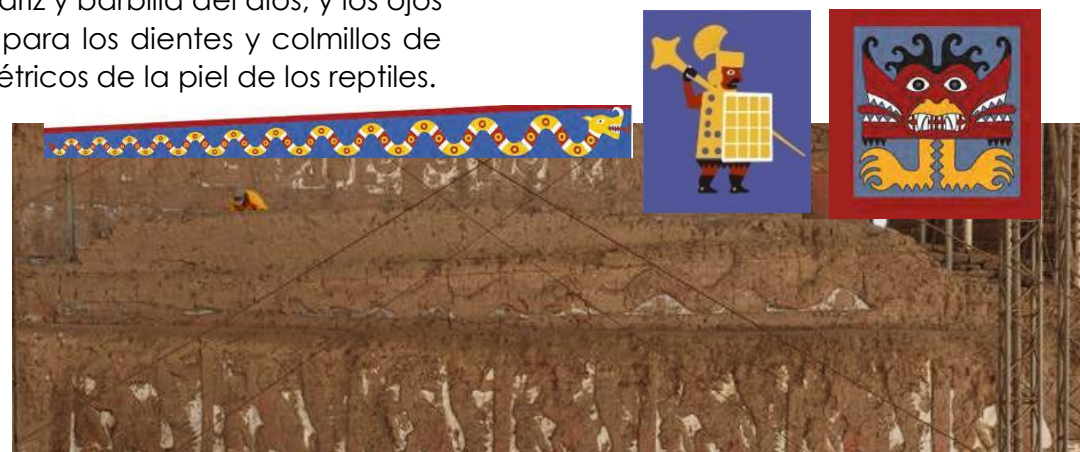
Figura 57 Estado Actual Sexto Escalón del Edificio A, Fachada Norte de la Plataforma I. Fuente: Huaca de la Luna. Templos y Dioses Moches. (Santiago Uceda, Ricardo Morales, Elías Mujica). Composición propia.
