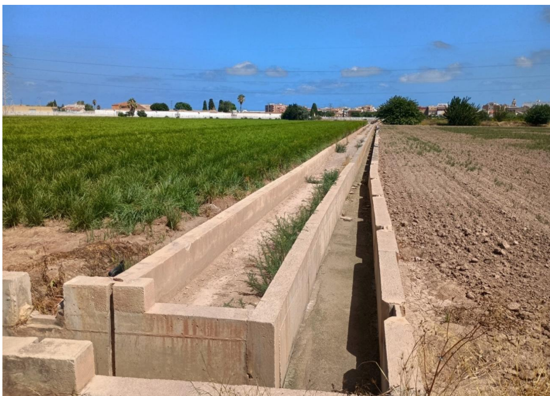
Figura 10. Acequia existente. Dirección Este
