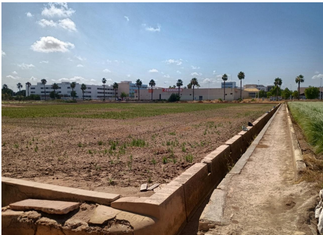
Figura 9. Acequia existente. Dirección Oeste
