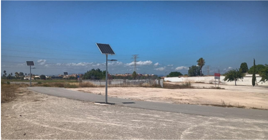
Figura 1. Zona inicio de obras
