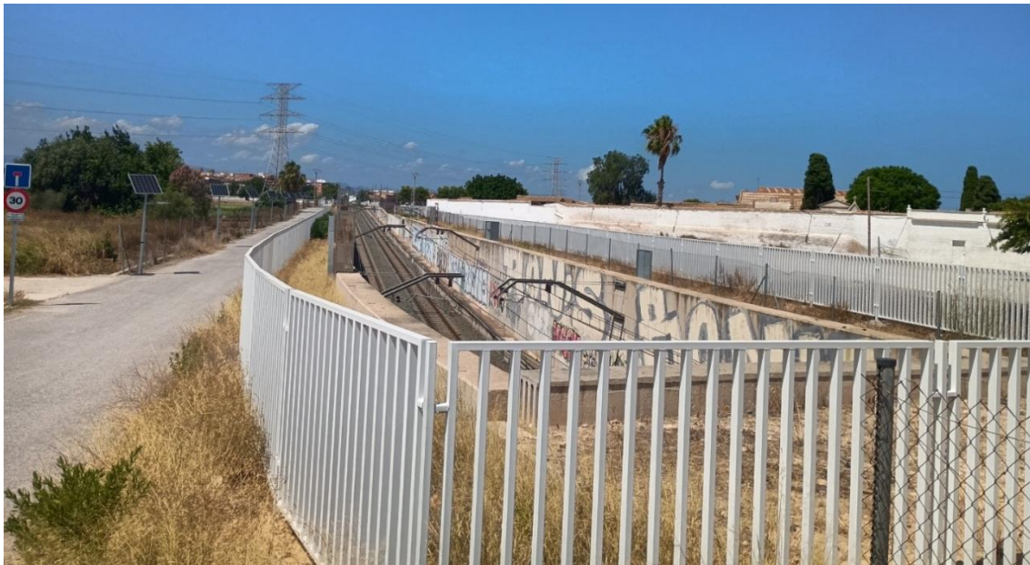
Figura 2. Salida de la línea de metro a superficie. Dirección Norte
