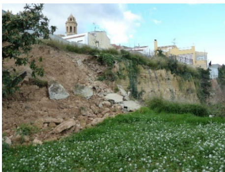
Fig. 15- Desprendimiento (Fotografía de Arturo Zaragozá, 2012).
