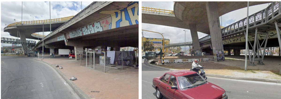
Fig. 3 Área bajo puente Av. Comuneros con Av. NQS Bogotá, Colombia. Fuente: Google Earth
