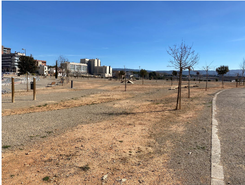
Imagen 12. Vista del entorno del parque "Polígono Sur" en la que se puede apreciar una depresión originada por el agua en la zona central de la imagen. Imagen tomada desde el camino perimetral a los taludes del parque con orientación norte. Fuente: propia.
