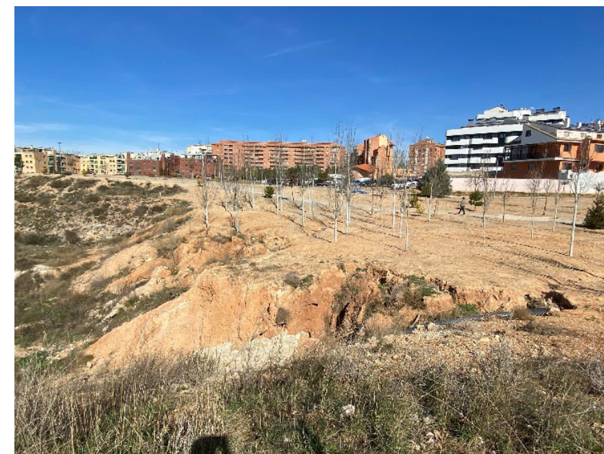
Imagen 3. Vista general del talud a estabilizar. Imagen tomada desde la zona sur del parque con orientación oeste. Fuente: propia.
