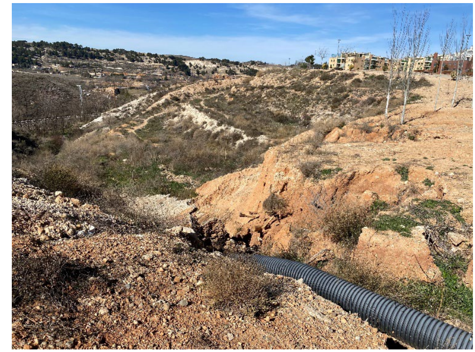
Imagen 7. Vista del tubo perteneciente al sistema de drenaje que se ubica en la cabeza del talud. Imagen tomada desde la zona sur del parque con orientación oeste. Fuente: propia.
