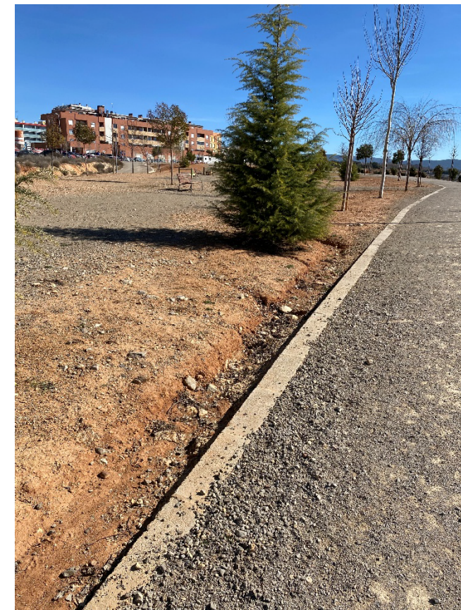
Imagen 10. Detalle de las erosiones producidas junto a los caminos peatonales en el parque "Polígono Sur". Imagen tomada desde el camino perimetral a los taludes del parque con orientación norte. Fuente: propia.
