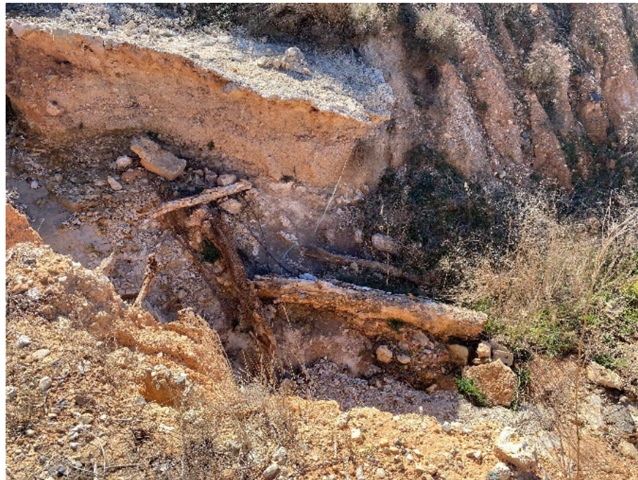
Imagen 9. Detalle de los residuos arrastrados por las aguas de escorrentía en el talud a estabilizar. Imagen tomada desde el talud con orientación sur. Fuente: propia
