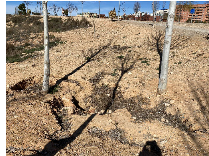
Imagen 2. Imagen de la erosión provocada en forma de cárcavas por las aguas de escorrentía. Imagen tomada desde el talud objeto de estudio en dirección oeste. Fuente: propia.
