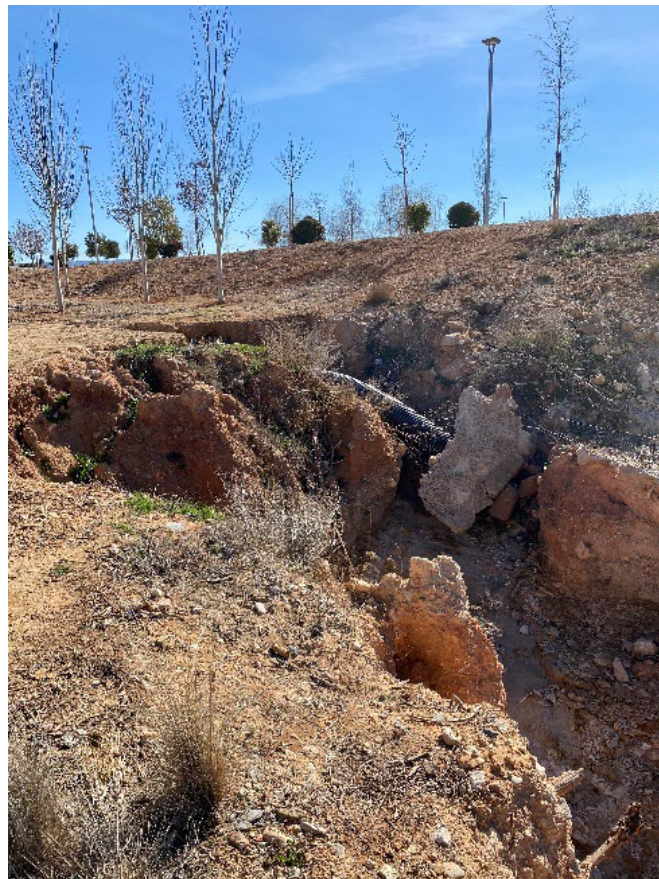
Imagen 8. Detalle del descubrimiento del final del tubo perteneciente al sistema de drenaje que se ubica en el talud a estabilizar. Imagen tomada desde la zona sur del parque con orientación sur. Fuente: propia.
