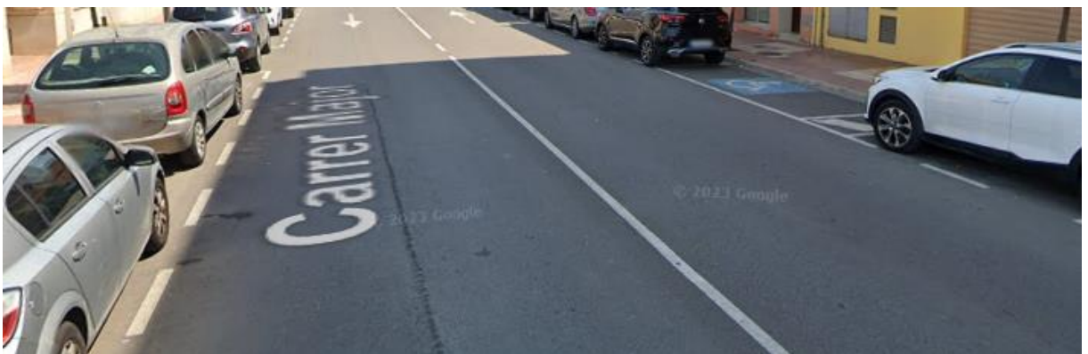
Figura 73: Estado de la calle Major a la entrada sur del municipio (Google maps, )
