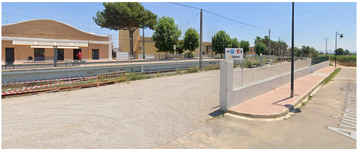
Figura 103: Aparcamiento dentro de la estación de metro de Alginet (Google maps, )
