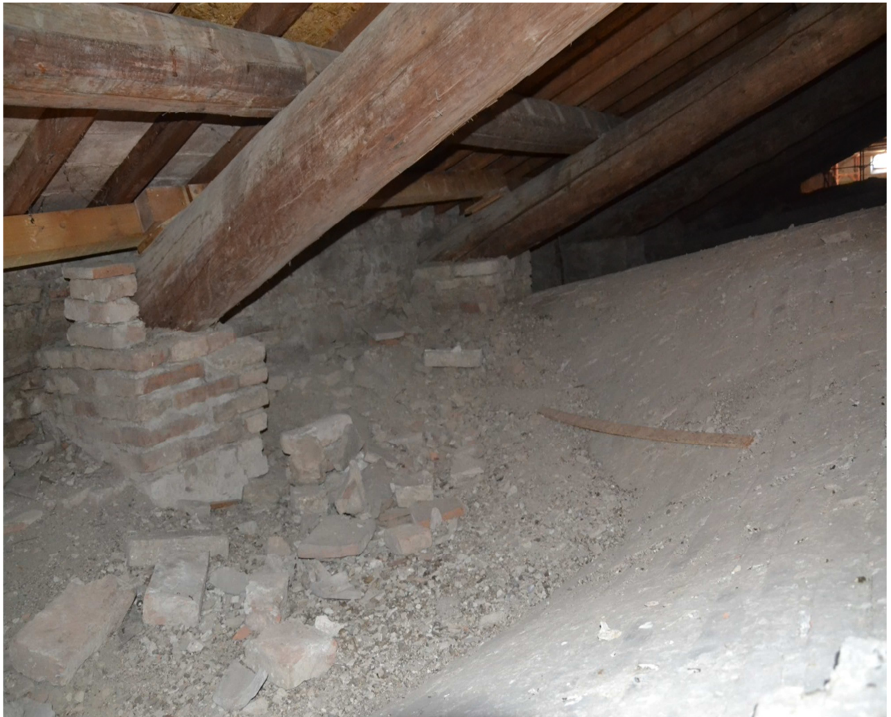
Figura 52: Travi di legno incassate nel muro, copertura della navata sinistra.
