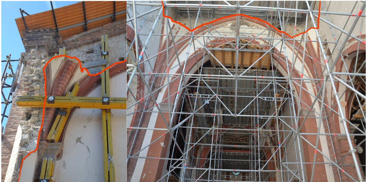
Figure 45: Taglio delle volte per i reni.
