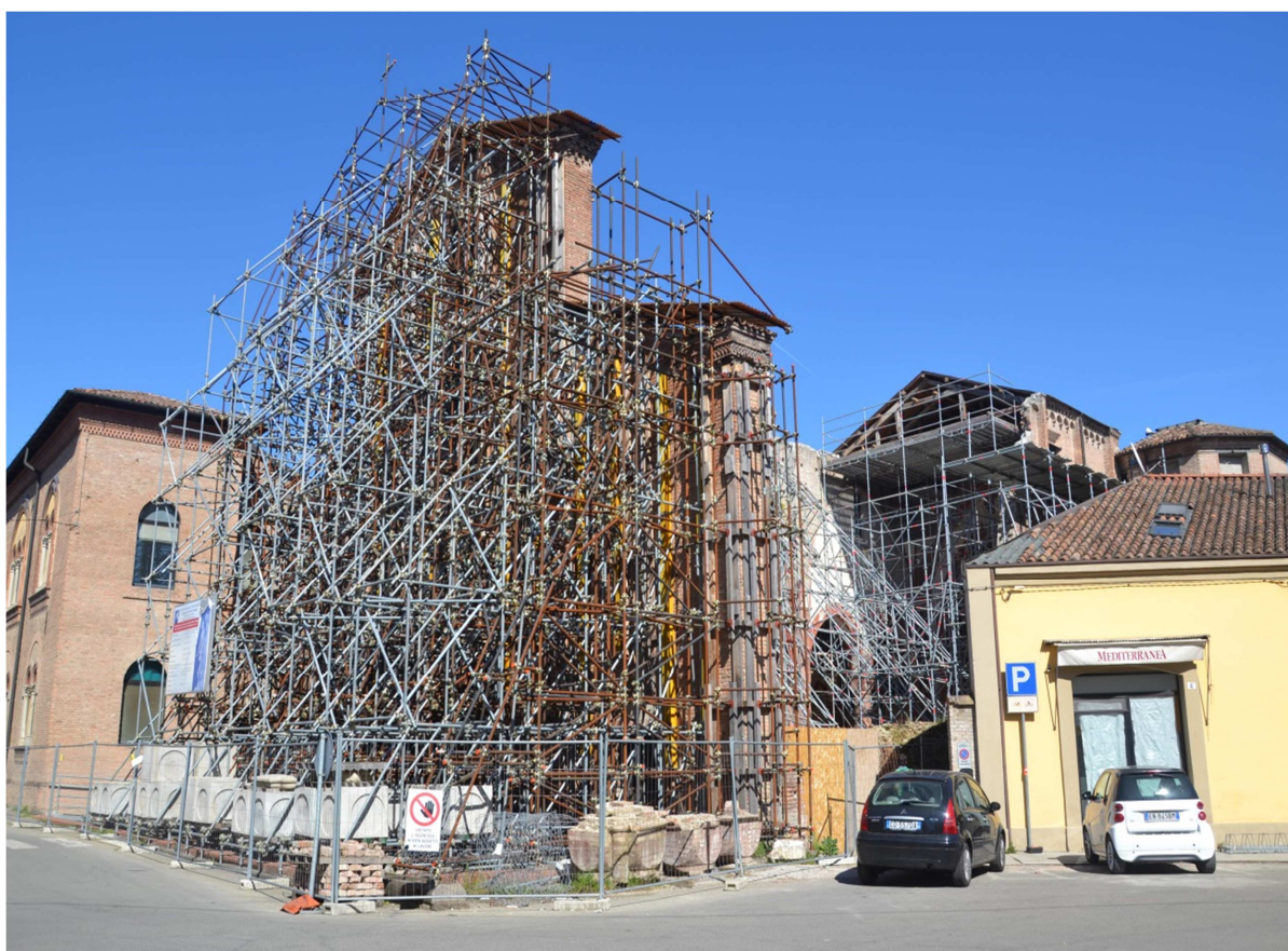
Figura 50: Facciata spaccata per evitare il suo giro, s'incontra solo collegata con il muro nord.
