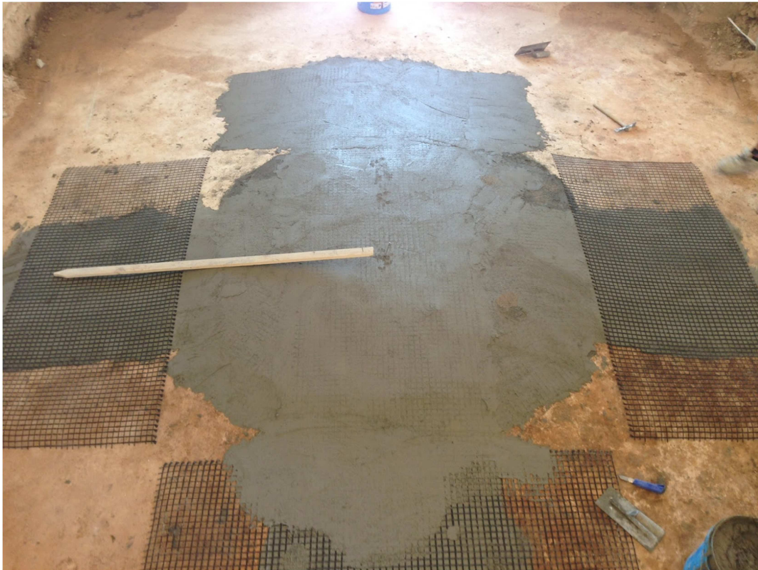
Figura 66: Volta parzialmente rinforzata.
