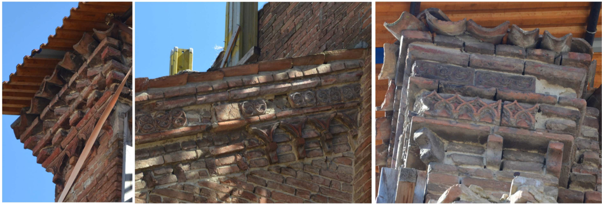
Figura 15: Cornice superiore della facciata principale.
