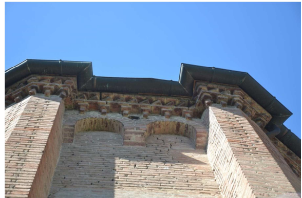
Figura 14: Cornici in muratura dell'abside.
