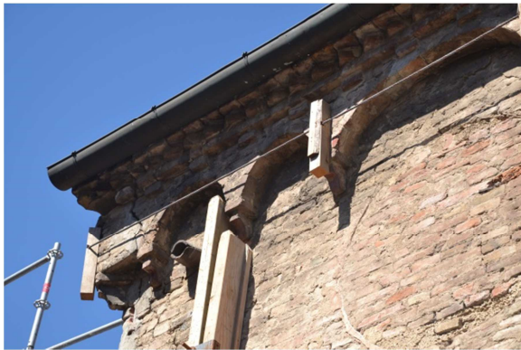
Figura 13: Cornici in muratura del edificio.
