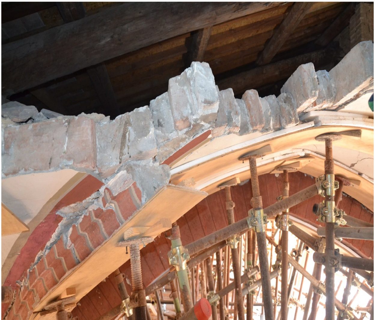
Figura 51: Volta dannata per la mancanza di un buon collegamento.
