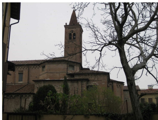
Figura 8: Complesso monumentale dell'abside.
