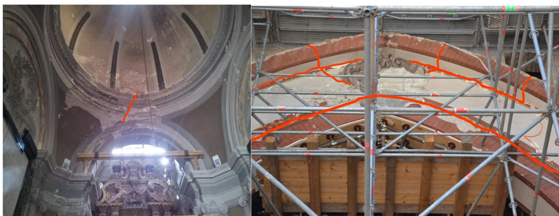
Figure 42: Danneggiamento del arco nel presbiterio e cupola di prima alla cappella di B. Vergine di Reggio.
