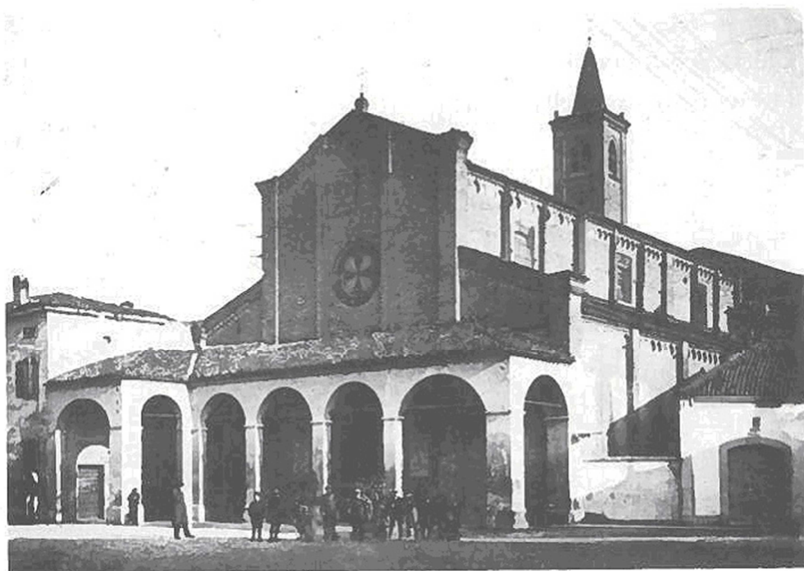
Figura 31: Vista della facciata prima del 1926.
