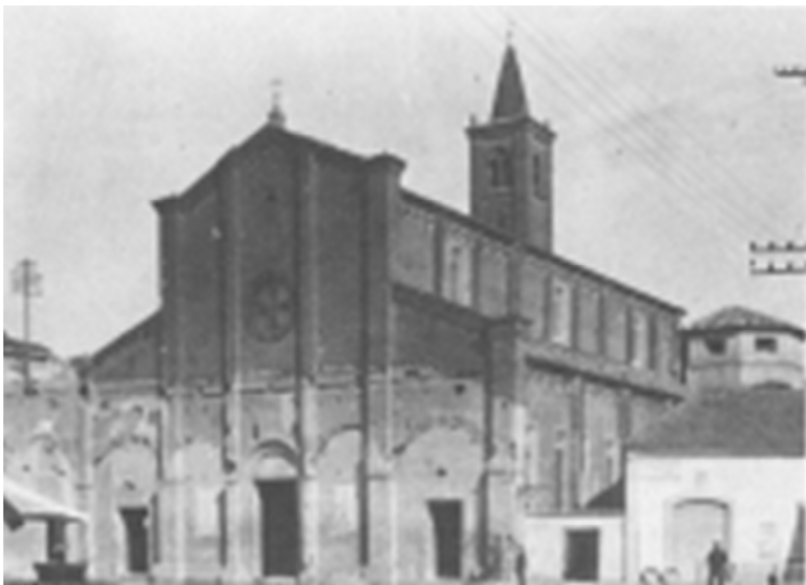
Figura 32: Vista della facciata dopo il restauro del 1930 circa.
