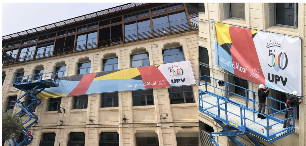
Figura VI-7: Instalación de estructuras mediante plataformas elevadoras. Plaza del Campus de Alcoi de la Universitat Politècnica de València.
