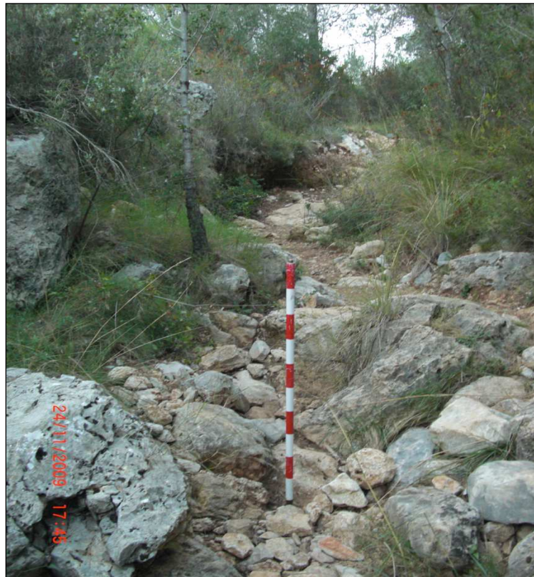
Figura 9.2: Rocas sueltas y amontonadas que indican el paso de agua.
