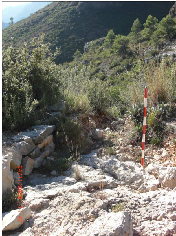
Figura 6.1: Drenaje del agua de escorrentía.
