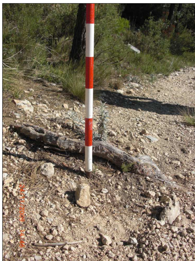
Figura 5.4: Presencia de raíces al descubierto
