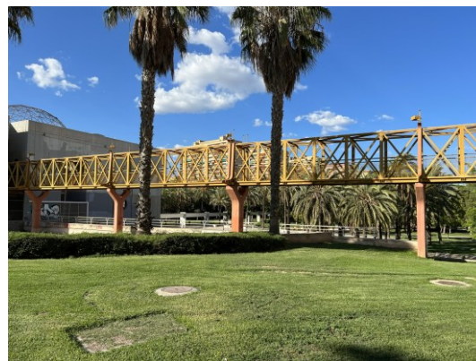
Fig. 2.28 Pasarela de celosía de acero (Pasarela Casa del Agua, Valencia, España). Fuente: fotografía del autor
