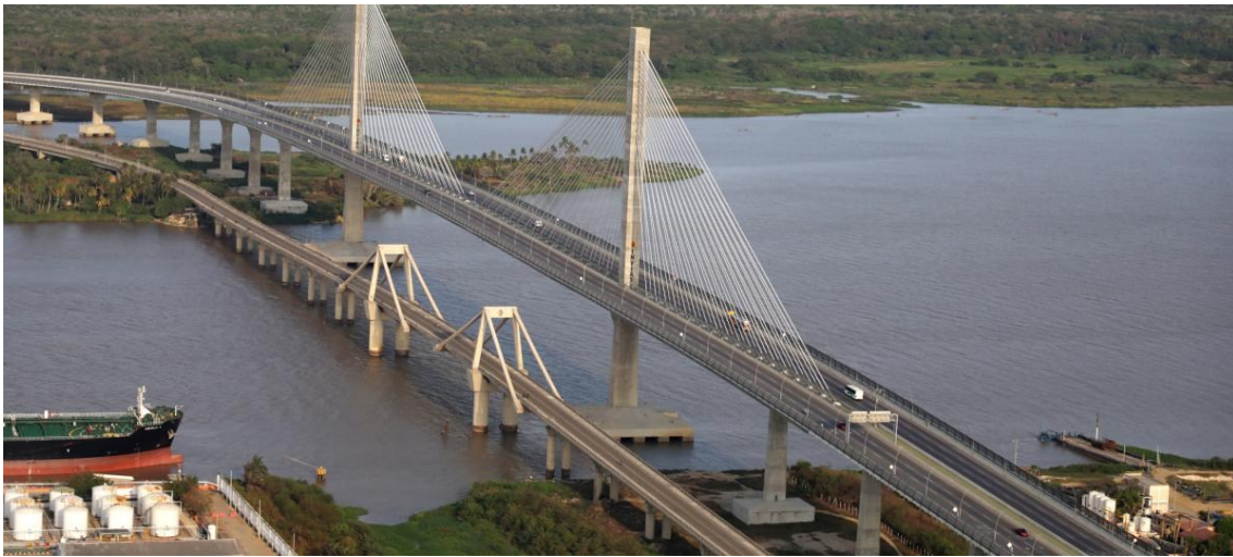
Fig. 2.21 Ejemplo de puentes atirantados (Puente Pumarejo antiguo (izquierda) y Puente Pumarejo nuevo (derecha), Barranquilla, Colombia). Fuente: (Agencia Kronos, 2024).
