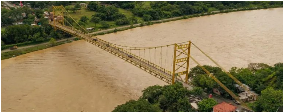
Fig. 2.20 Ejemplo de puente colgante: Puente de Occidente (Santa Fe de Antioquia, Colombia). Fuente: (El Colombiano, 2022; Ospina Zapata, 2022)
