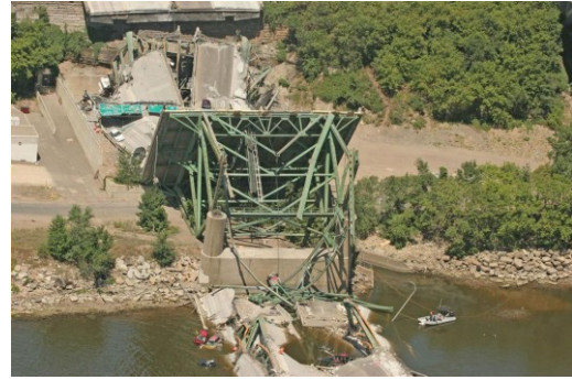
Fig. 1.2. Colapso del puente I-35W. Fuente: (Thornton Tomasetti, 2008), cortesía del MnDOT
