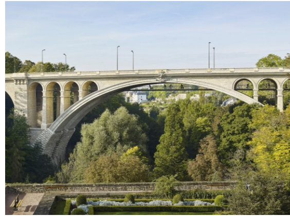
Fig. 2.15 Puente con tímpano abierto (Pont Adolphe, Luxemburgo, Luxemburgo) Fuente: (Roth, 2019)
