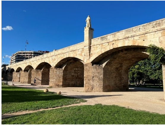
Fig. 2.14 Puente de obra de fábrica con tímpano macizo (Pont de Sant Josep, Valencia, España). Fuente: fotografía del autor
