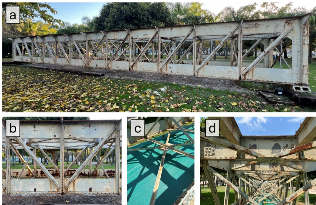
Fig. 3.2 Vano de puente gemelo desmantelado de referencia. a) Vista general b) Montantes, diagonales y cordones c) Arriostramiento lateral inferior d) Arriostramiento lateral superior, viga transversal superior y largueros. Fuente: fotografía del autor
