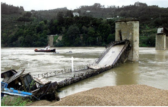
Fig. 1.1. Colapso del puente Hintze Ribeiro. Fuente: (Rodrigues, 2021)
