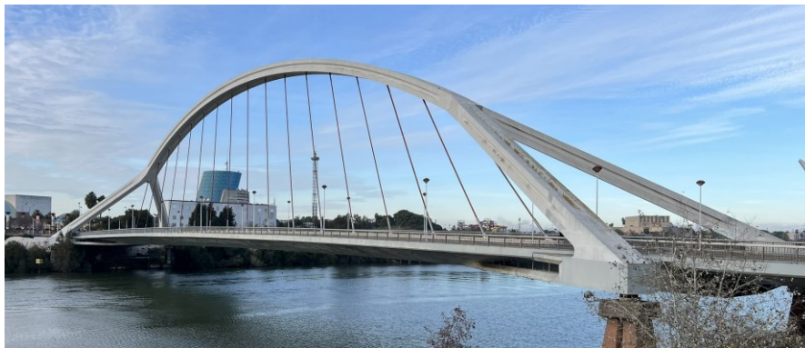
Fig. 2.18 Puente de arco atirantado (Puente de la Barqueta, Sevilla, España). Fuente: fotografía del autor
