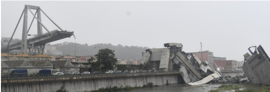
Fig. 1.3. Colapso del viaducto de Polcevera. Fuente: (Financial Times, 2018)
