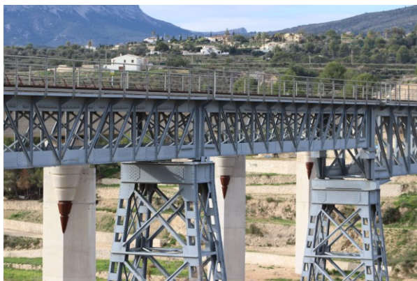
Fig. 2.27 Puente de celosía de acero (Pont del Quisi, Benissa, España). Fuente: fotografía del autor
