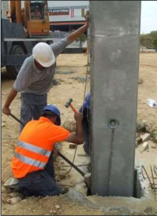
Figura 27 Aplomado de Pilares
