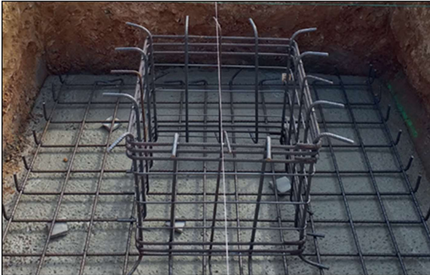
Figura 21 Preparación del foso - Zapata Tipo Calices
