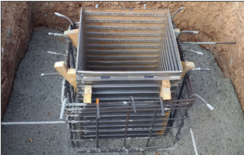
Figura 22 Colocación del CUBIX
