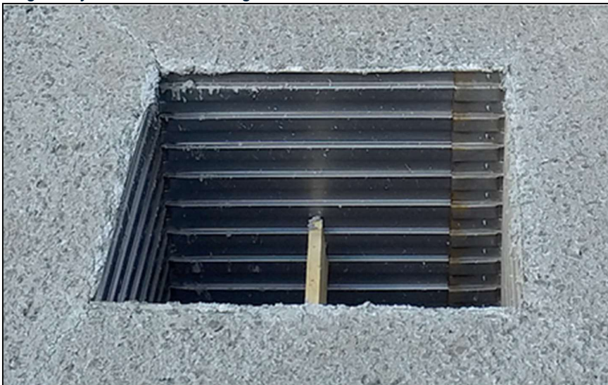
Figura 24 Fraguado y alicatado del hormigón
