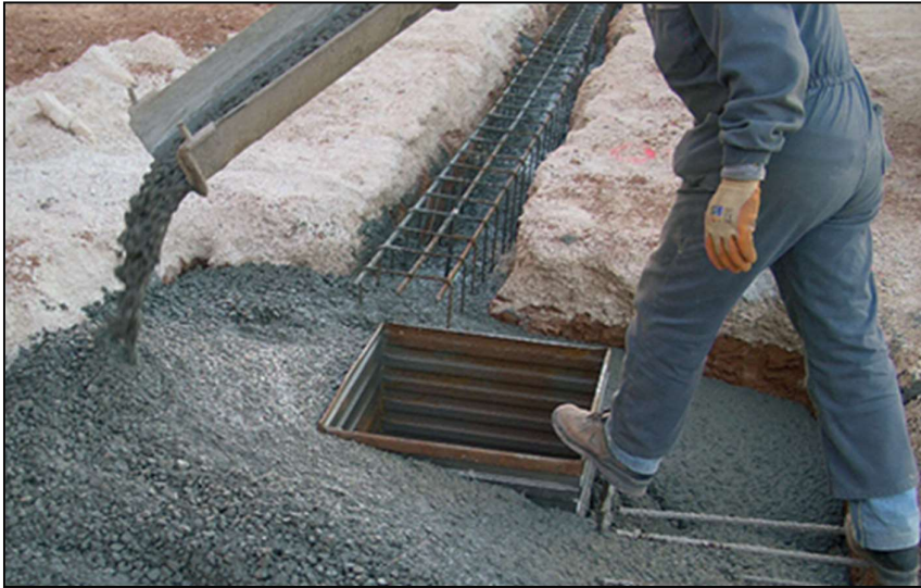
Figura 23 Hormigonado exterior de la zapata
