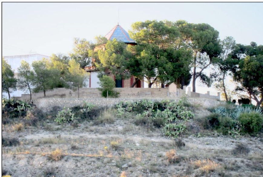
4. La Torrecilla en la actualidad. Fotografía del autor.
