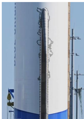
Figura 31: Fisuración del recubrimiento superficial causada por la dilatación térmica del material del NewGlenn (Blue Origin)
