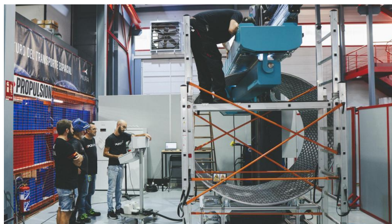
Figura 52: Curvado de una virola (PLDSpace)
