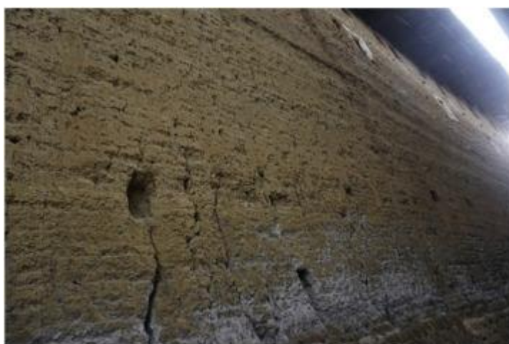
Foto 49 Erosión salina de un Tuqiang 57
