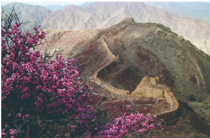
Foto 2 Antigua Gran Muralla de Ningxia 3
