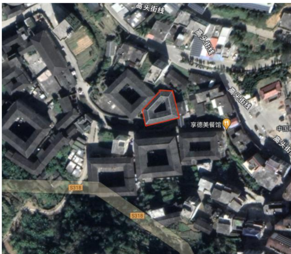
Foto 37 Edificio Shunyuanyuan, pueblo de Gao Dong, municipio de Guzhu, condado de Yongding
