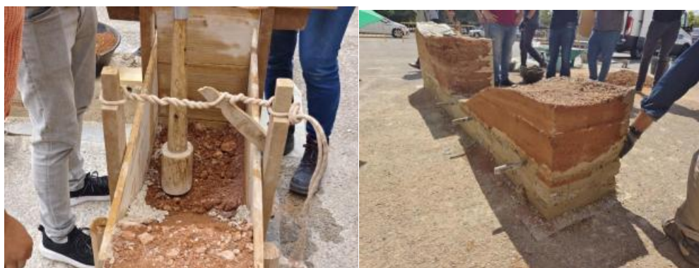
Foto 39 Operación de construcción de Tuqiang
