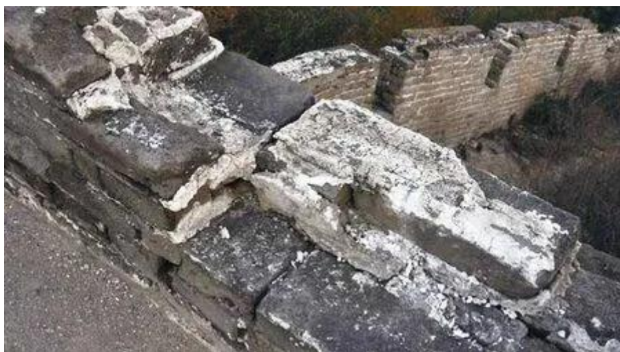
Foto 16 Mortero de arroz glutinoso en la Gran Muralla
