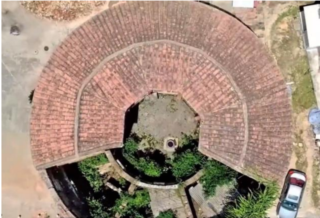
Foto 35 Edificio Naxun, aldea Shenglu, ciudad Guanxun, condado de Zhangpu, ciudad de Zhangzhou
