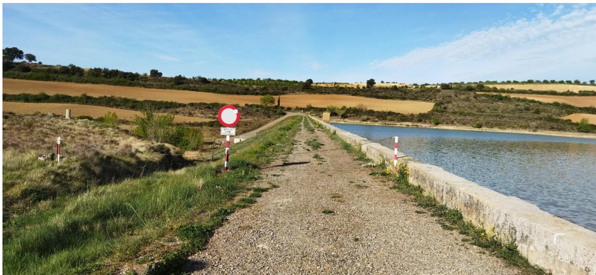
Figura 13.- Coronación. Fuente: visita realizada a la presa.
