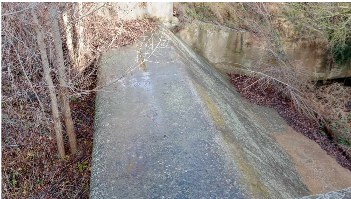
Figura 24.- Aliviadero azud de derivación. Fuente: visita realizada a la presa.
