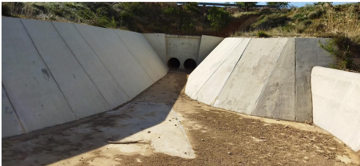
Figura 8.- Aliviadero. Fuente: visita realizada a la presa.
