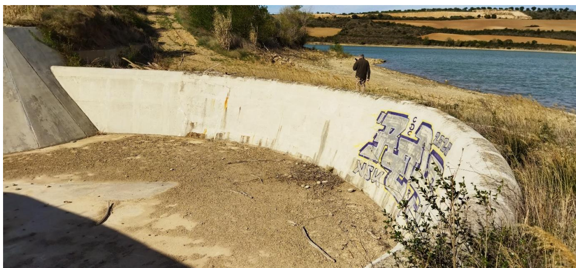
Figura 7.- Aliviadero. Fuente: visita realizada a la presa.
