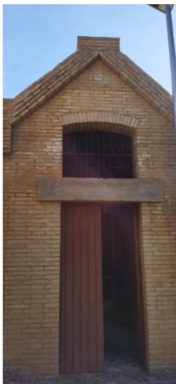
Figura 29.- Exterior e interior del edificio de compuertas de derivación hacia el río Astón. Fuente: visita realizada.
