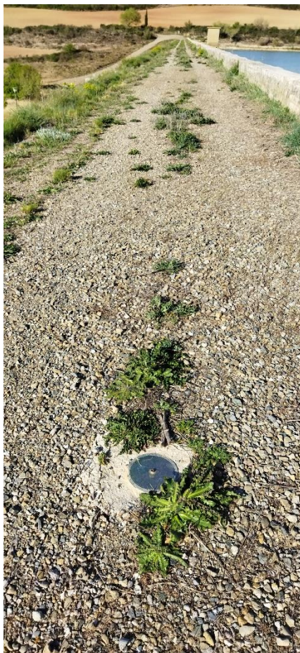
Figura 15.- Coronación. Fuente: visita realizada a la presa.
