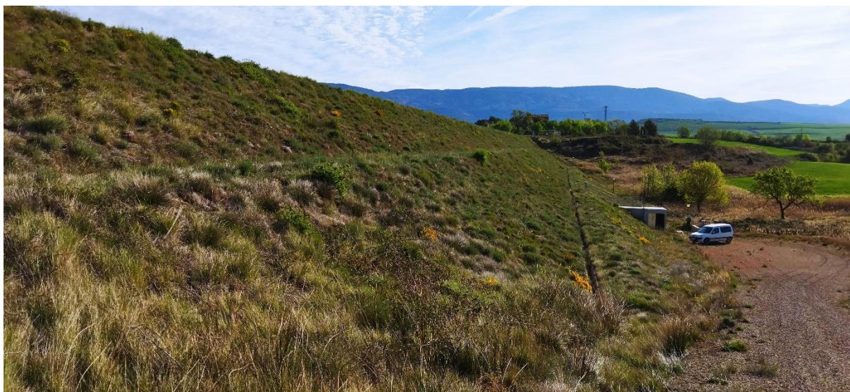
Figura 1.- Paramento de aguas abajo. Fuente: visita realizada a la presa.
