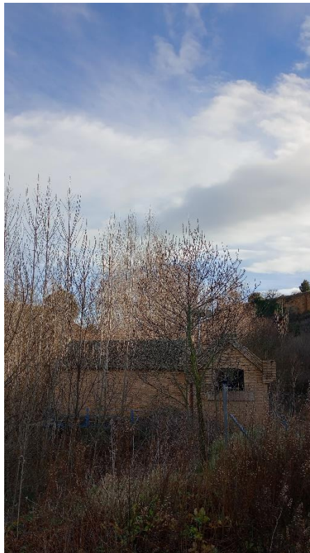
Figura 31.- Instalaciones azud de derivación. Fuente: visita realizada a la presa.
