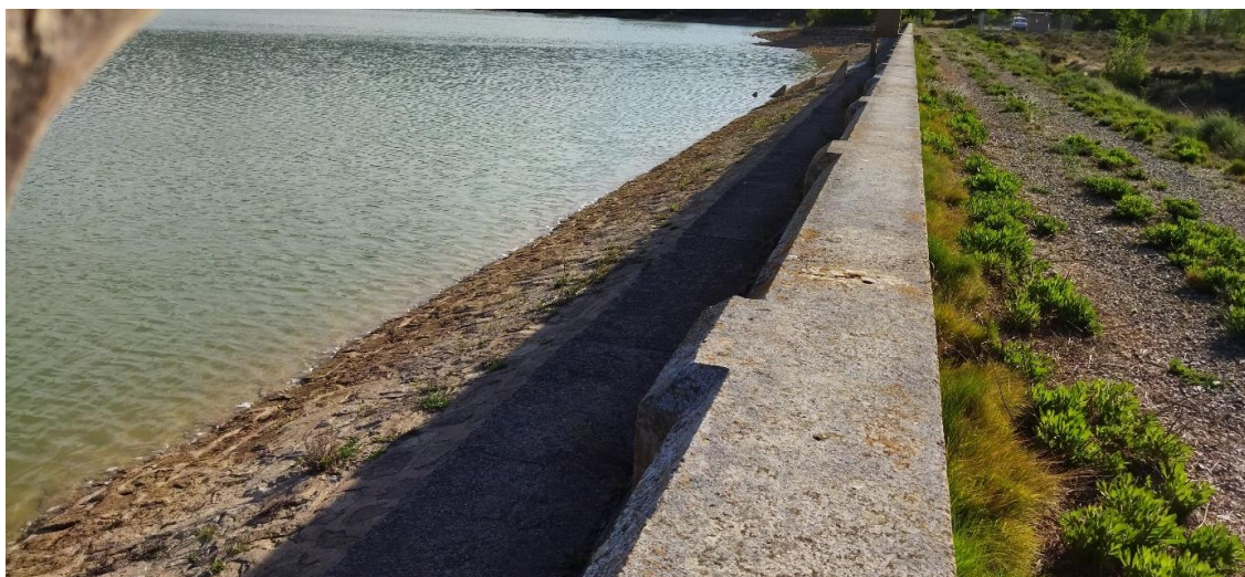
Figura 5.- Paramento de aguas arriba. Fuente: visita realizada a la presa.
