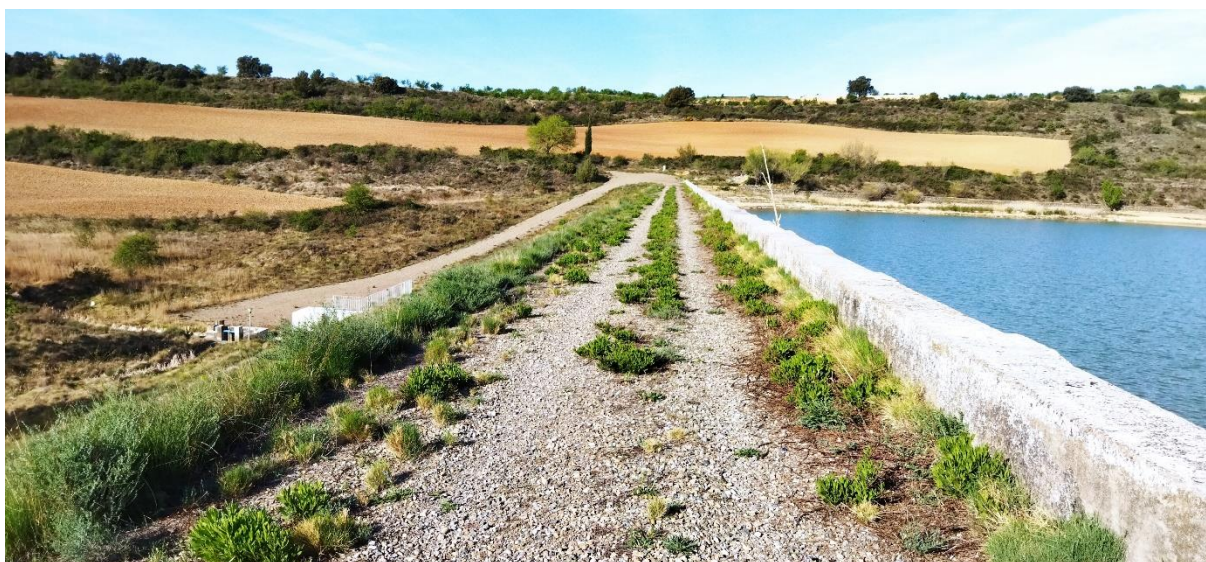
Figura 16.- Coronación. Fuente: visita realizada a la presa.
