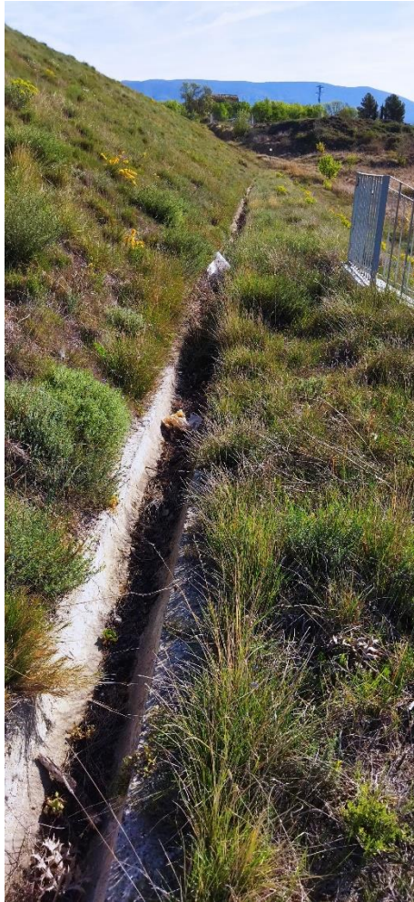
Figura 3.- Paramento de aguas abajo. Fuente: visita realizada a la presa.
