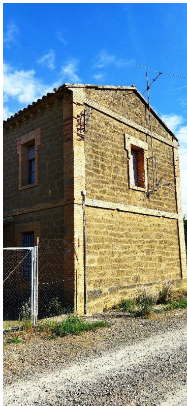
Figura 11.- Antigua casa de administración. Fuente: visita realizada a la presa.
