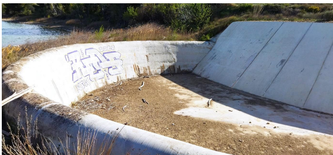
Figura 6.- Aliviadero. Fuente: visita realizada a la presa.
