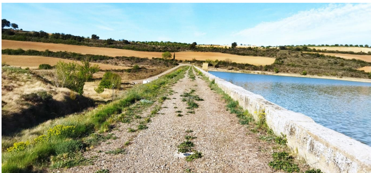
Figura 14.- Coronación. Fuente: visita realizada a la presa.
