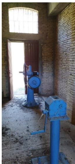
Figura 30.- Exterior e interior del edificio de compuertas de derivación hacia el río Astón. Fuente: visita realizada.
