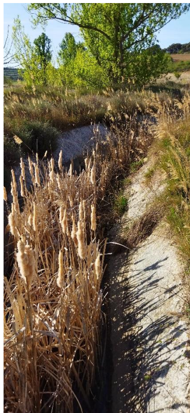
Figura 21.- Canal de riego. Fuente: visita realizada a la presa.
