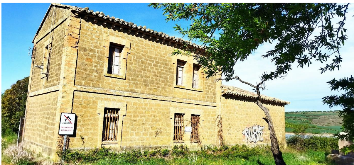
Figura 12.- Antigua casa de administración. Fuente: visita realizada a la presa.
