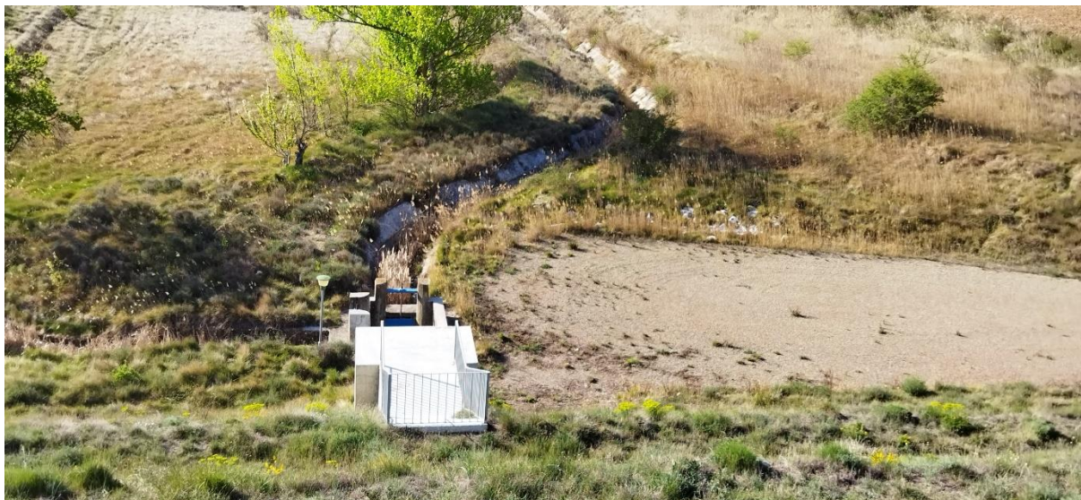
Figura 19.- Caseta de desagüe de fondo y riegos vista desde coronación. Fuente: visita realizada a la presa.
