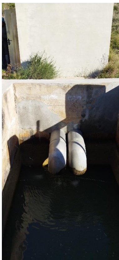
Figura 20.- Zafareche de rotura de carga. Fuente: visita realizada a la presa.
