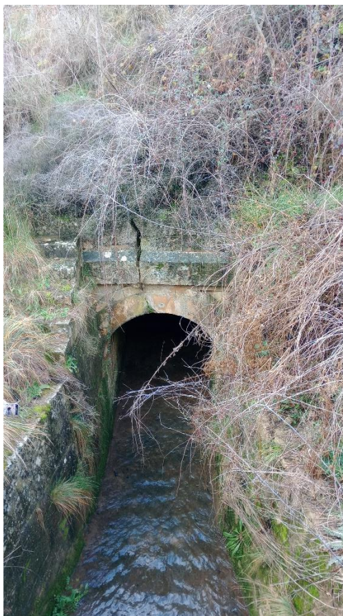
Figura 23.- Entrada túnel de trasvase. Fuente: visita realizada a la presa.
