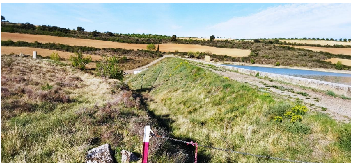
Figura 2.- Paramento de aguas abajo. Fuente: visita realizada a la presa.
