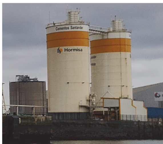
Fig. 4. Silos Aditivos Raos. Fuente: APPS. (2023)
