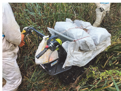
Los residuos se introducen en sacos, que se cierran y se transportan de forma segura hasta su eliminación por un gestor autorizado.
