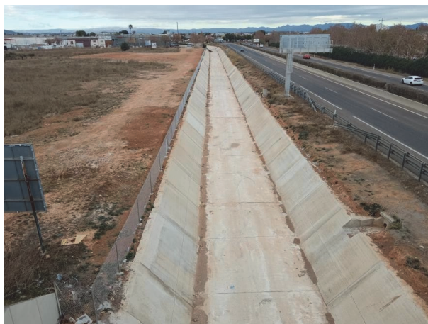
Fig 4 Cunetón revestido en hormigón
