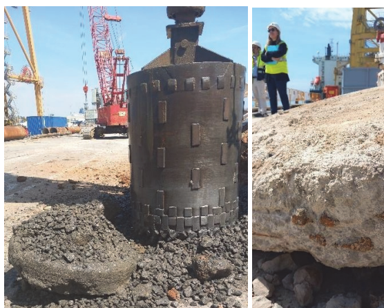
Fig. 11. Extracto de solera del cajón perforada y extraída. Fuente: Sánchez P. et al. [5].
