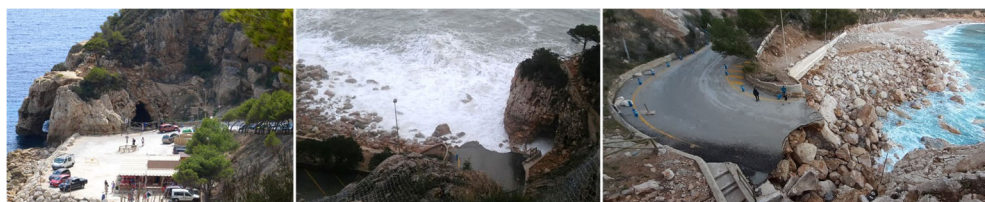
Fig. 3. Fotografías de la plataforma de acceso a Cala Moraig (Benitachell): antes (izq.), durante (centro) y una vez transcurrido (dcha.) el temporal Gloria.
