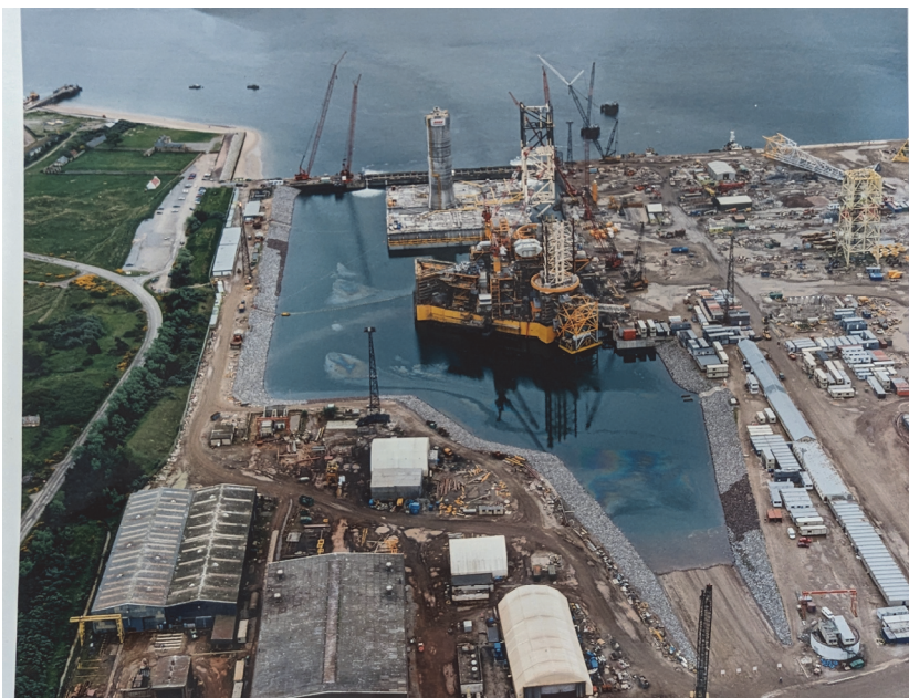
Ilustración 1. Muelle interior de Nigg Energy Park
