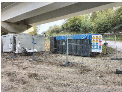
Los sacos llenos y cerrados se transportan al contenedor, cubierto para evitar cualquier posible propagación por el aire.
