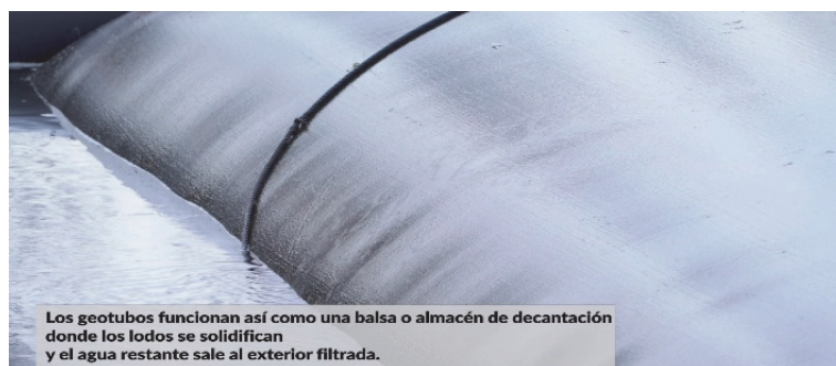
Fig. 4. Geotubos. Fuente: Seguimiento audiovisual del proyecto.
