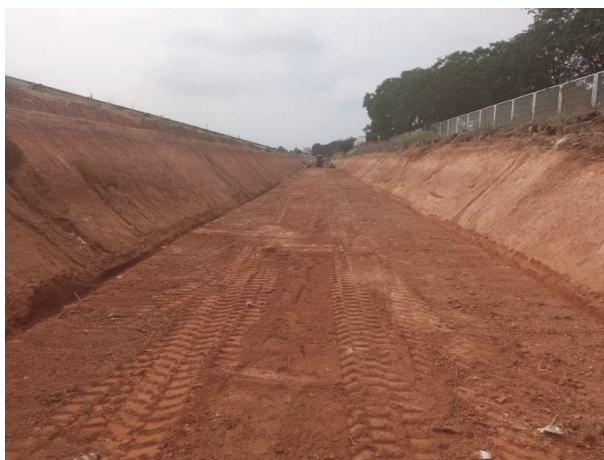
Fig 3 Cunetón acabado en tierras antes del revestimiento
