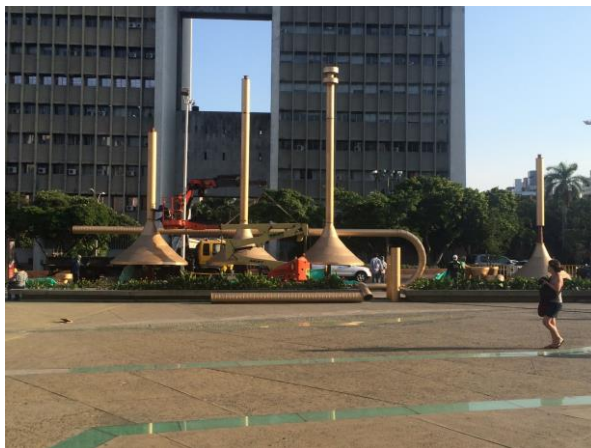
Fig. 5. Lucía y las trompetas en construcción la Plazoleta Jairo Varela, al frente Centro Administrativo Municipal de Cali. Fuente © Fredy Pantoja (2015)
