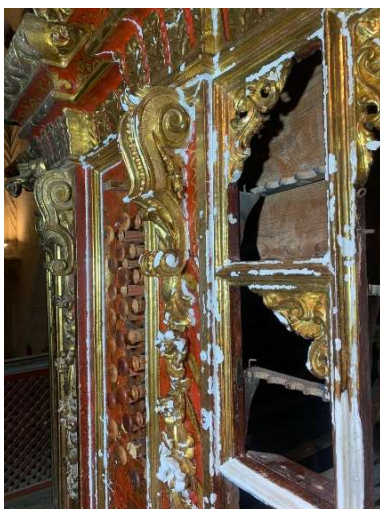
Figura 77. Proceso de estucado, 2025. Julia Torrente Sevilla.
