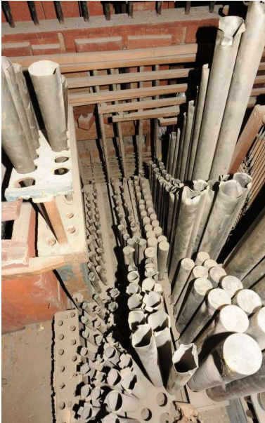
Figura 4. Tubería cadereta interior antes de intervención, 2024. Taller Desmottes.
