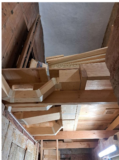
Figura 75. Estructura de la parte superior, 2025. Elena Valbuena Miralles.
