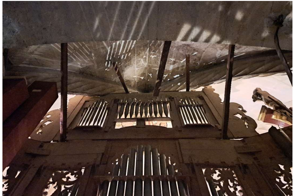
Figura 53. Tirantes metálicos de sujeción de la estructura del órgano, 2025. Elena Valbuena Miralles.
