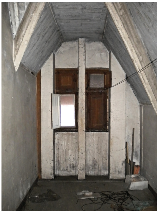
Figura 5. Sin título – 2 [Casa Carnicero, Perillo]. Fuente: Fotografía del autor, 2017
