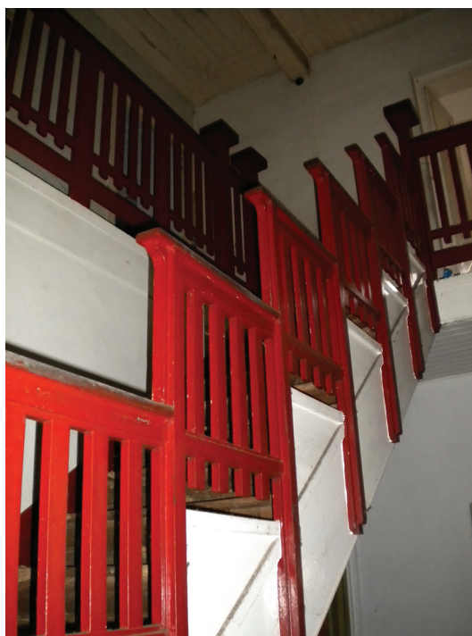
Figura 4. Sin título – 1 [Casa Carnicero, Perillo]. Fuente: Fotografía del autor, 2017
