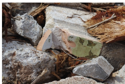
Figura 21. Ladrillo roto por la extracción de los árboles.
