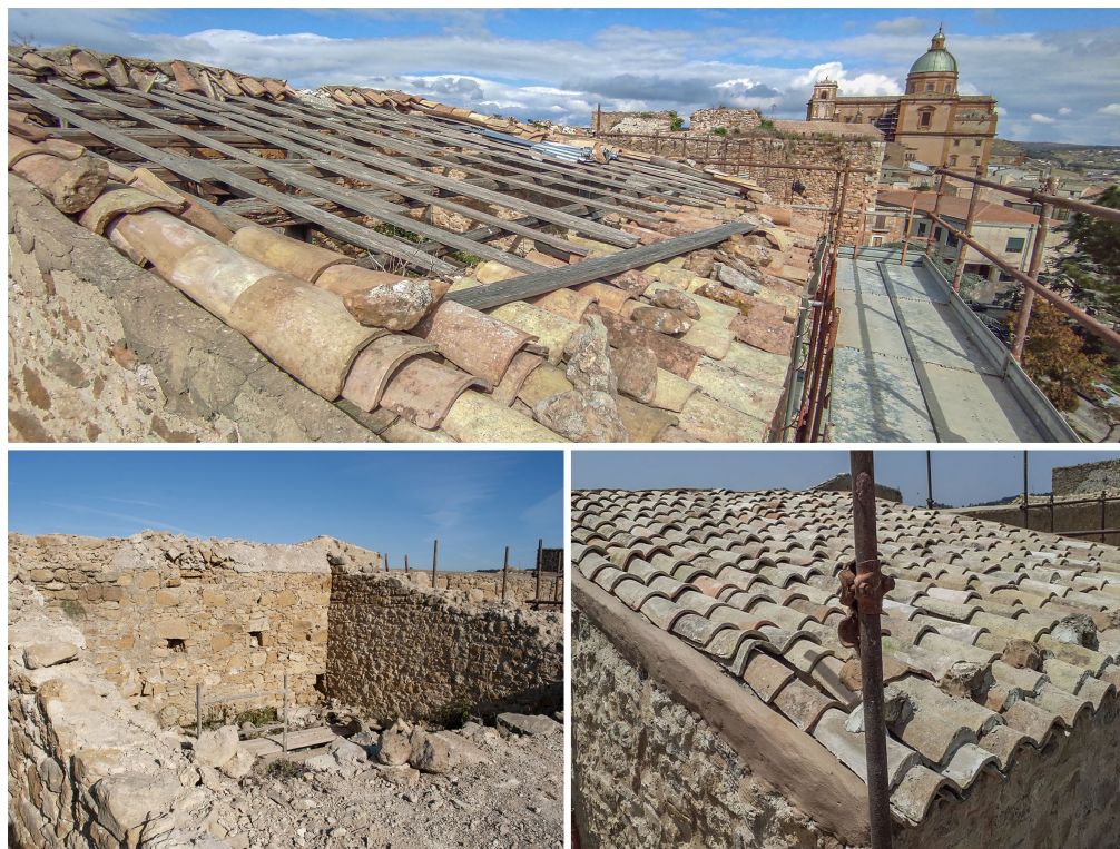
Fig. 5— Il cantiere di restauro del 2022: riconfigurazione della copertura in cotto siciliano della torre sud-est (autori).
