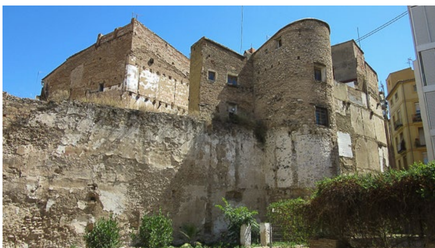
(F78. Antigua muralla árabe)
