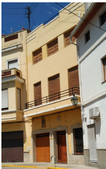
(F29. Edificio previo a la colaboración)
