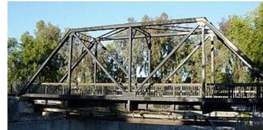
Ilustración 11. Celosía tipo Pratt. Fuente: Wikipedia
