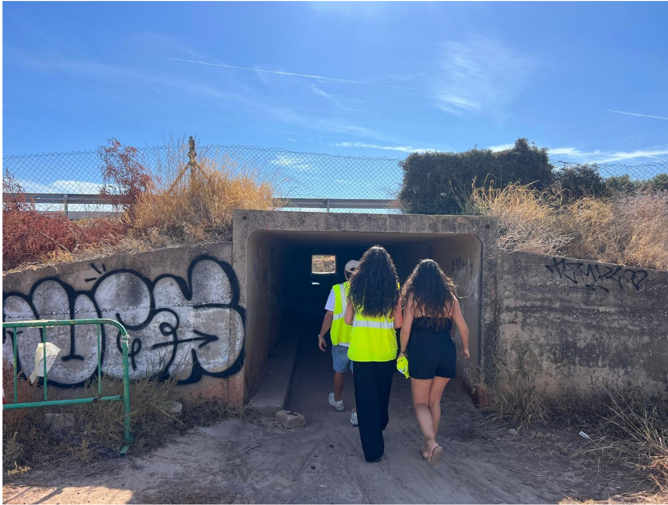
Ilustración 5. Obra de drenaje transversal (ODT). Fuente: Elaboración propia
