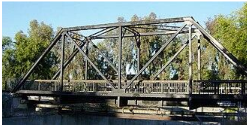
Ilustración 1. Celosía tipo Pratt. Fuente Wikipedia
