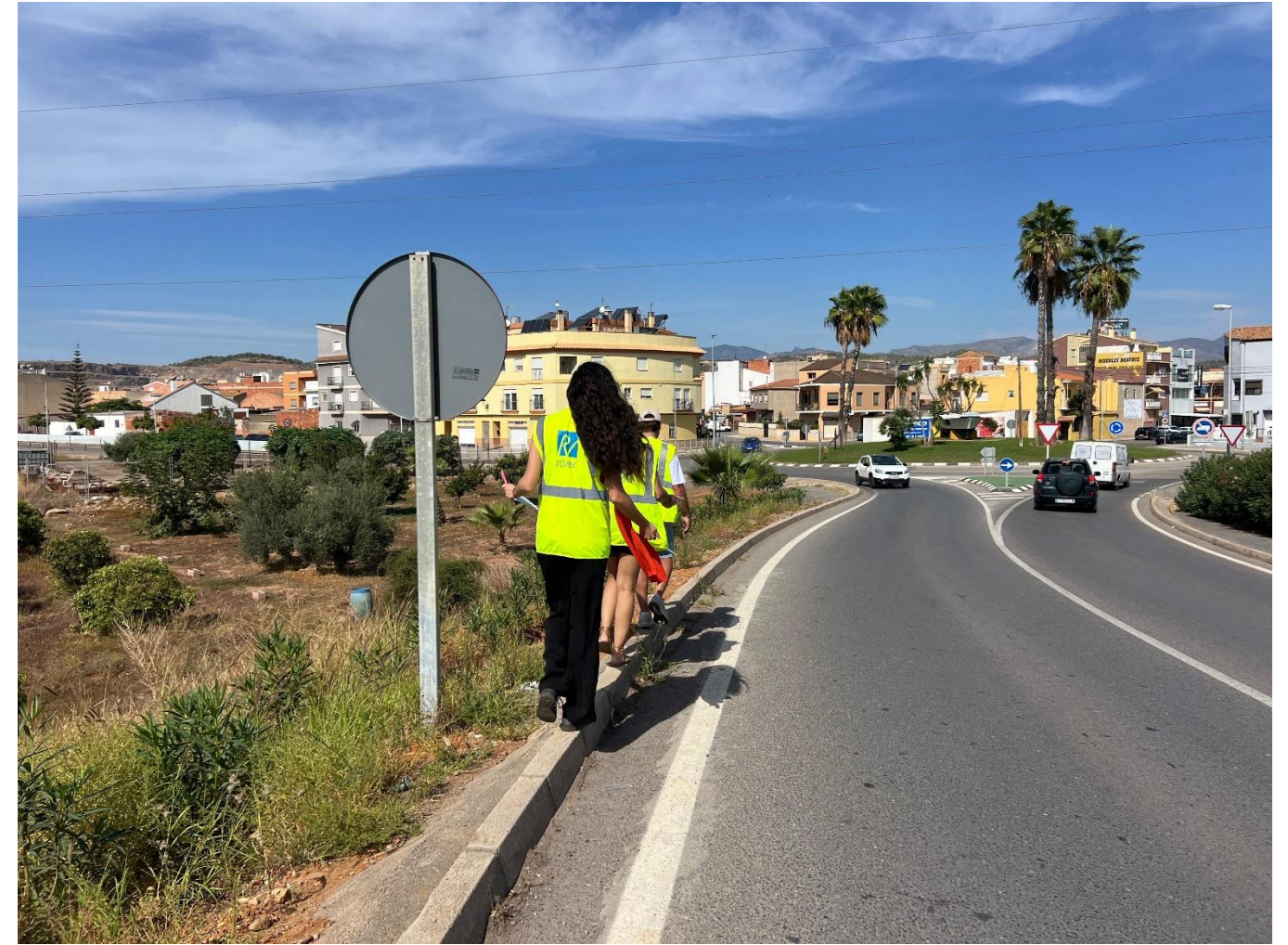
Ilustración 16. Inexistencia de acera. Fuente: Elaboración propia
