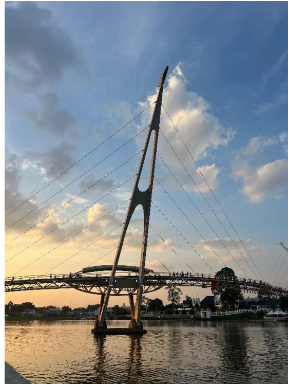
Ilustración 13. Pasarela atirantada. Fuente: Elaboración propia
