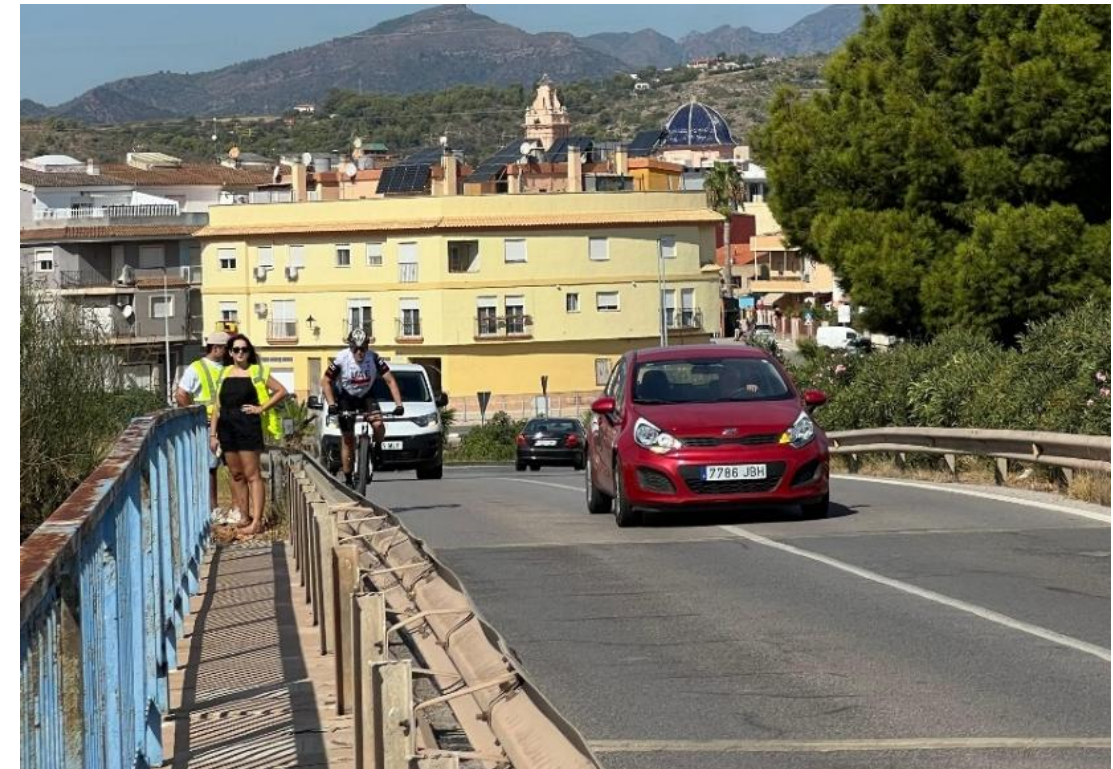
Ilustración 9. Peatones y ciclistas compartiendo puente vehicular. Fuente: Elaboración propia
