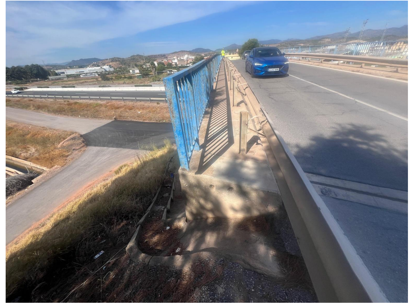
Ilustración 12. Acceso de plataforma del puente existente. Fuente: Elaboración propia
