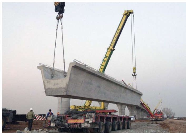
Ilustración 5. Viga Artesa. Fuente: Victor Yepes
