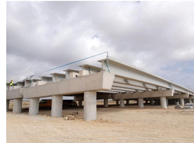
Ilustración 14. Viga en T pretensada. Fuente: Grupo Aljema Relosa
