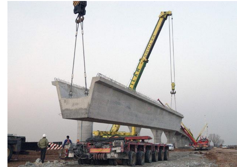
Ilustración 15. Viga Artesa. Fuente: Victor Yepes blogs
