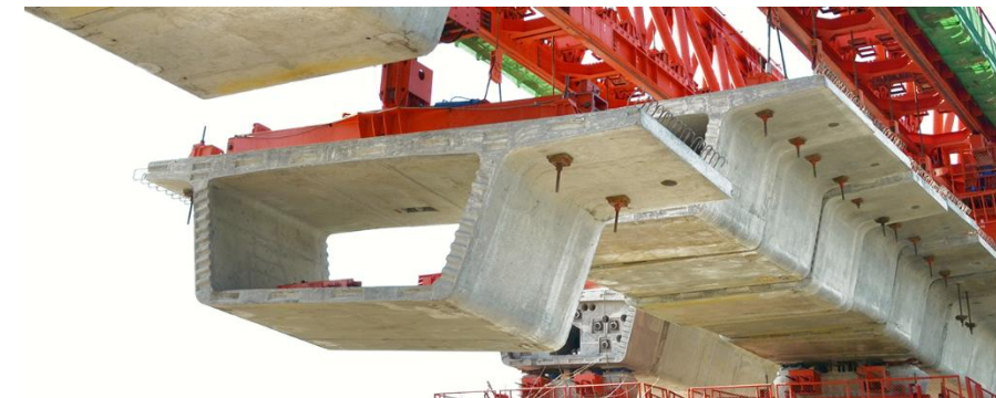
Ilustración 6. Viga en cajón. Fuente: Proceq
