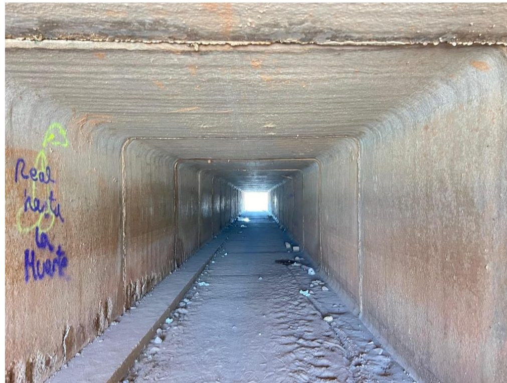
Ilustración 8. Obra de drenaje transversal. Fuente: Elaboración propia
