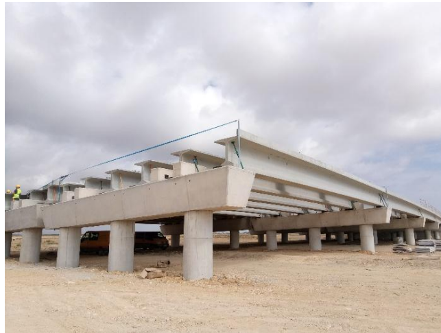
Ilustración 4. Viga en T pretensada. Fuente: Grupo Aljema Relosa
