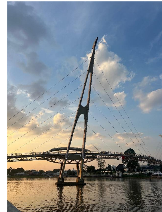
Ilustración 3. Pasarela atirantada. Fuente: Elaboración propia
