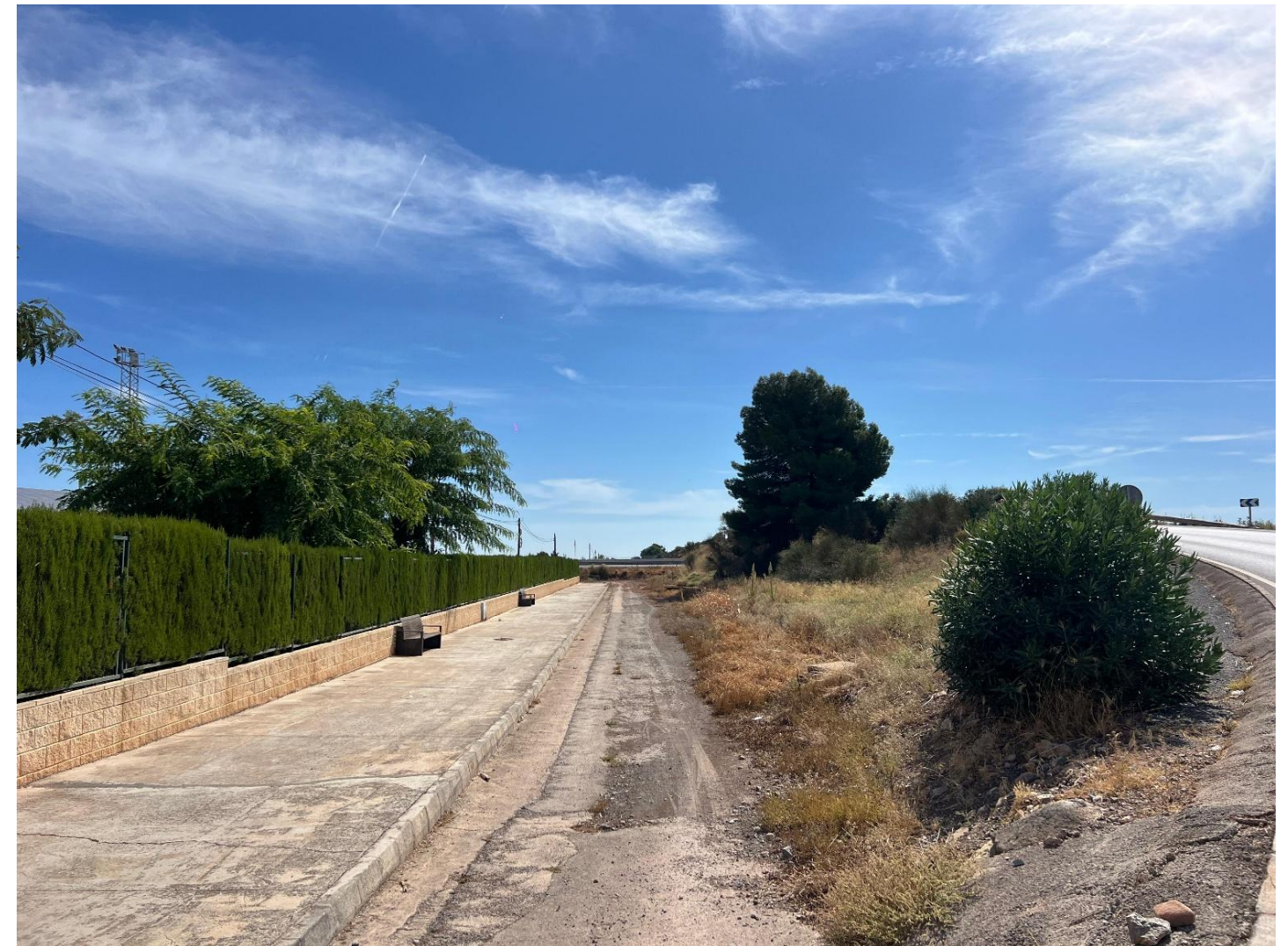
Ilustración 2. Zona de emplazamiento de rampa de acceso Oeste. Fuente: Elaboración propia
