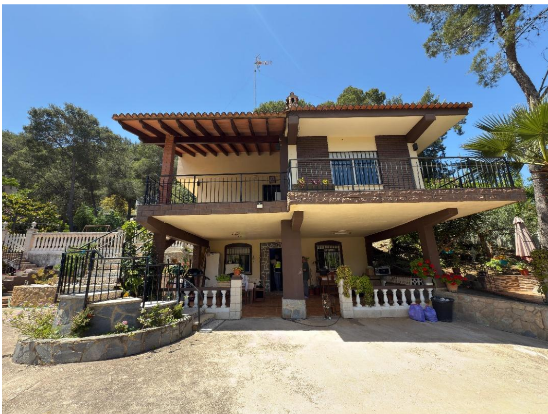
Figura 7.5. Imagen de la fachada de la vivienda. Elaboración propia.
