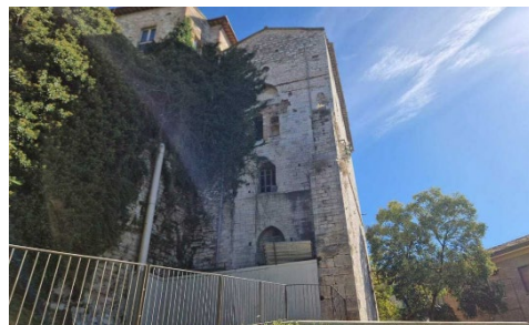
Fig. 2- Facciata anteriore della chiesa (Gasperini, 2024).
