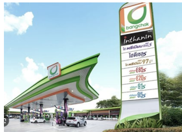
Figura 10. Área de estacionamiento de Bangchak Corporation
