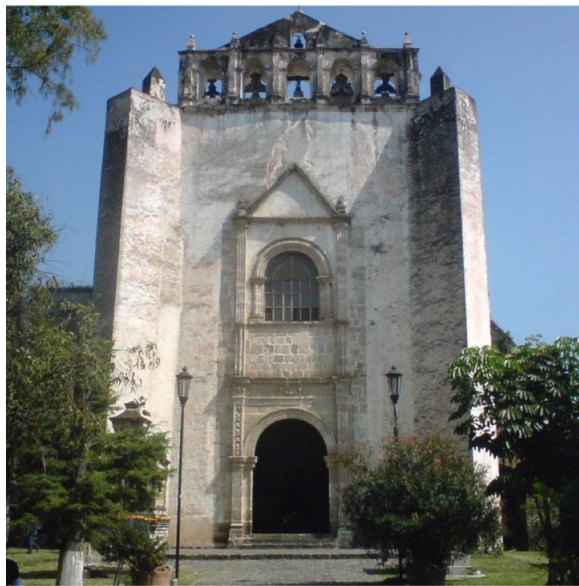
Figura 21. Tlayacapan (México), Ex-Convento de San Juan Bautista (1530). (Foto: R. Fonti).
