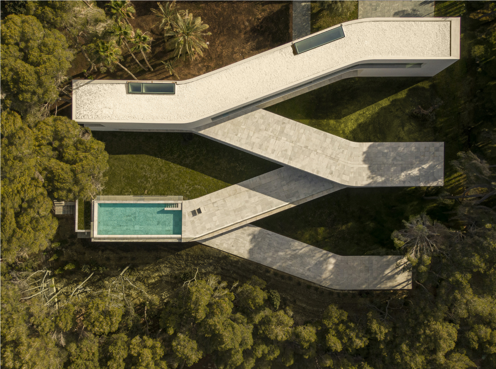
Fig. 85. Vista aérea de la Casa Sabater (Alicante, España, 2023; Fernando Guerra)
