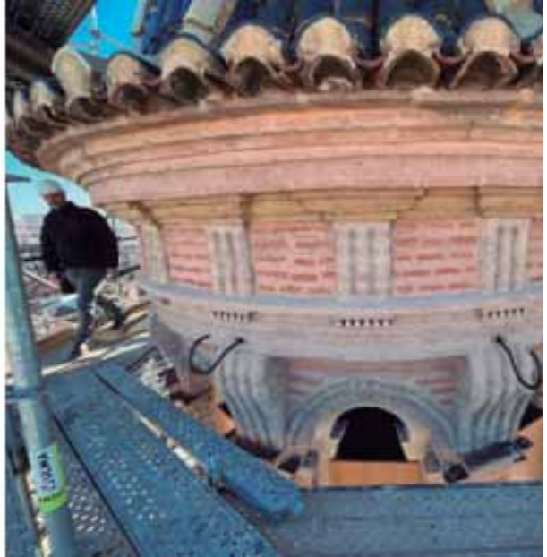
Linterna con los vanos cegados y el color apagado (izquierda) y tras su restauración (derecha) / Lanterna con le aperture tamponate e il colore sbiadito (a sinistra) e dopo il restauro (a destra) / Lantern with the openings blocked and its color faded (left) and after its restoration (right) / Lanterne avec les ouvertures obturées et la couleur altérée (à gauche) et après sa restauration (à droite)
