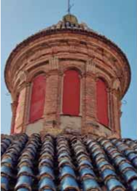
Linterna con los vanos cegados y el color apagado (izquierda) y tras su restauración (derecha) / Lanterna con le aperture tamponate e il colore sbiadito (a sinistra) e dopo il restauro (a destra) / Lantern with the openings blocked and its color faded (left) and after its restoration (right) / Lanterne avec les ouvertures obturées et la couleur altérée (à gauche) et après sa restauration (à droite)
