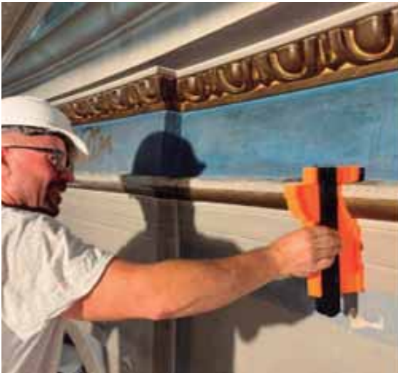
Levantamiento con perfilador arqueológico para redibujar su arquitectura / Rilievo con pettine archeologico per ridisegnarne l'architettura / Survey with an archaeological comb to redraw its architecture / Relevé au moyen d'un peigne archéologique pour redessiner son architecture
