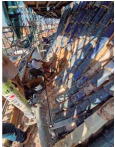
Refuerzo de las nervaduras con malla de fibra de basalto y mortero de cal (izquierda) y sustitución de tejas (derecha) / Rinforzo delle nervature con rete in fibra di basalto e malta di calce (a sinistra) e sostituzione delle tegole (a destra) / Reinforcement of ribs with basalt fiber mesh and lime mortar (left) and replacement of tiles (right) / Renforcement des nervures à l'aide d'un treillis en fibre de basalte et de mortier de chaux (à gauche) et remplacement des tuiles (à droite)
