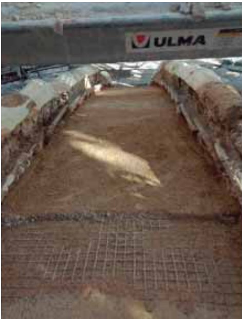
Refuerzo de las nervaduras con malla de fibra de basalto y mortero de cal (izquierda) y sustitución de tejas (derecha) / Rinforzo delle nervature con rete in fibra di basalto e malta di calce (a sinistra) e sostituzione delle tegole (a destra) / Reinforcement of ribs with basalt fiber mesh and lime mortar (left) and replacement of tiles (right) / Renforcement des nervures à l'aide d'un treillis en fibre de basalte et de mortier de chaux (à gauche) et remplacement des tuiles (à droite)
