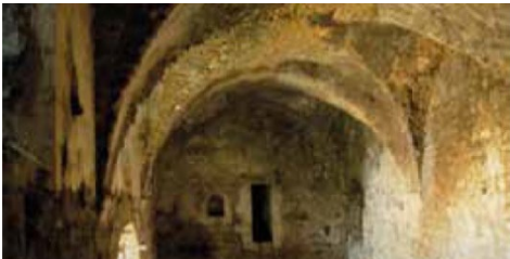
Fig. 6- Veduta delle volte a crociera presenti nella torre orientale.
