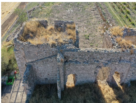
Fig. 7- Vista dall'alto delle tracce in negativo del solaio piano del vano centrale e del solaio a spiovente dell'ampliamento laterale (foto dell'autrice, 2024).
