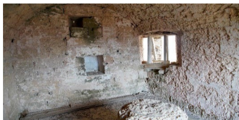
Fig. 6- Interno dell'ambiente 10 (foto di I. Ferrari, 2024).
