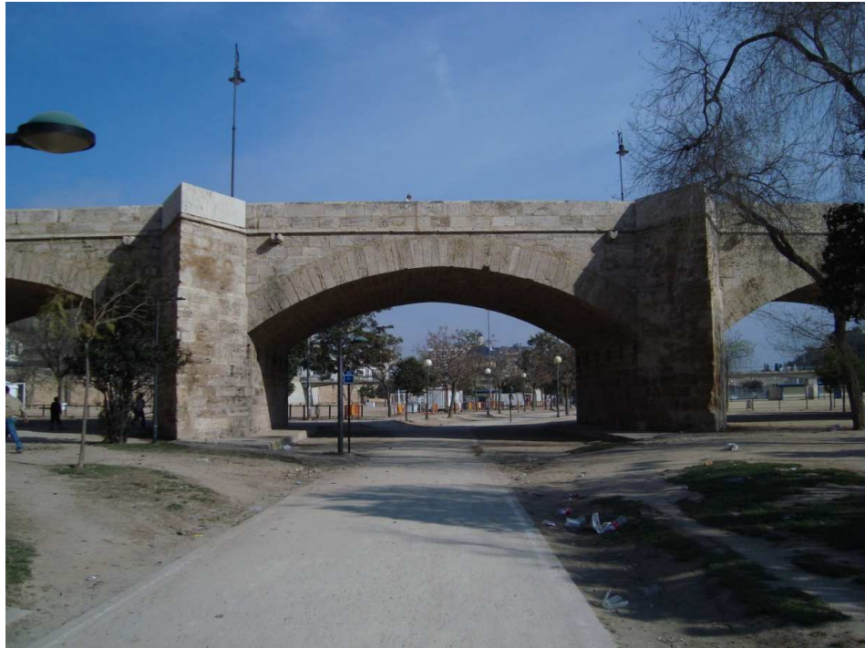
Figura 22. Puente de Serranos. Fotografía V. Yepes.
