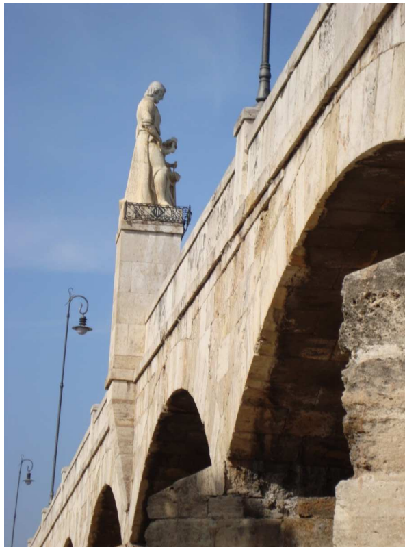
Figura 55. Puente de San José. Fotografía de V. Yepes.
