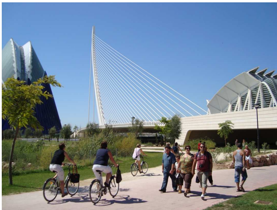
Figura 95. Puente del Assut d'Or, de Calatrava. Fotografía V. Yepes.
