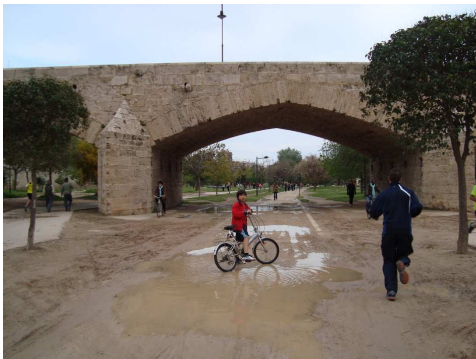
Figura 34. Puente de la Trinidad. Fotografía V. Yepes.
