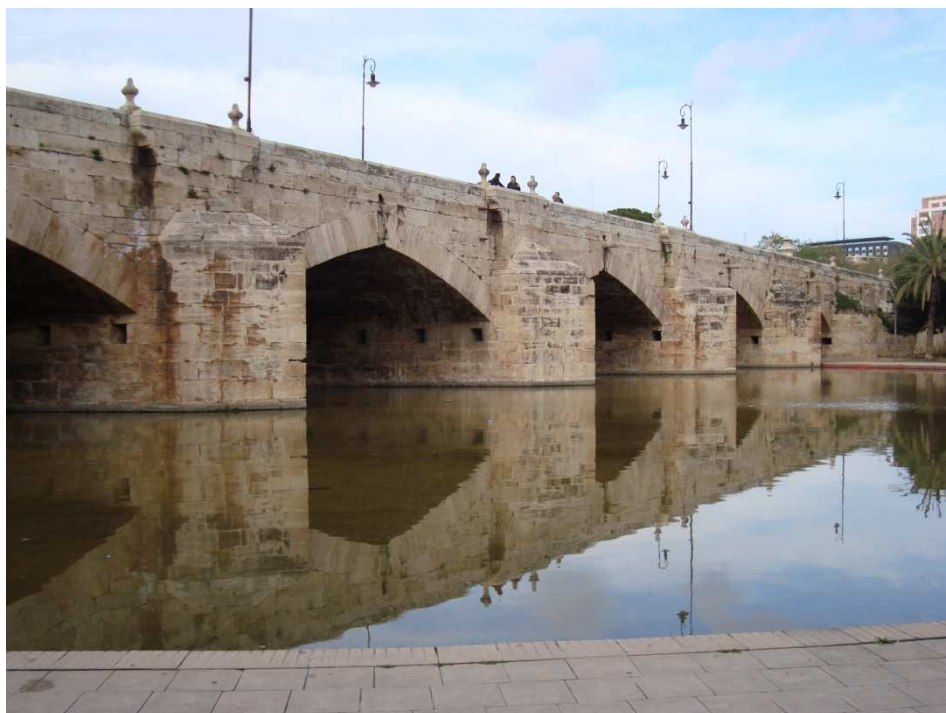
Figura 48. Puente del Mar. Fotografía V. Yepes.
