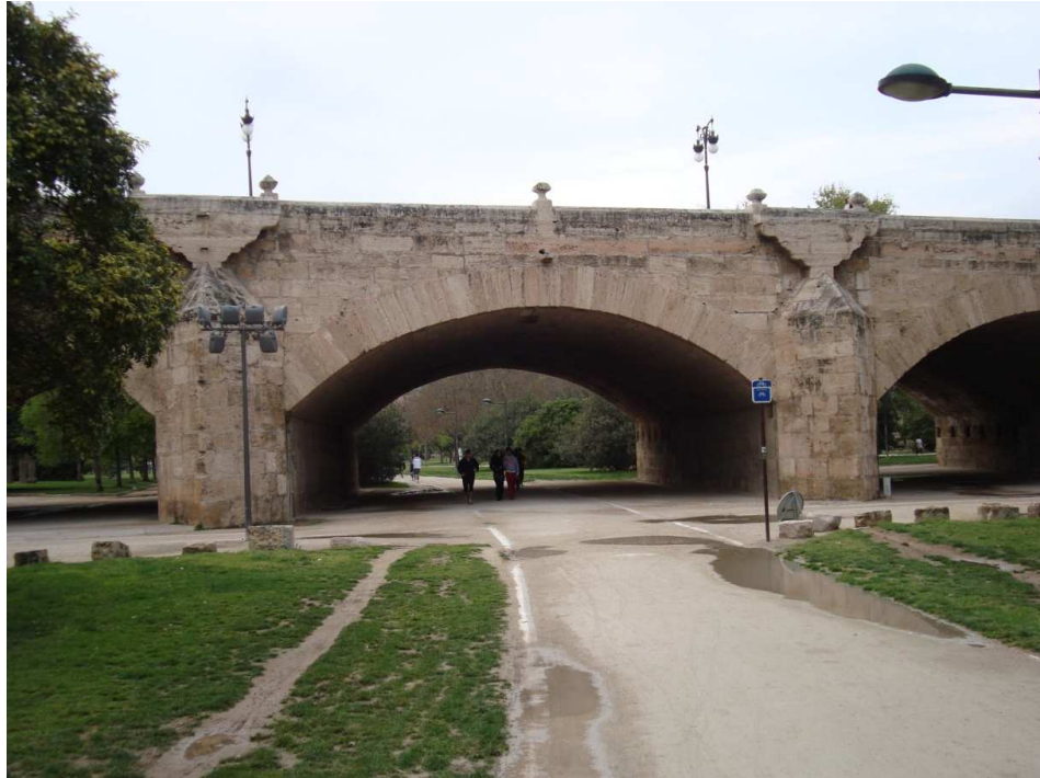
Figura 38. Puente del Real. Fotografía V. Yepes.
