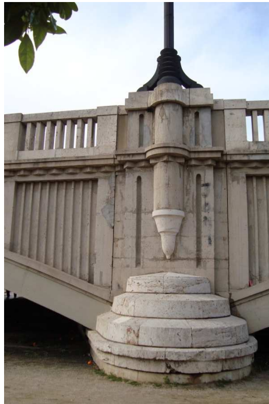
Figura 84. Detalle del tajamar del puente de Aragón. Fotografía de V. Yepes.
