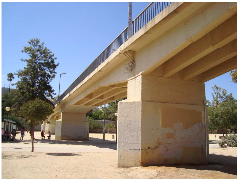
Figura 73. Pasarela actual. Fotografía de V. Yepes.
