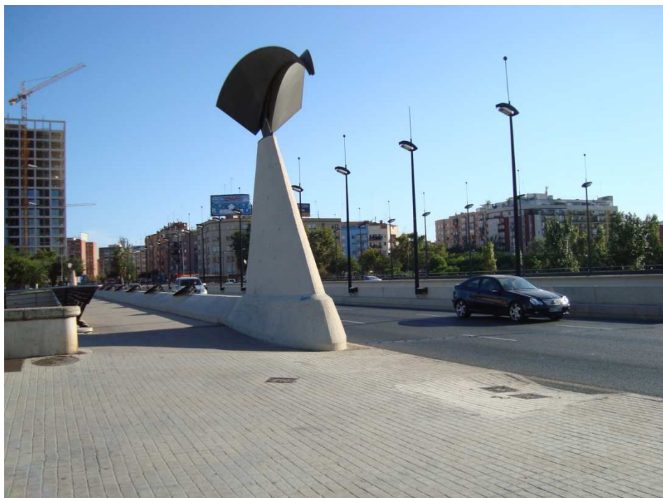
Figura 60. Puente Nueve de Octubre. Fotografía V. Yepes.
