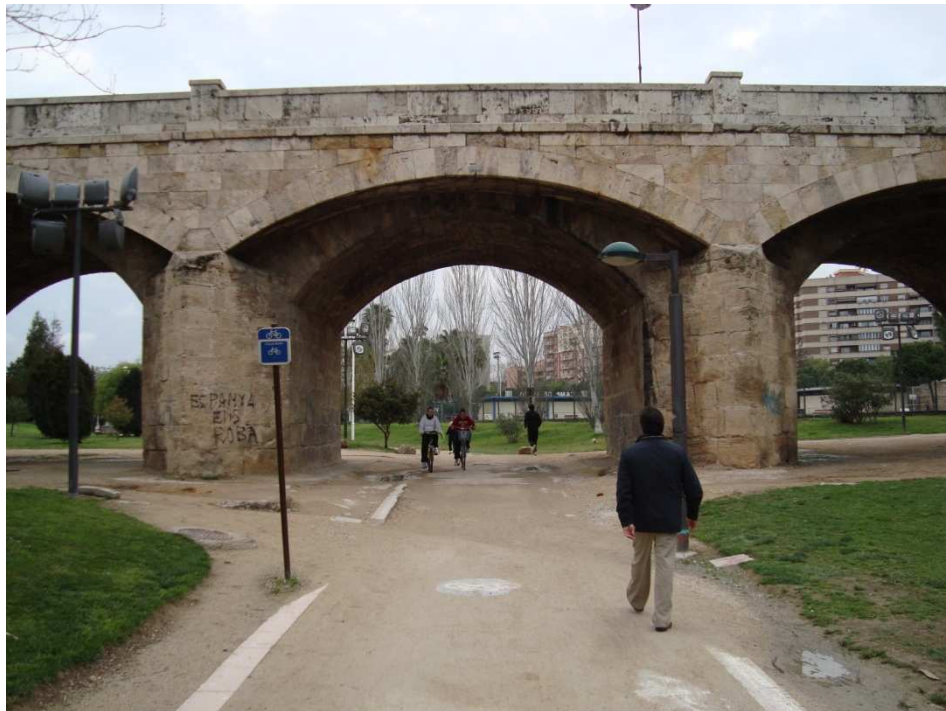
Figura 51. Puente de San José. Fotografía V. Yepes.
