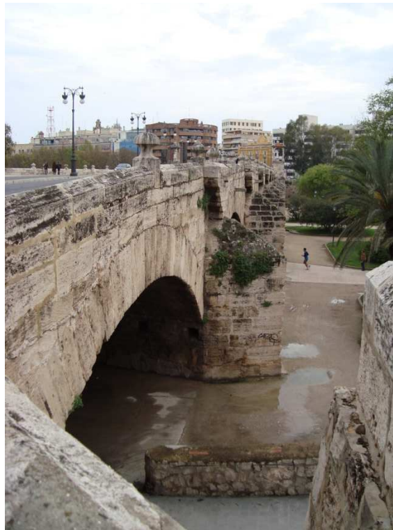
Figura 42. Puente del Real. Fotografía V. Yepes.
