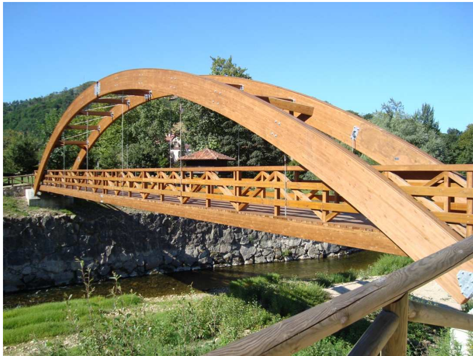
Figura 7. Ejemplo de puente arco de madera. Cangas de Onís (Asturias). Fotografía V. Yepes.
