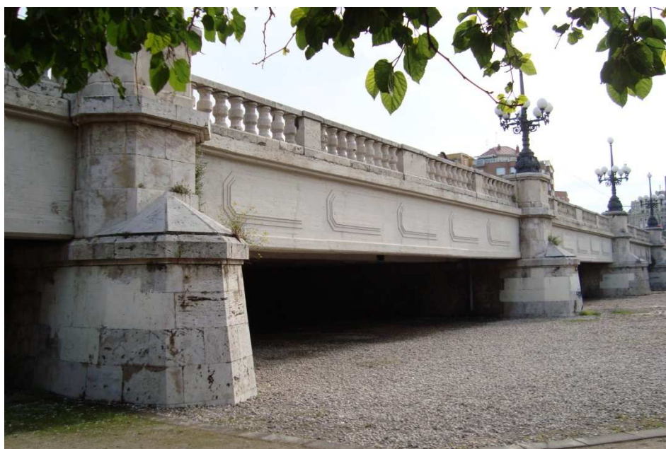
Figura 90. Puente del Ángel Custodio. Fotografía V. Yepes.
