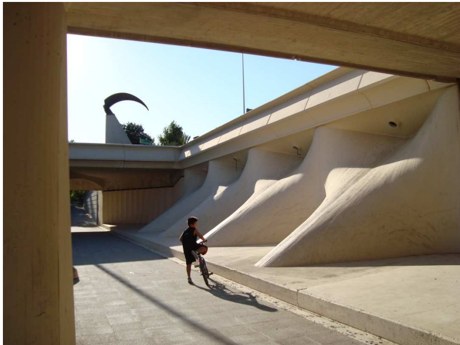
Figura 63. Puente Nueve de Octubre. Fotografía V. Yepes.
