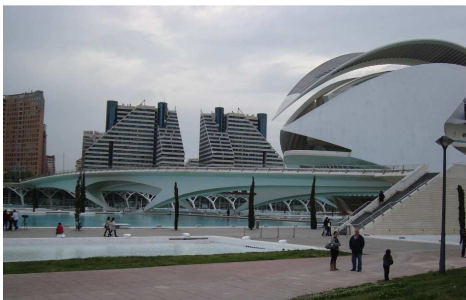
Figura 96. Puente de Monteolivete. Tramo Calatrava. Fotografía V. Yepes.
