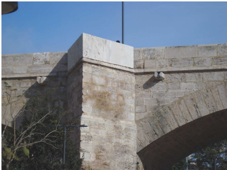
Figura 23. Puente de Serranos. Fotografía V. Yepes.
