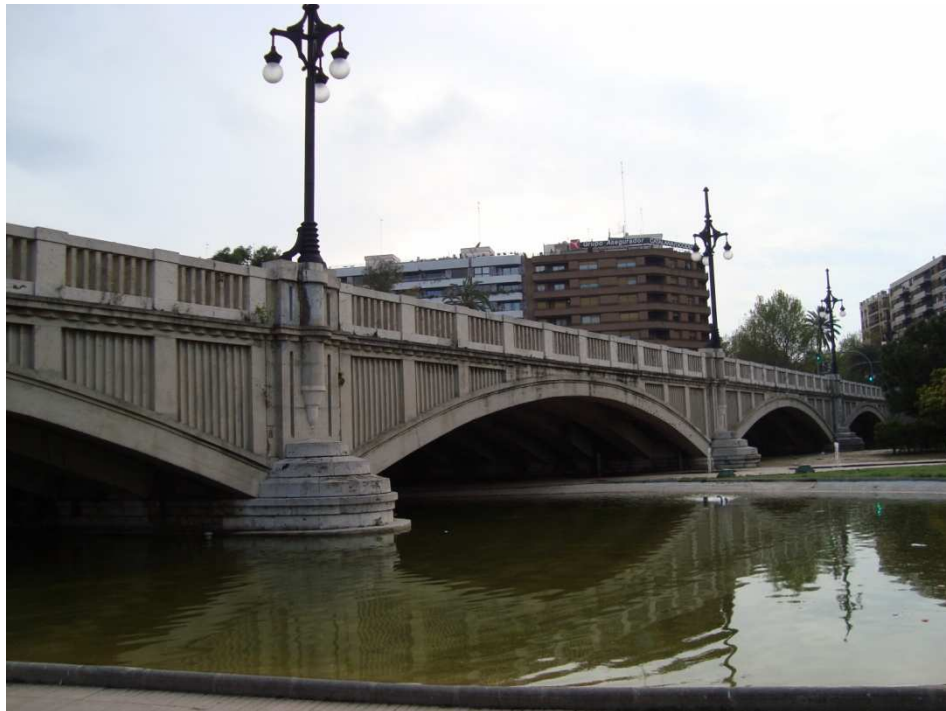
Figura 82. Puente de Aragón. Fotografía V. Yepes.
