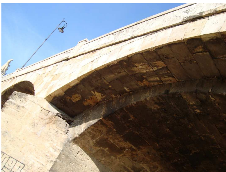
Figura 54. Puente de San José. Fotografía de V. Yepes.
