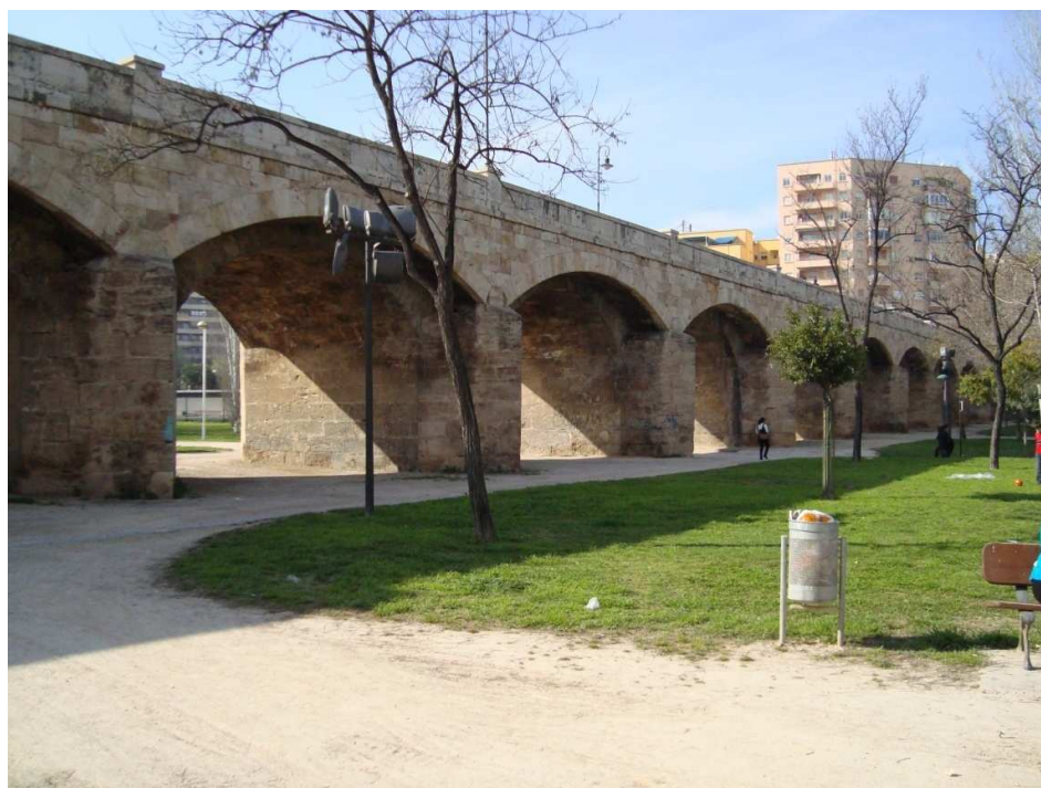
Figura 50. Puente de San José. Fotografía V. Yepes.
