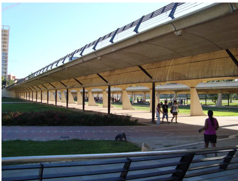
Figura 57. Puente Nueve de Octubre. Fotografía V. Yepes.
