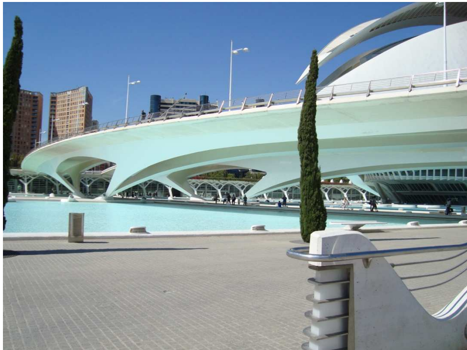
Figura 99. Puente de Monteolivete. Tramo Calatrava. Fotografía V. Yepes.
