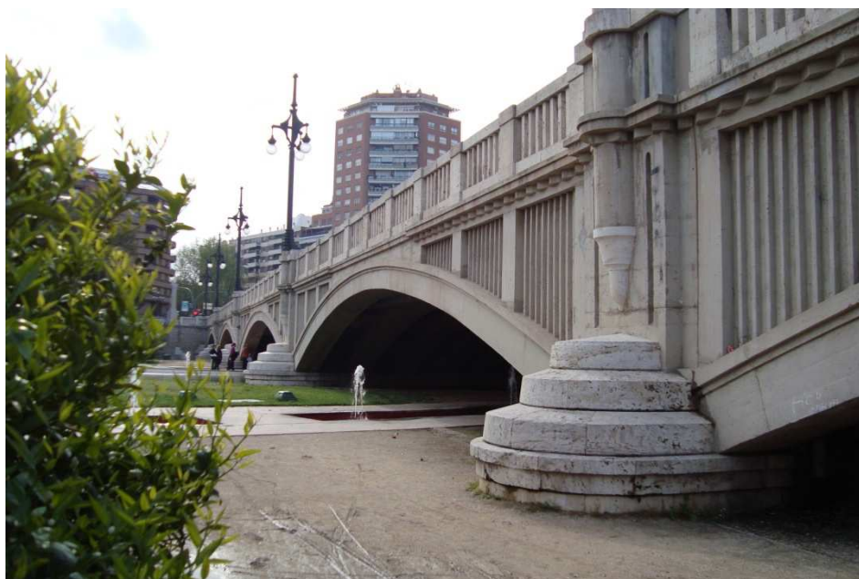
Figura 81. Puente de Aragón. Fotografía V. Yepes.
