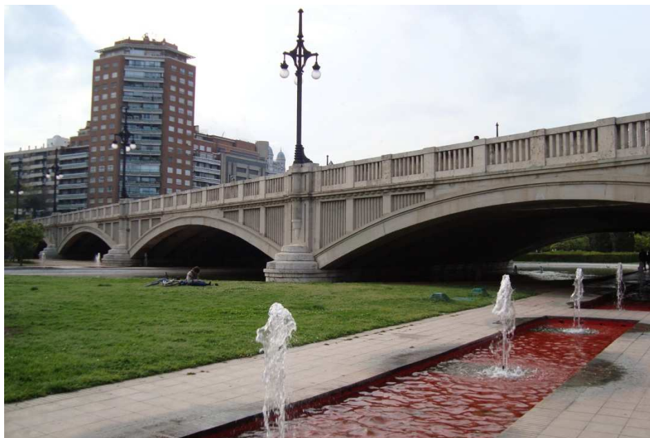
Figura 80. Puente de Aragón. Fotografía V. Yepes.
