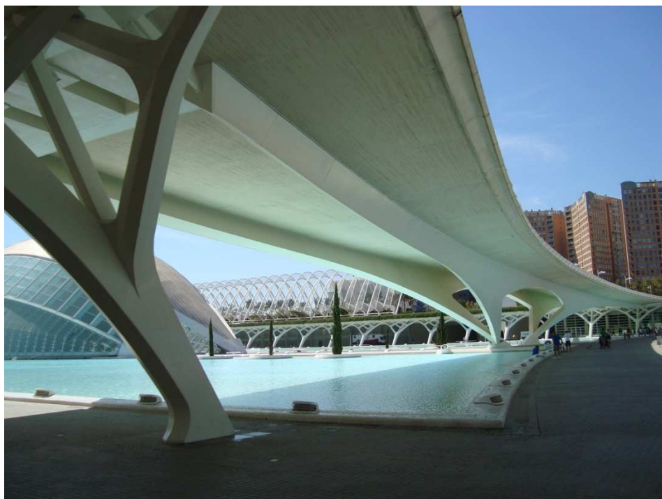
Figura 98. Puente de Monteolivete. Tramo Calatrava. Fotografía V. Yepes.
