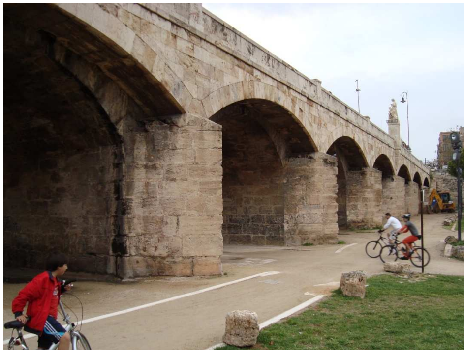
Figura 56. Puente de San José. Fotografía V. Yepes.
