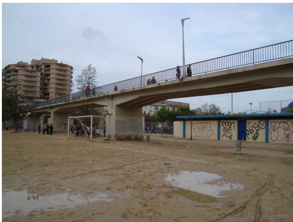
Figura 75. Pasarela actual. Fotografía V. Yepes.
