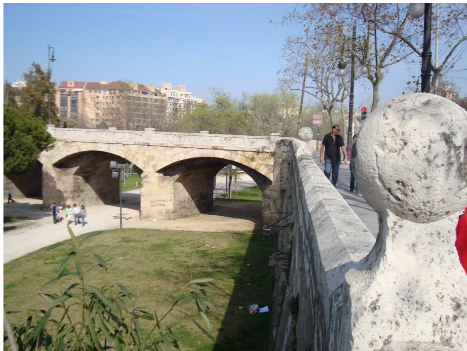
Figura 52. Puente de San José. Fotografía V. Yepes.
