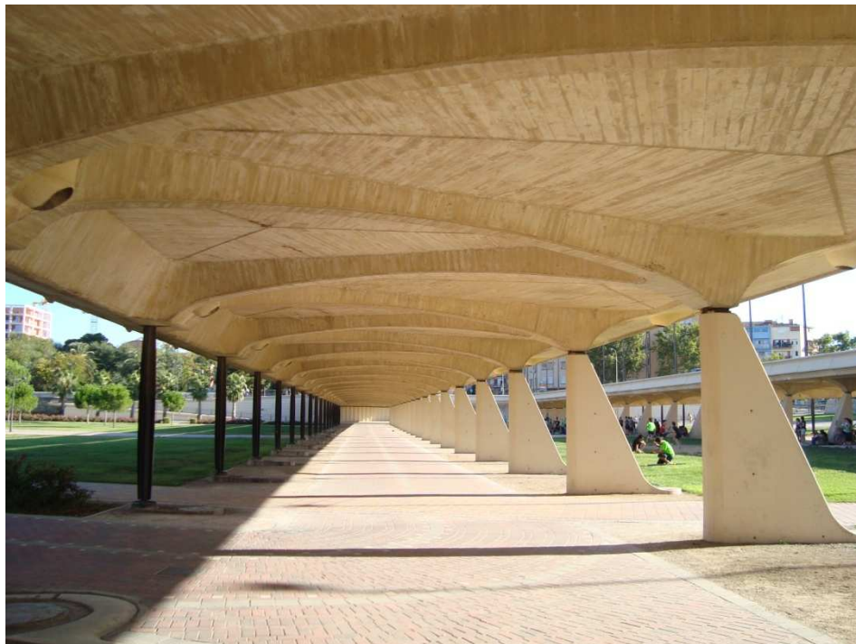
Figura 62. Vista inferior tablero Puente Nueve de Octubre. Fotografía V. Yepes.
