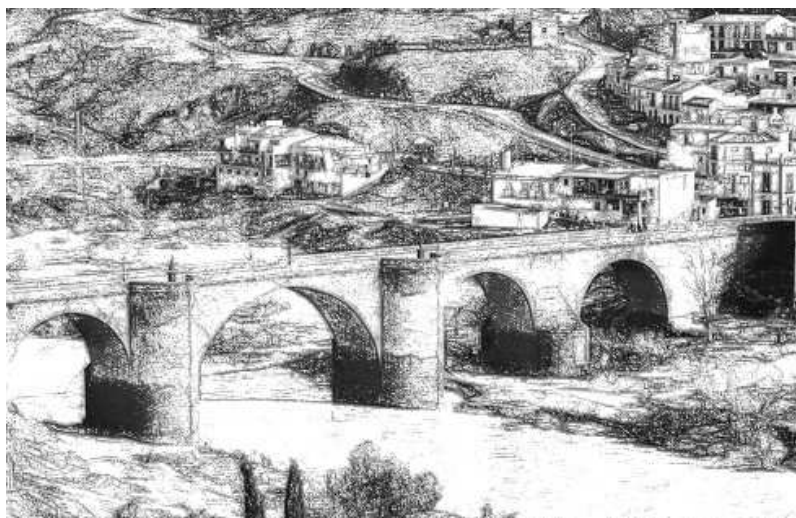
Figura 13. Puente de Montoro 35 .
