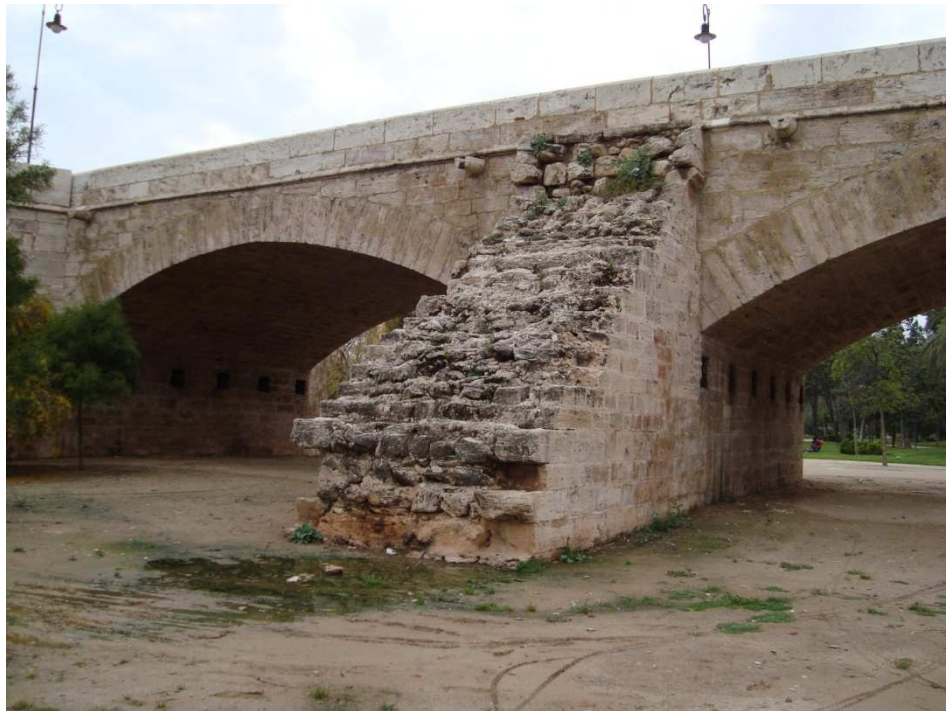
Figura 28. Puente de Serranos. Fotografía V. Yepes.
