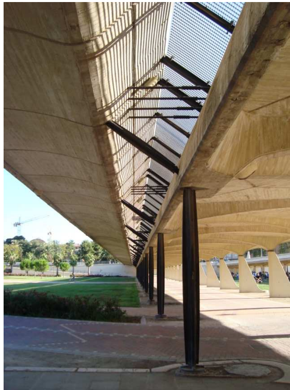
Figura 61. Vista inferior tablero Puente Nueve de Octubre. Fotografía V. Yepes.
