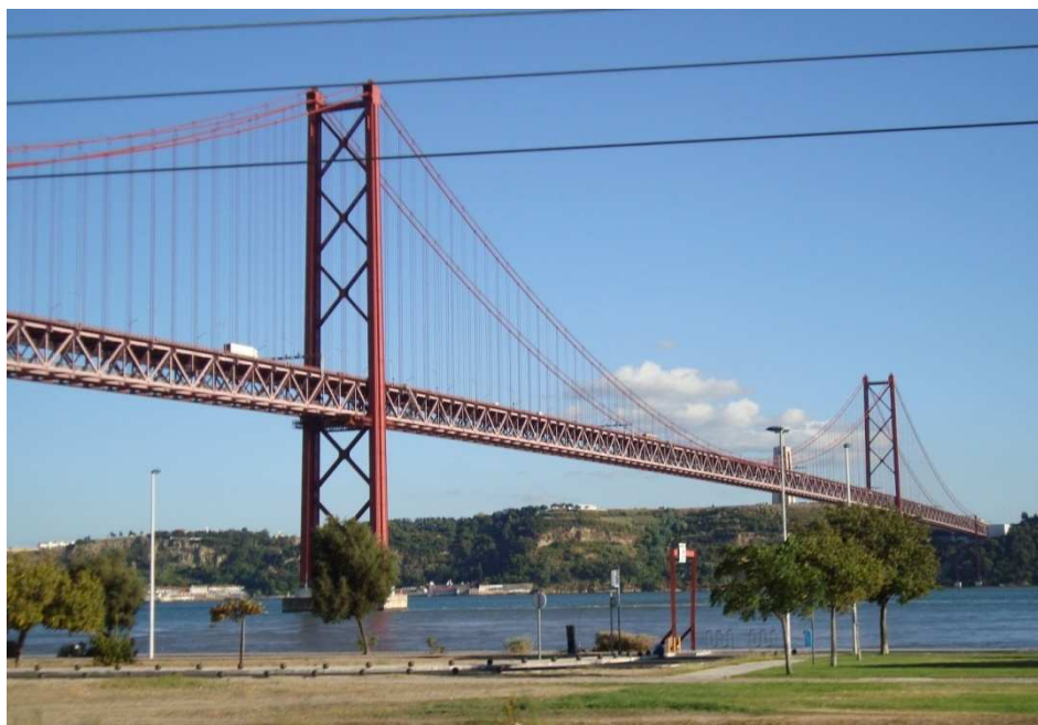
Figura 2. Puente sobre el estuario del Tajo, en Lisboa 2 . Fotografía V. Yepes.
