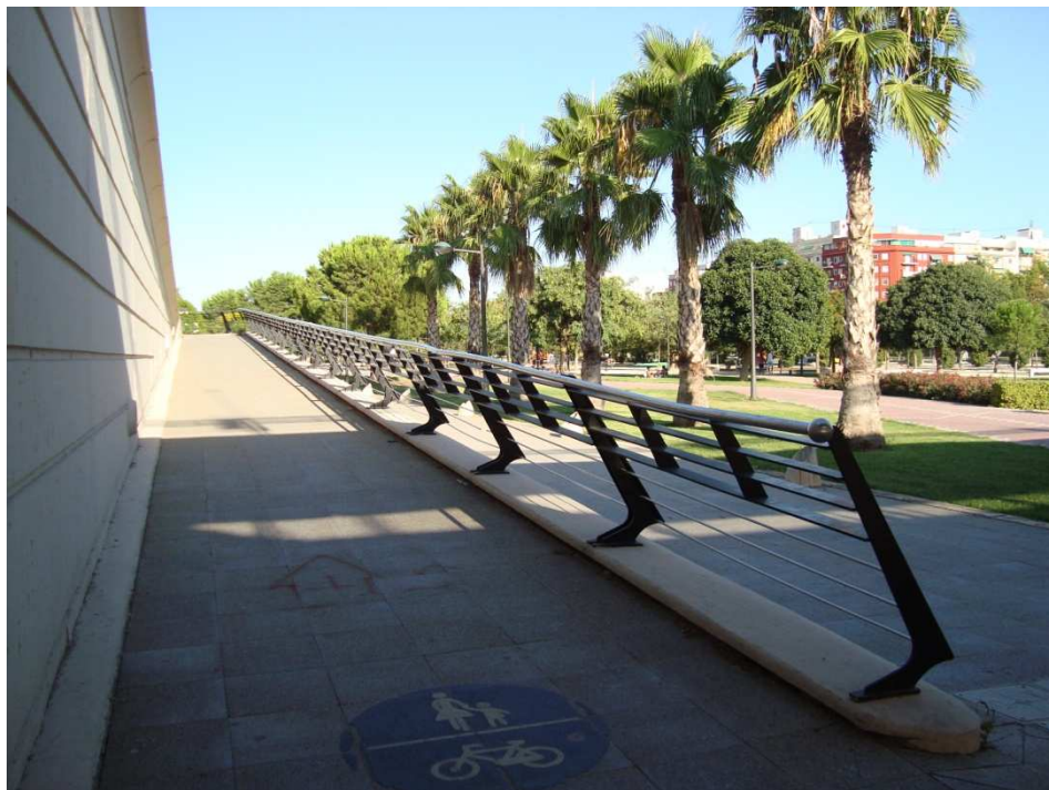
Figura 64. Puente Nueve de Octubre. Fotografía V. Yepes.
