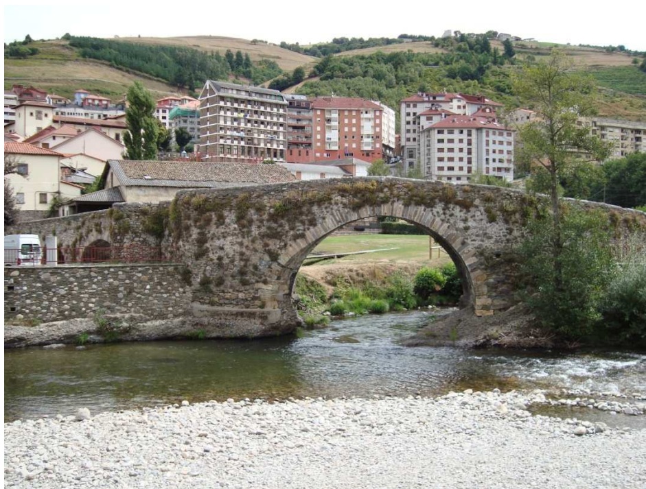
Figura 10. Puente de Cangas del Narcea (Asturias). Fotografía de V. Yepes.
