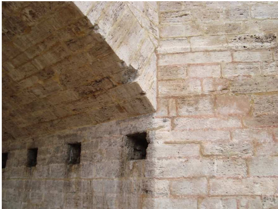
Figura 24. Puente de Serranos. Fotografía V. Yepes.
