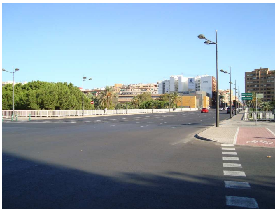
Figura 67. Puente de Campanar. Fotografía V. Yepes.
