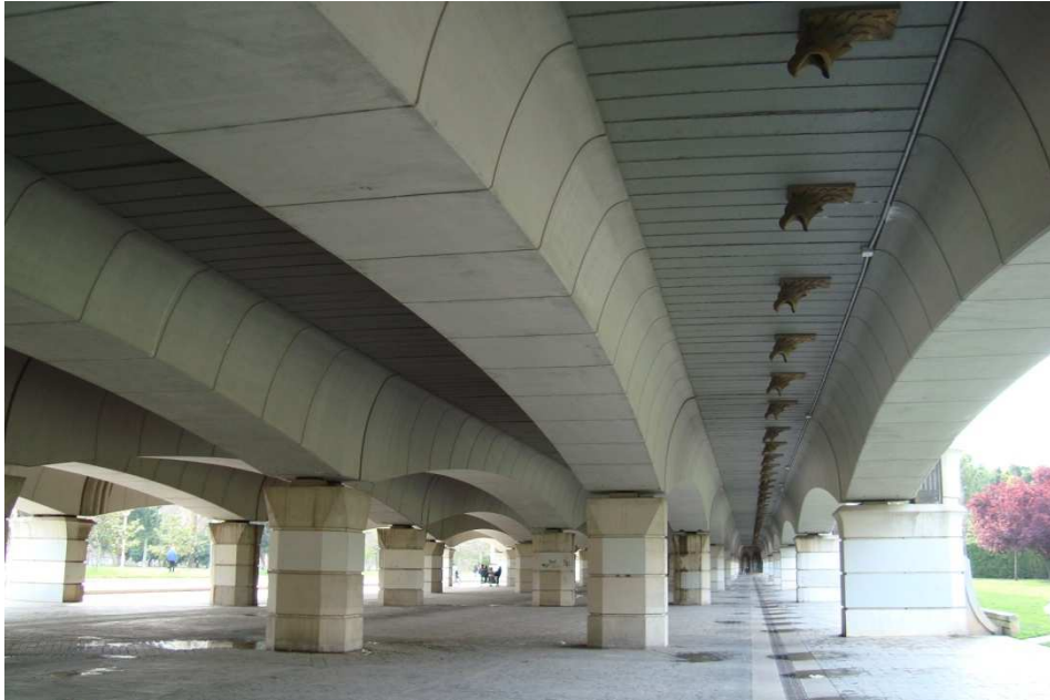
Figura 93. Detalle inferior del tablero del puente del Reino. Fotografía V. Yepes.
