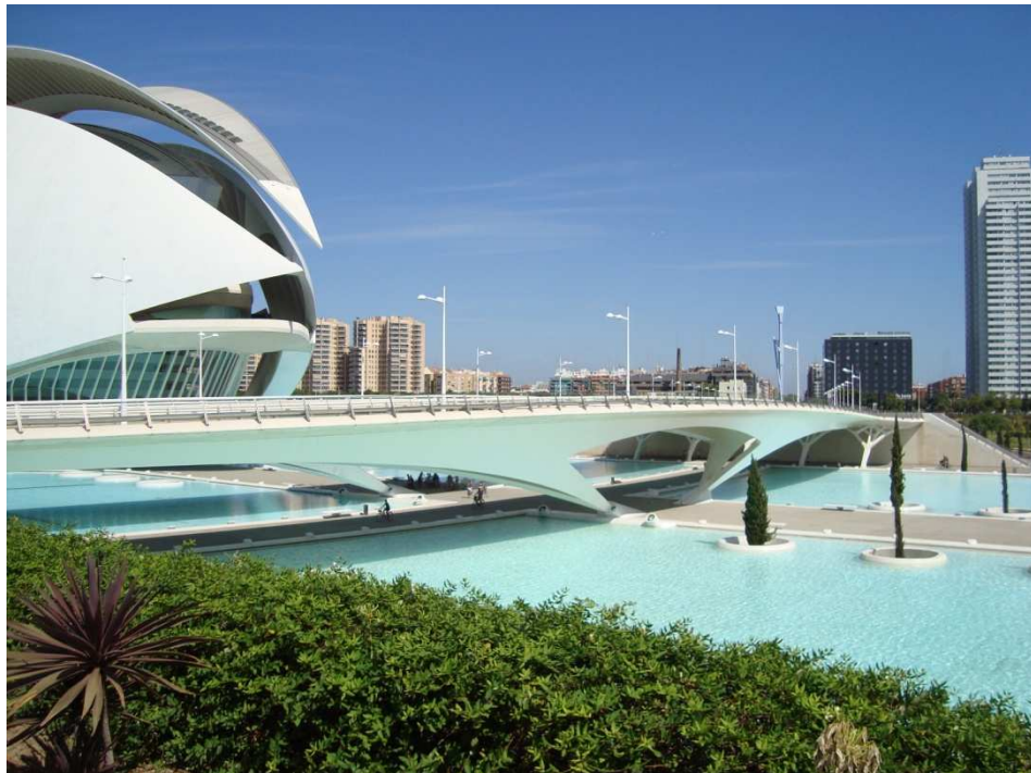
Figura 97. Puente de Monteolivete. Tramo Calatrava. Fotografía V. Yepes.
