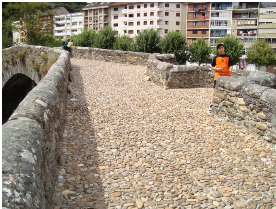
Figura 11. Trazado quebrado y arrimaderos en el puente medieval de Cangas del Narcea (Asturias). Fotografía de V. Yepes.
