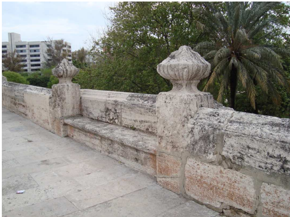
Figura 41. Detalle del pretil del Puente del Real. Fotografía V. Yepes.
