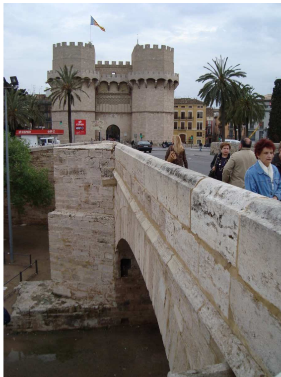
Figura 25. Puente de Serranos. Fotografía V. Yepes.
