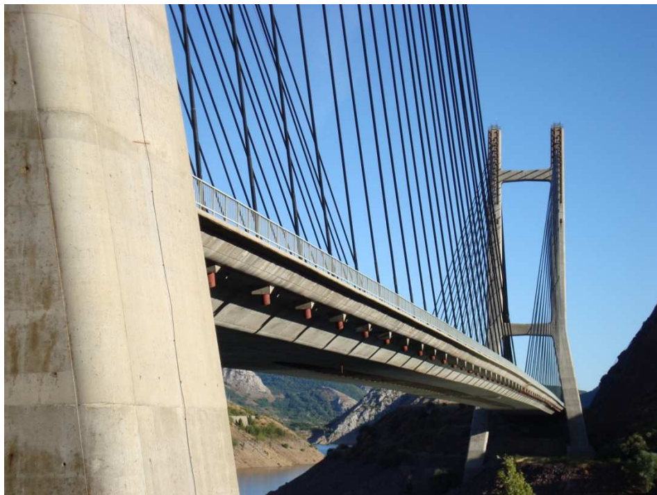
Figura 1. Puente sobre el embalse de Barrios de Luna 1 . Fotografía V. Yepes.
