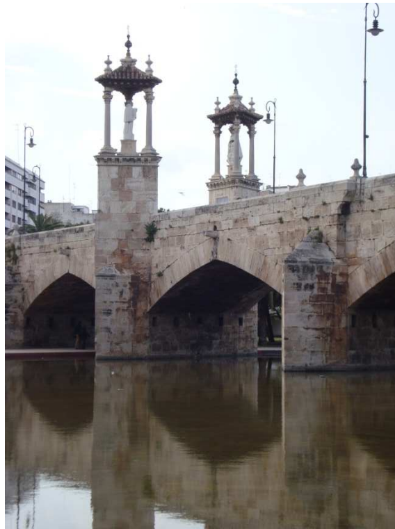
Figura 49. Puente del Mar. Fotografía V. Yepes.
