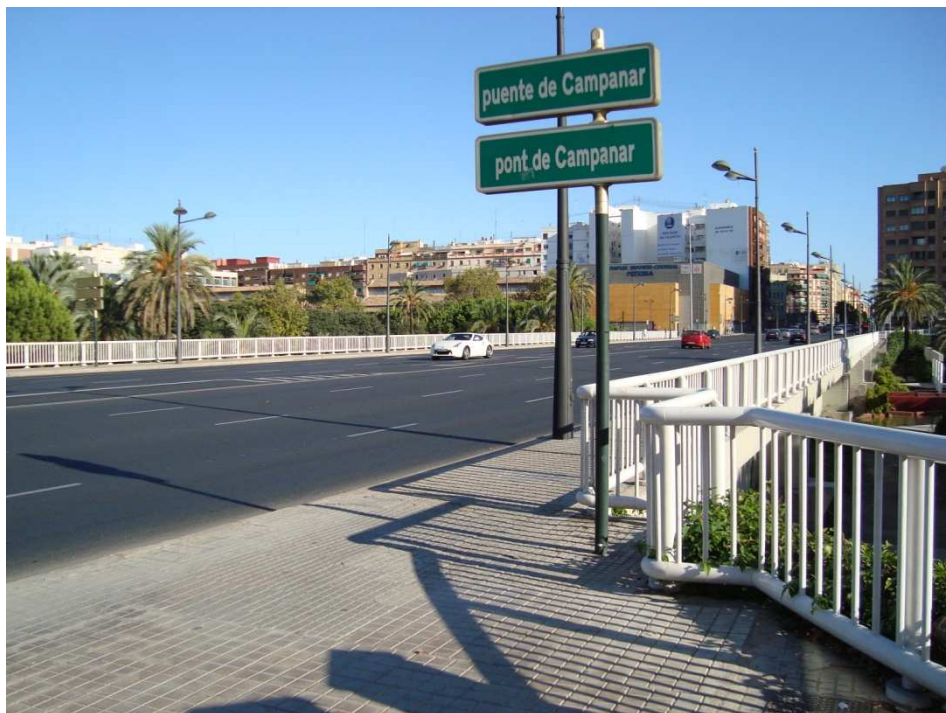
Figura 65. Puente de Campanar. Fotografía V. Yepes.
