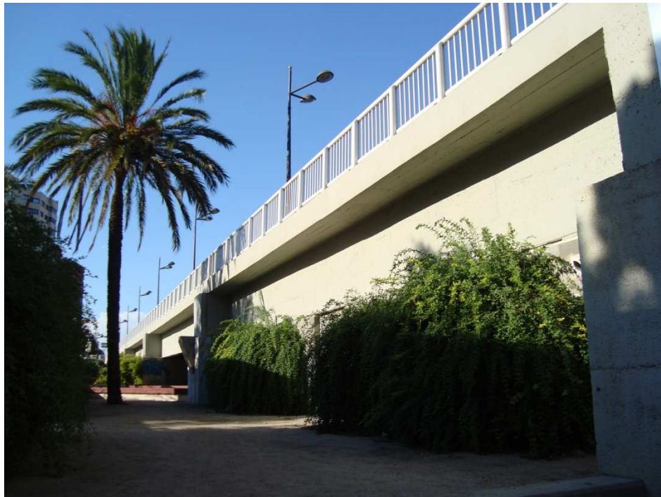
Figura 68. Puente de Campanar. Fotografía V. Yepes.
