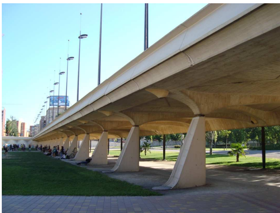
Figura 58. Puente Nueve de Octubre. Fotografía V. Yepes.
