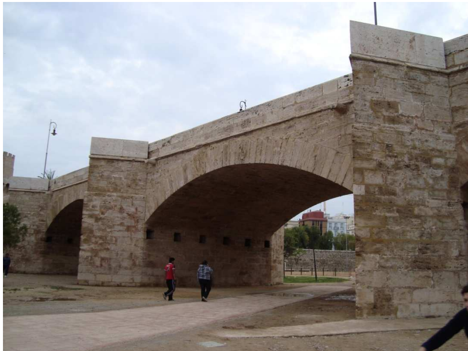
Figura 26. Puente de Serranos. Fotografía V. Yepes.
