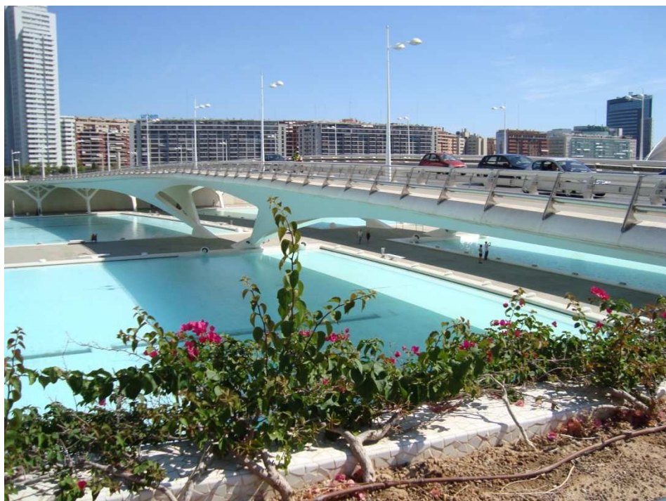
Figura 100. Puente de Monteolivete. Tramo Calatrava. Fotografía V. Yepes.
