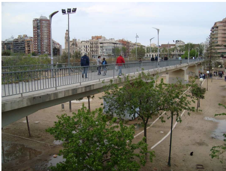
Figura 74. Pasarela actual. Fotografía V. Yepes.
