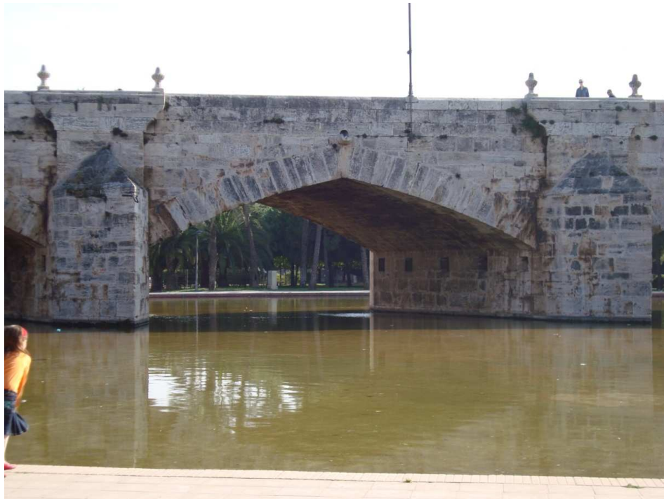
Figura 47. Puente del Mar. Fotografía V. Yepes.
