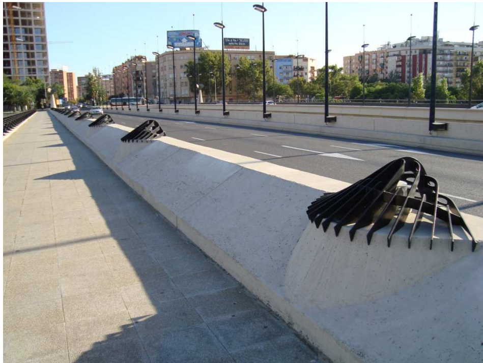
Figura 59. Puente Nueve de Octubre. Fotografía V. Yepes.
