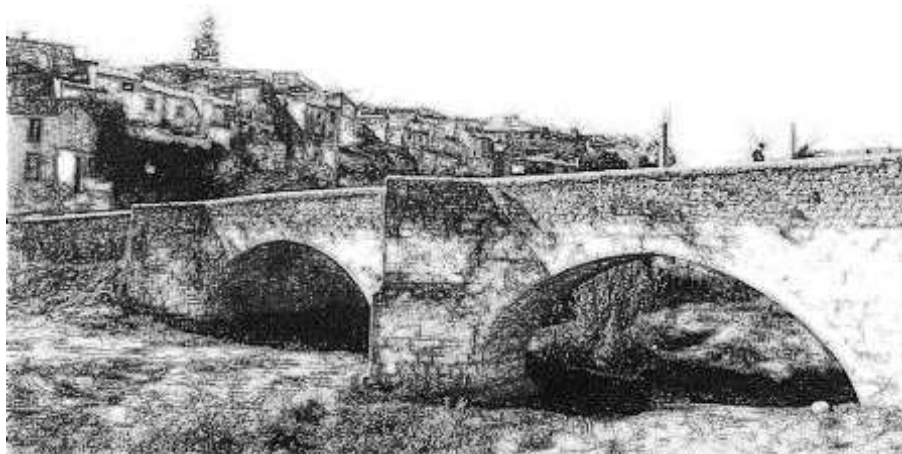
Figura 16. Puente viejo de Ontinyent 38 .
