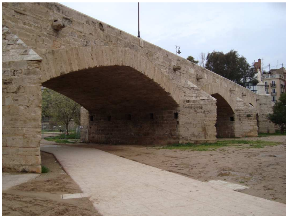
Figura 30. Puente de la Trinidad. Fotografía V. Yepes.
