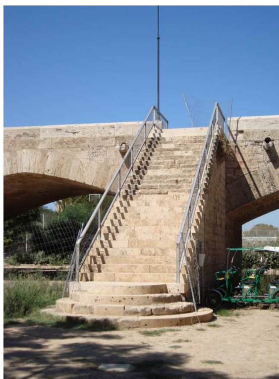
Figura 31. Puente de la Trinidad. Escaleras aguas abajo reparada. Fotografía V. Yepes.
