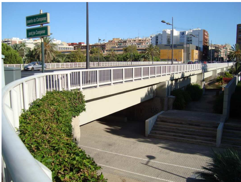
Figura 66. Puente de Campanar. Fotografía V. Yepes.
