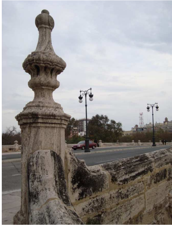
Figura 40. Puente del Real. Fotografía V. Yepes.
