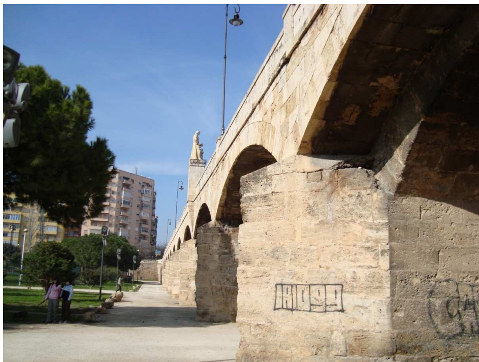
Figura 53. Puente de San José. Fotografía V. Yepes.
