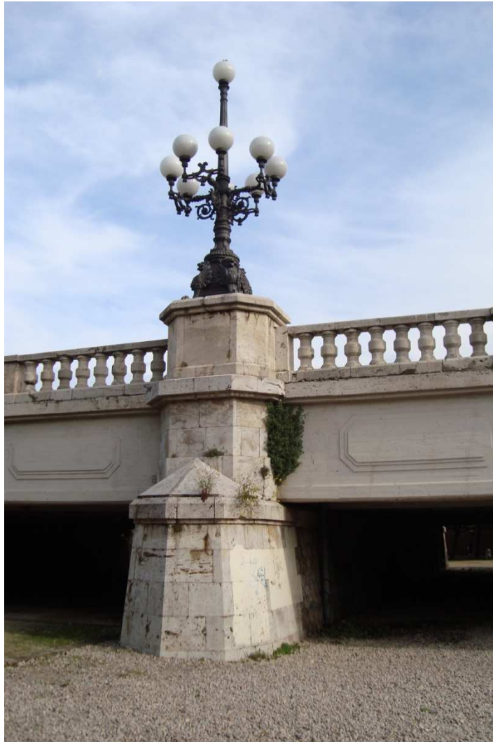
Figura 91. Detalle de tajamar y farola del puente del Ángel Custodio. Fotografía V. Yepes.
