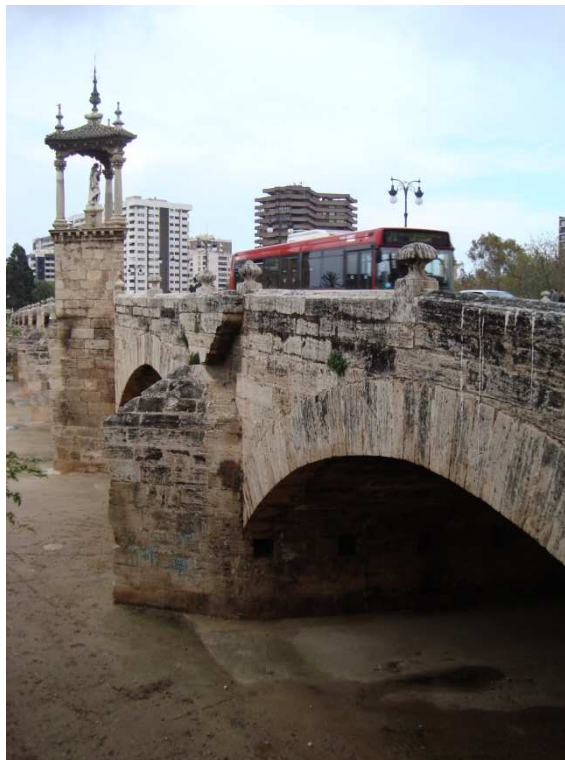
Figura 43. Puente del Real. Fotografía V. Yepes.
