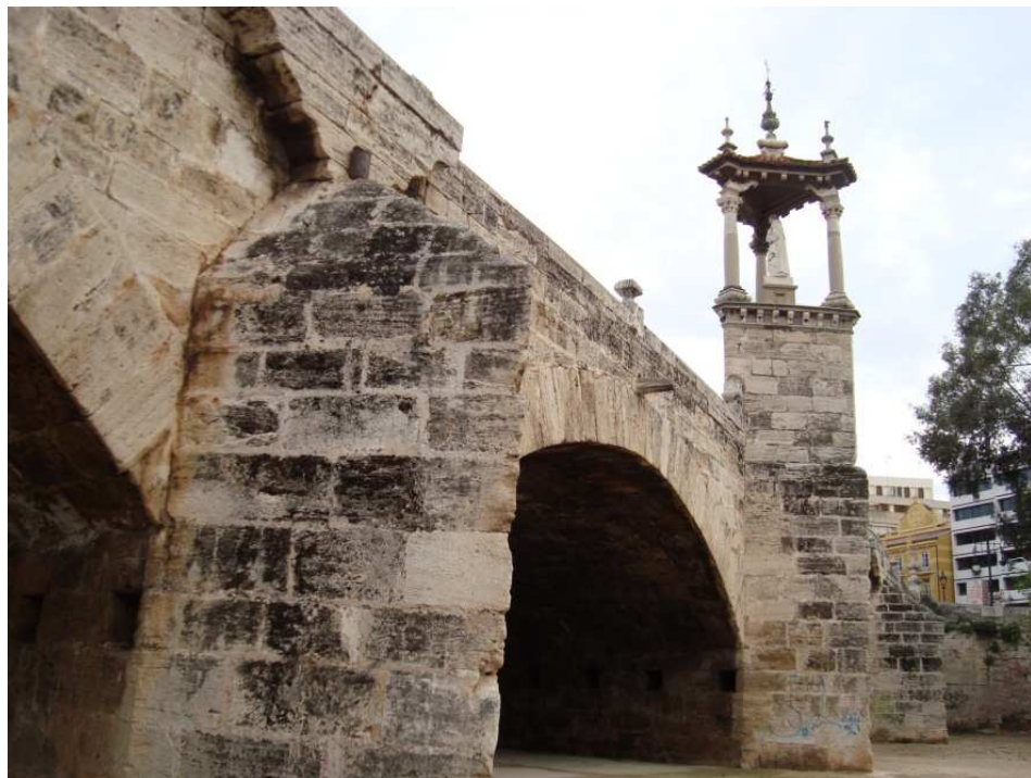
Figura 39. Puente del Real. Fotografía V.Yepes.
