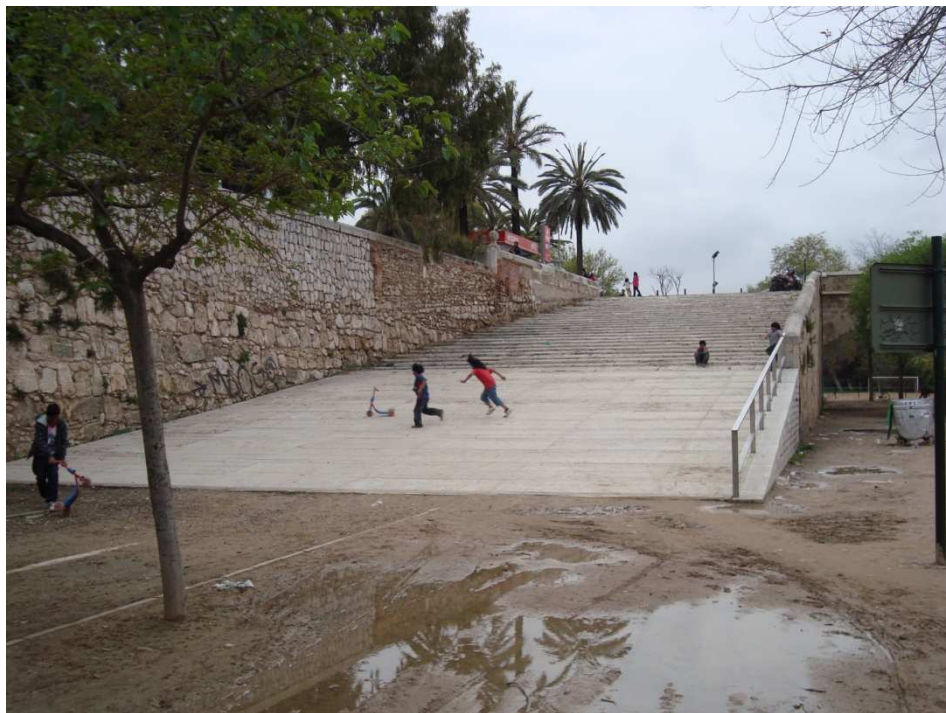
Figura 29. Rampa de acceso del Puente de Serranos. Fotografía V. Yepes.
