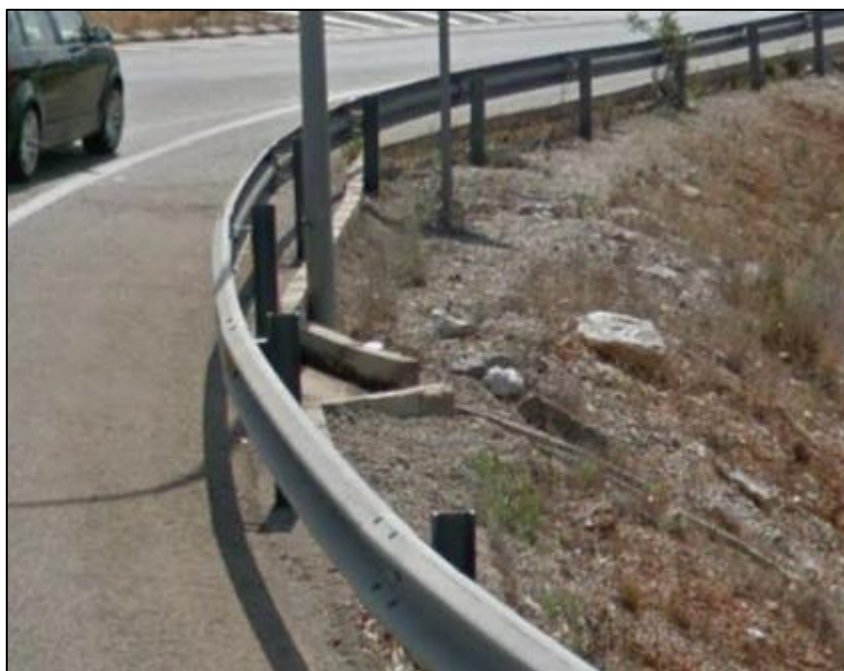
Figura 29-c. Conexión de la carretera con el elemento bajante. Ubicación: ramal de salida de la CV-725 sentido AP-7 - Alicante. Fuente: Google Maps.
