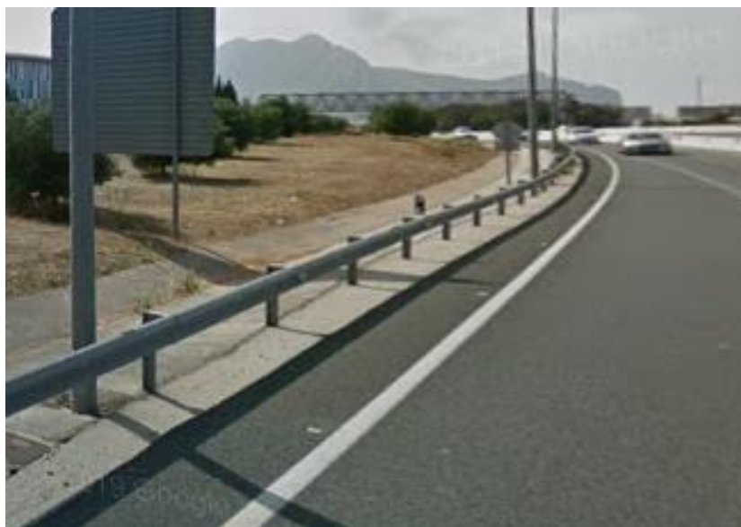
Figura 29-a. Vista de la cuneta en la vía colectora-distribuidora de la N-332 sentido Valencia-Alicante, Fuente: Google Maps.
