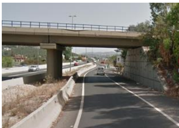
Figura 17. Tramo debajo del puente, vía colectora de la N-332. Fuente: Google Maps
