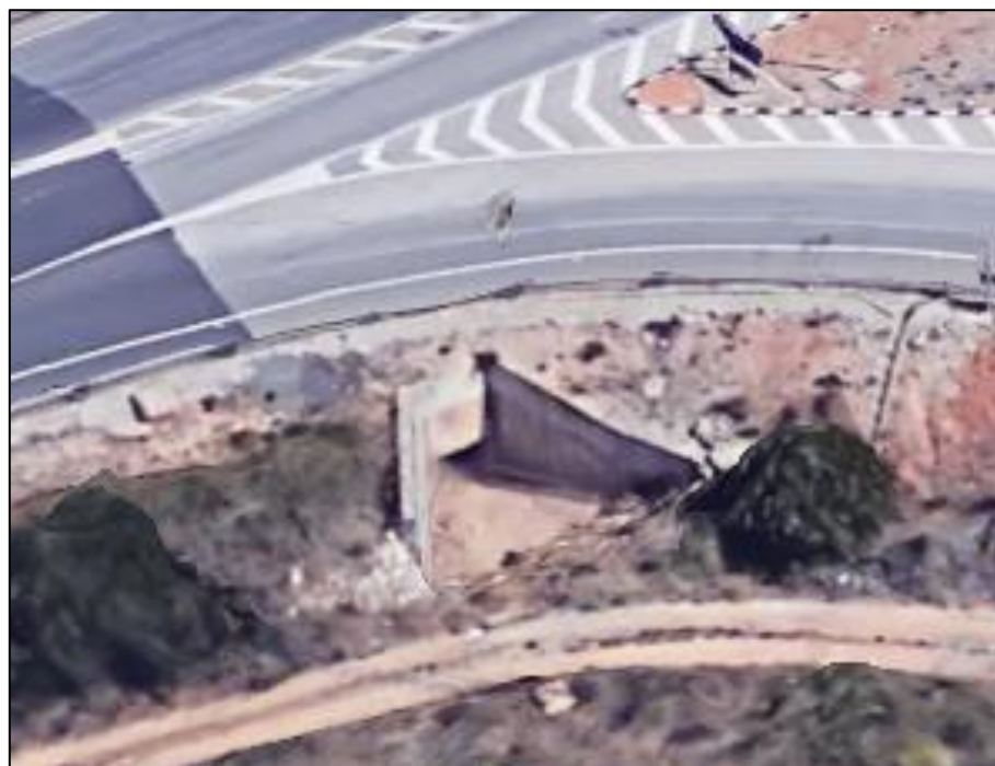
Figura 29-b. Obra de drenaje transversal en la carretera CV-725 (Foto: Sentido AP-7 - Denia). Fuente: Google Maps
