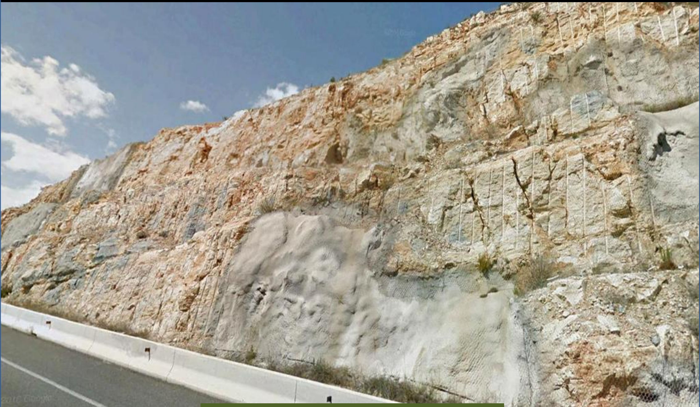
Gunitado y mallazo en las calizas- karstificadas- del Cenomaniense, Cretácico Sup. SE de Villanueva de Alcolea, Castellón. SE Hoja de Cuevas de Vinromá.
