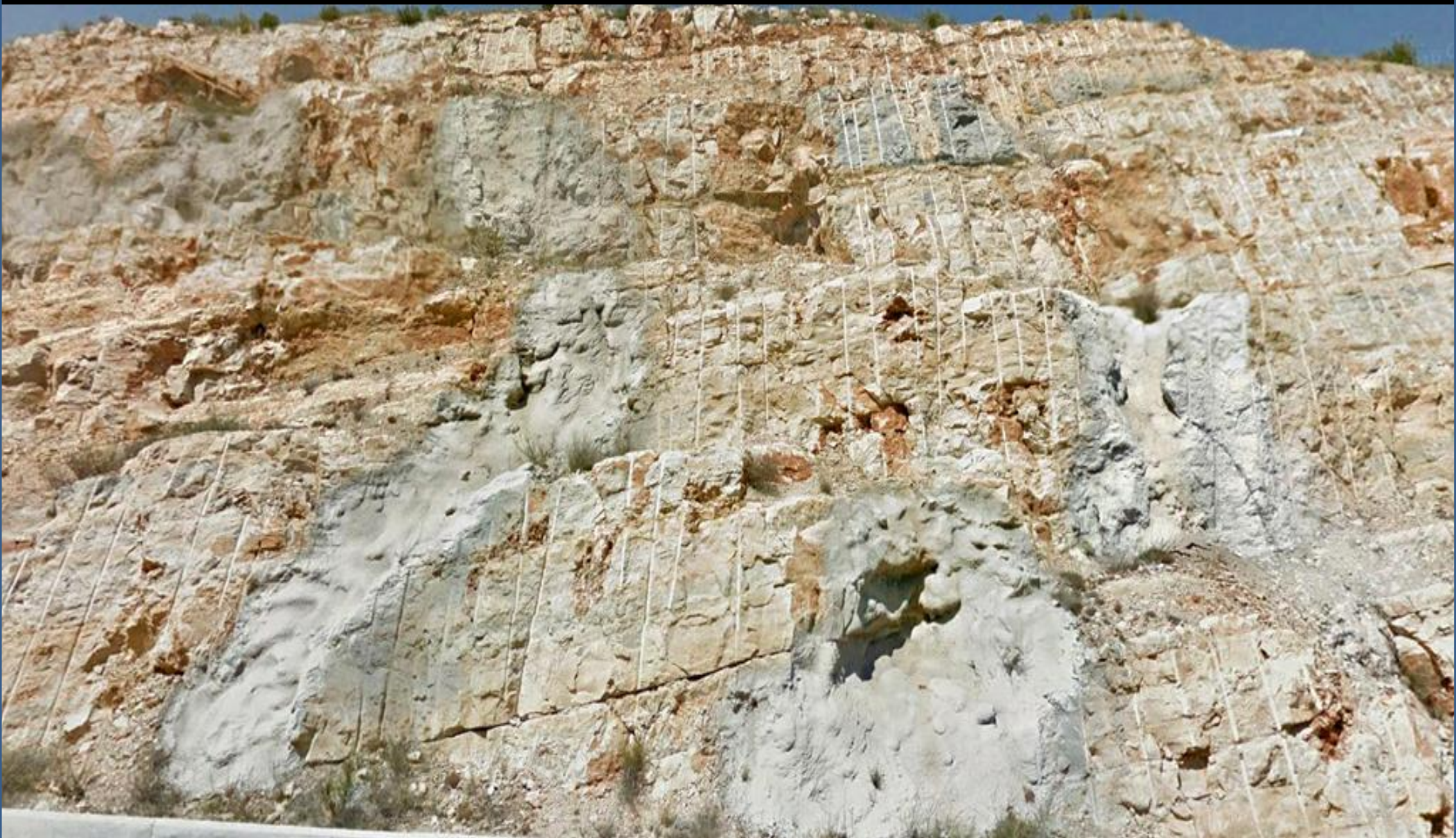
Gunitado en las calizas- karstificadas- del Cenomaniense, Cretácico Sup. SE de Villanueva de Alcolea, Castellón. SE Hoja de Cuevas de Vinromá.
