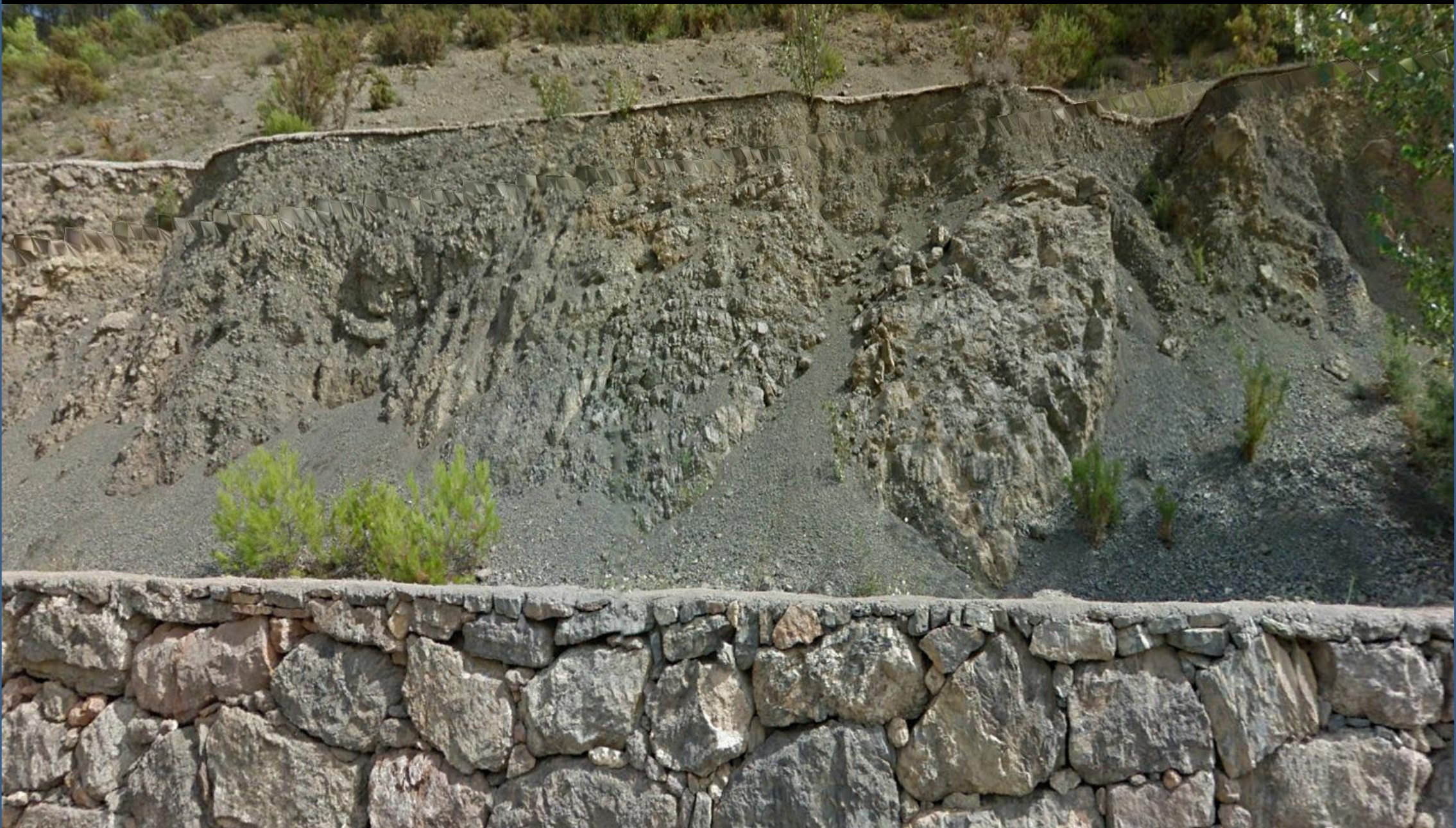
Muro pequeño de contención de las arcillas y margas yesíferas del Keuper, Triásico Sup. Barranco del Río de Vistabella. S de Villahermosa del Río, Castellón. SW Hoja.
