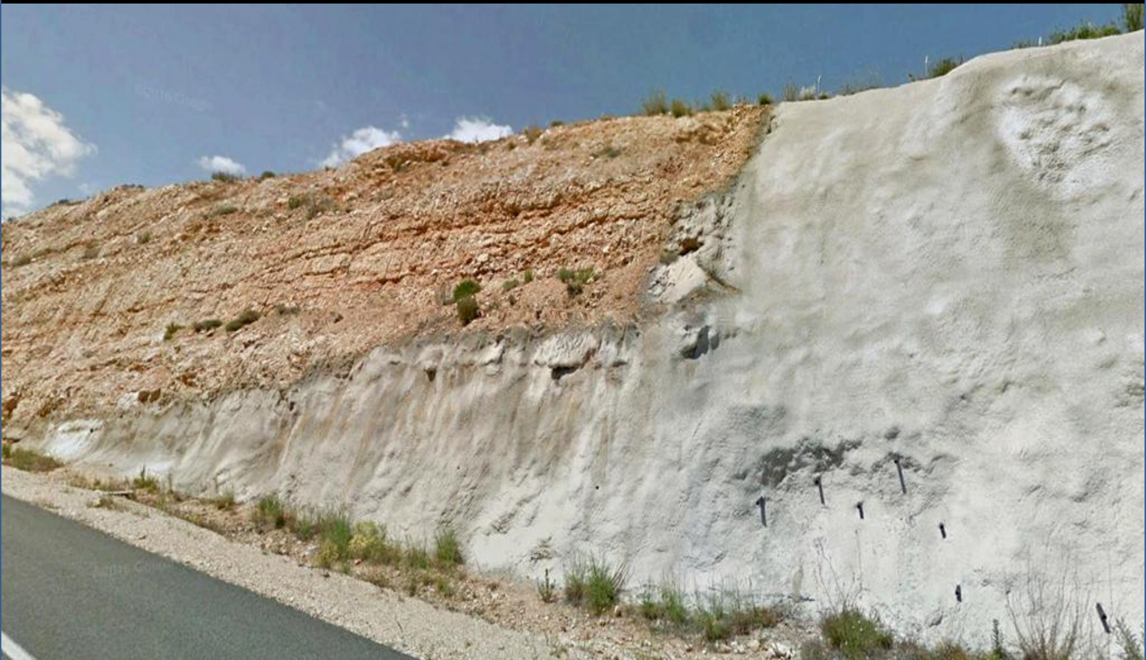
Gunitado y bulonado en los conglomerados de tipo pudingas, y pasadas areniscosas. Terciario. SE de Villanueva de Alcolea, Castellón. SE Hoja de Cuevas de Vinromá.
