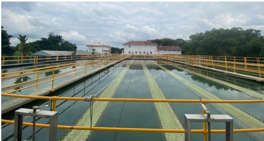
Figura 13. Canaletas diente de sierra en la tina de sedimentación
