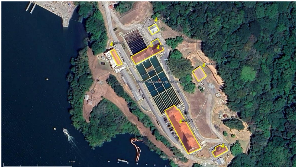
Figura 26. Techos existentes en la potabilizadora de Miraflores para la implementación de paneles solares
