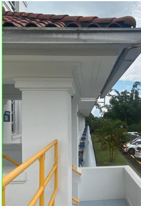
Figura 14. Tubería de influente a las tinas de filtración
