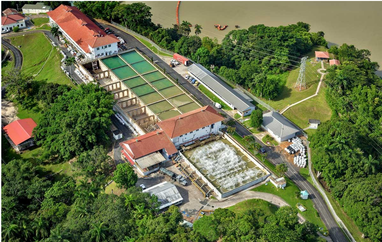
Figura 2. Vista aérea de la potabilizadora de Miraflores
